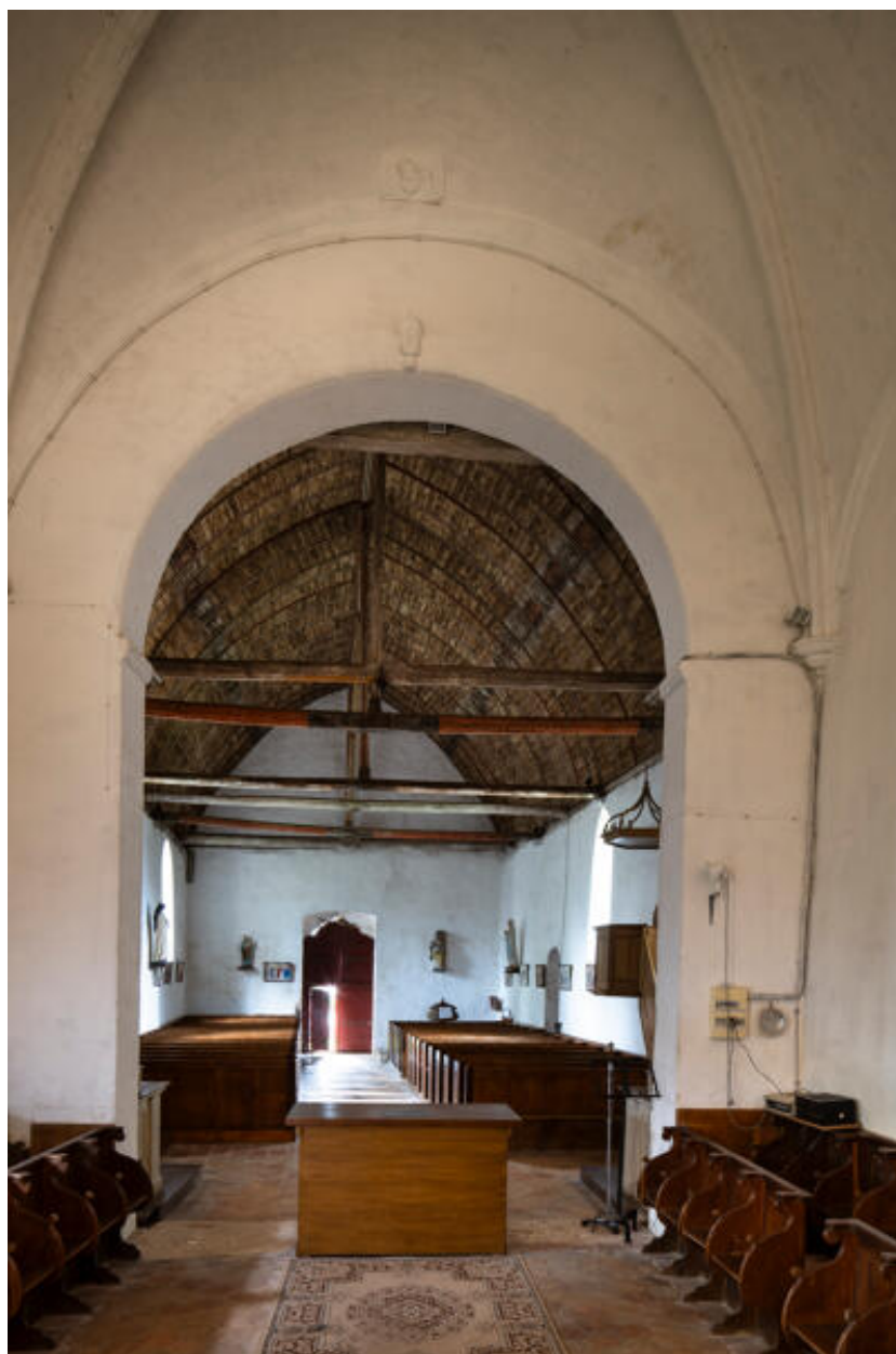
Première travée du choeur et nef.
