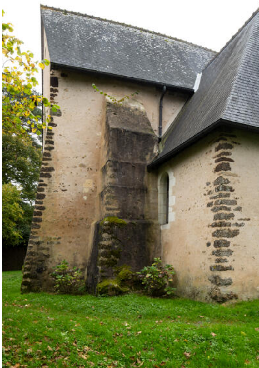
Vue latérale du chevet et de la sacristie.
