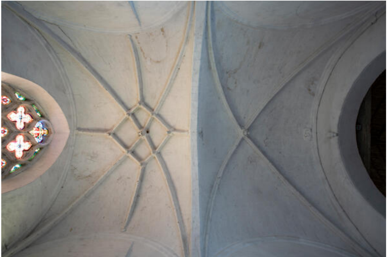
Voûtes du chœur.
