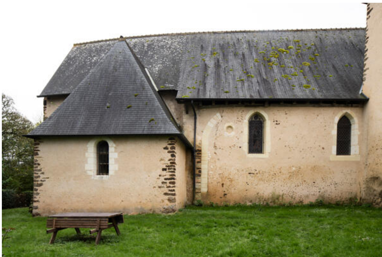
Flanc nord, nef et sacristie.
