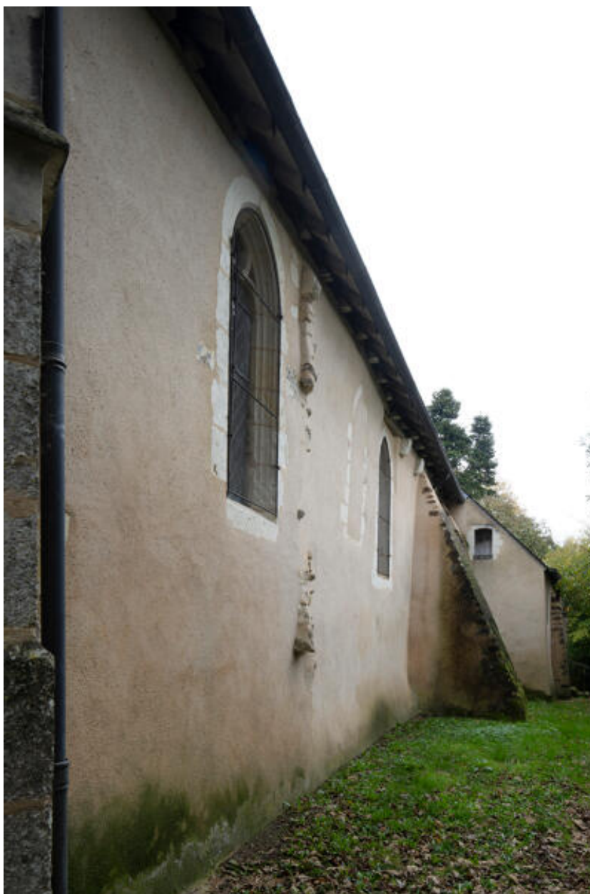
Mur extérieur de la nef côté sud.
