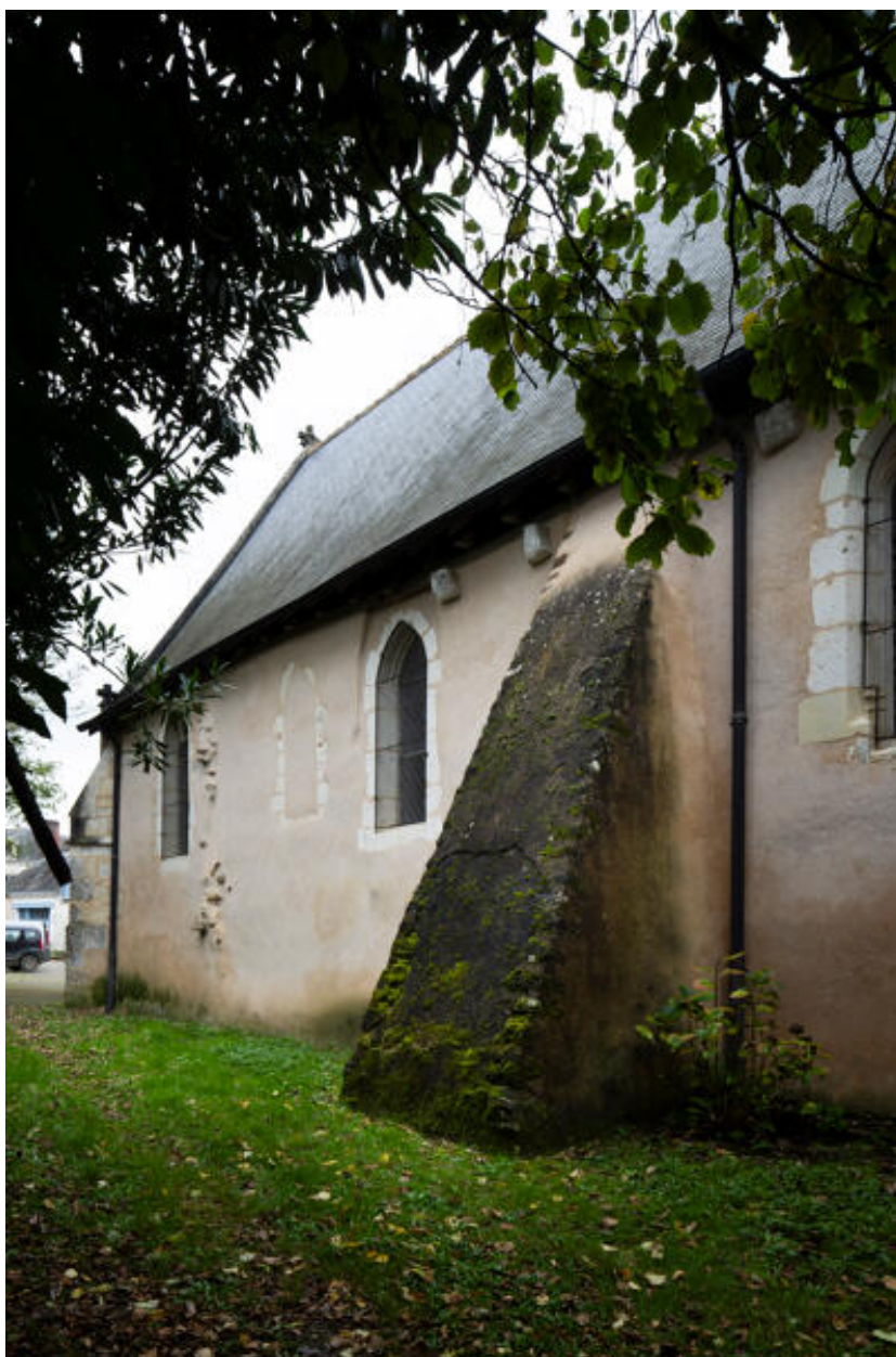
Mur extérieur de la nef côté sud.
