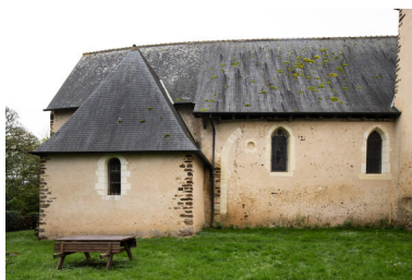
Flanc nord, nef et sacristie. Phot. Thierry Seldubuisson IVR52_20247200382NUCA
