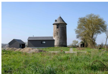
Vue d'ensemble depuis l'est. Phot. Armelle Maugin IVR52_20254900370NUCA
