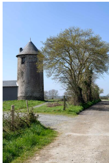
Vue d'ensemble depuis l'est. Phot. Armelle Maugin IVR52_20254900371NUCA
