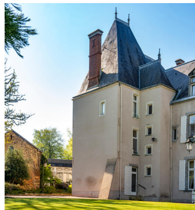
Le pavillon est et sa tour d'escalier. Phot. Pierre-Bernard Fourny IVR52_20225300396NUCA
