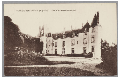
Le château, façade antérieure, carte postale du début du XXe siècle. Repro. Allison Haugmard IVR52_20225300491NUCA
