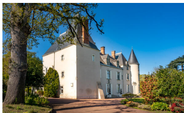
La façade antérieure du château et le pavillon. Phot. Pierre-Bernard Fourny IVR52_20225300400NUCA
