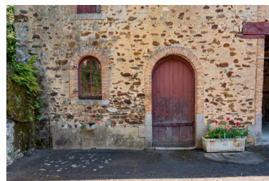
Les communs, détail du four. Phot. Pierre-Bernard Fourny IVR52_20225300405NUCA
