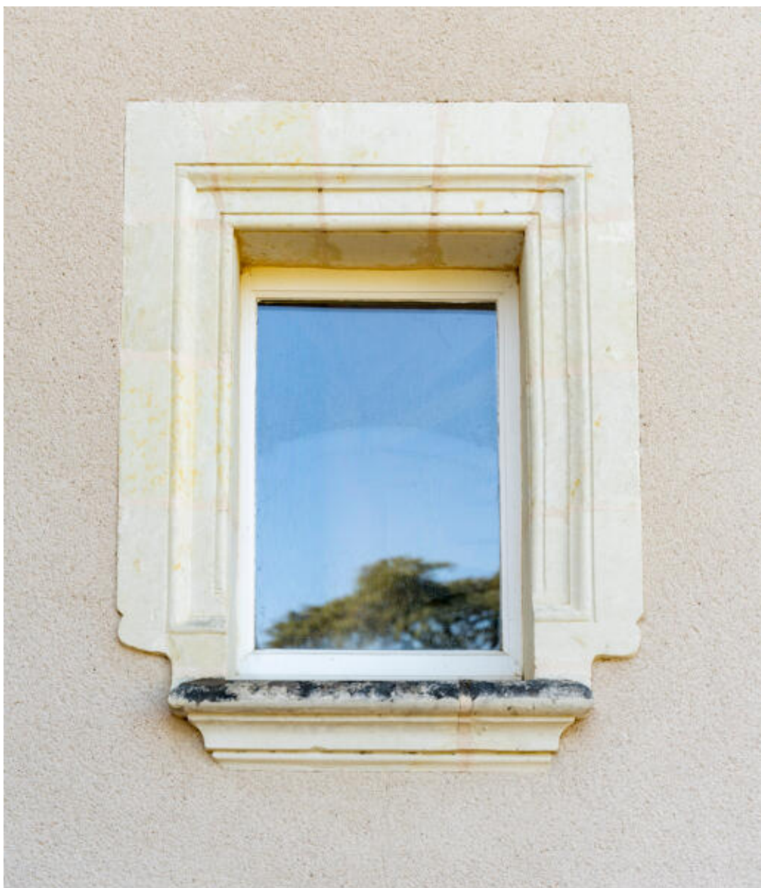
Une fenêtre de la tourelle d'escalier.
