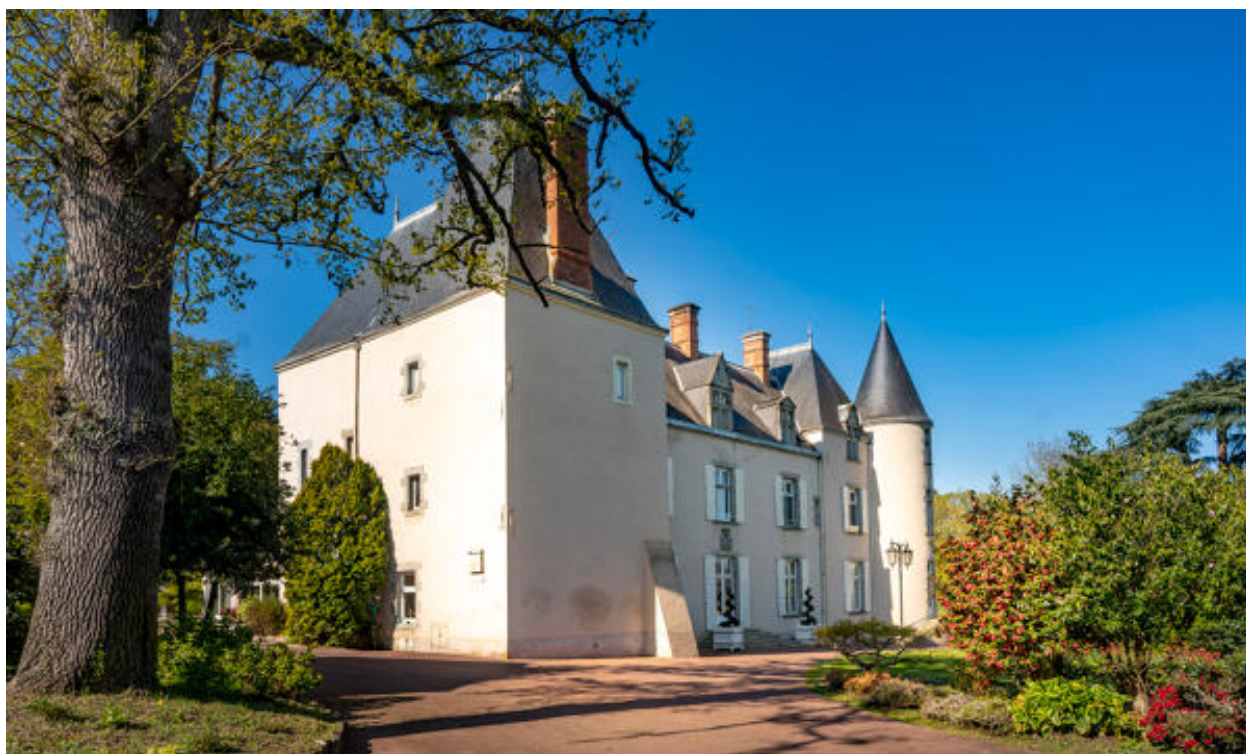
La façade antérieure du château et le pavillon.
