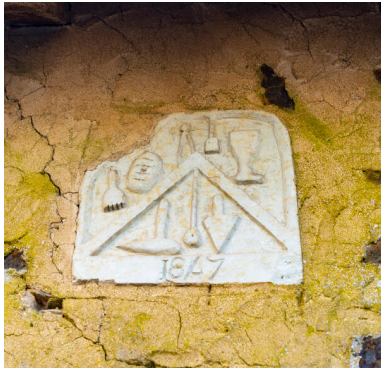
La date portée sur les communs. Phot. Pierre-Bernard Fourny IVR52_20225300403NUCA
