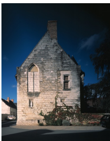
Vue d'ensemble du pignon sud. Phot. Jean-Baptiste Darrasse IVR52_20047205879VA
