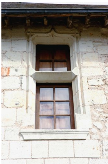
Demi-baie sur la rue. Phot. David Huard IVR52_20047205587NUCA
