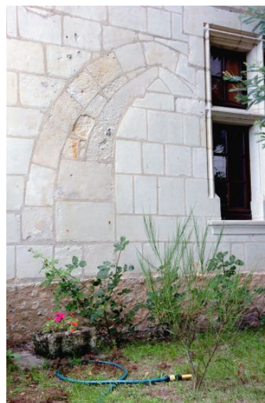
Baie brisée bouchée. Phot. David Huard IVR52_20047205585NUCA
