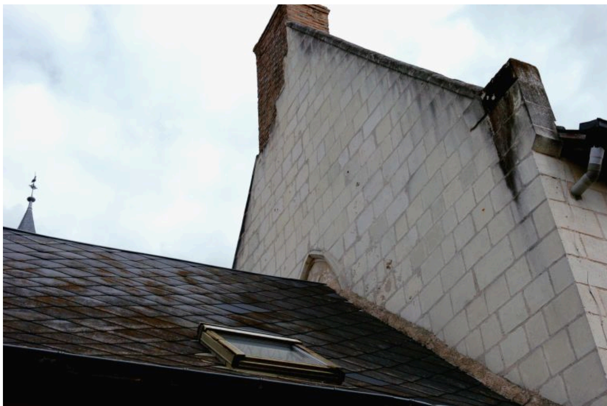
Pignon nord : vestiges d'une baie dans le pignon.
