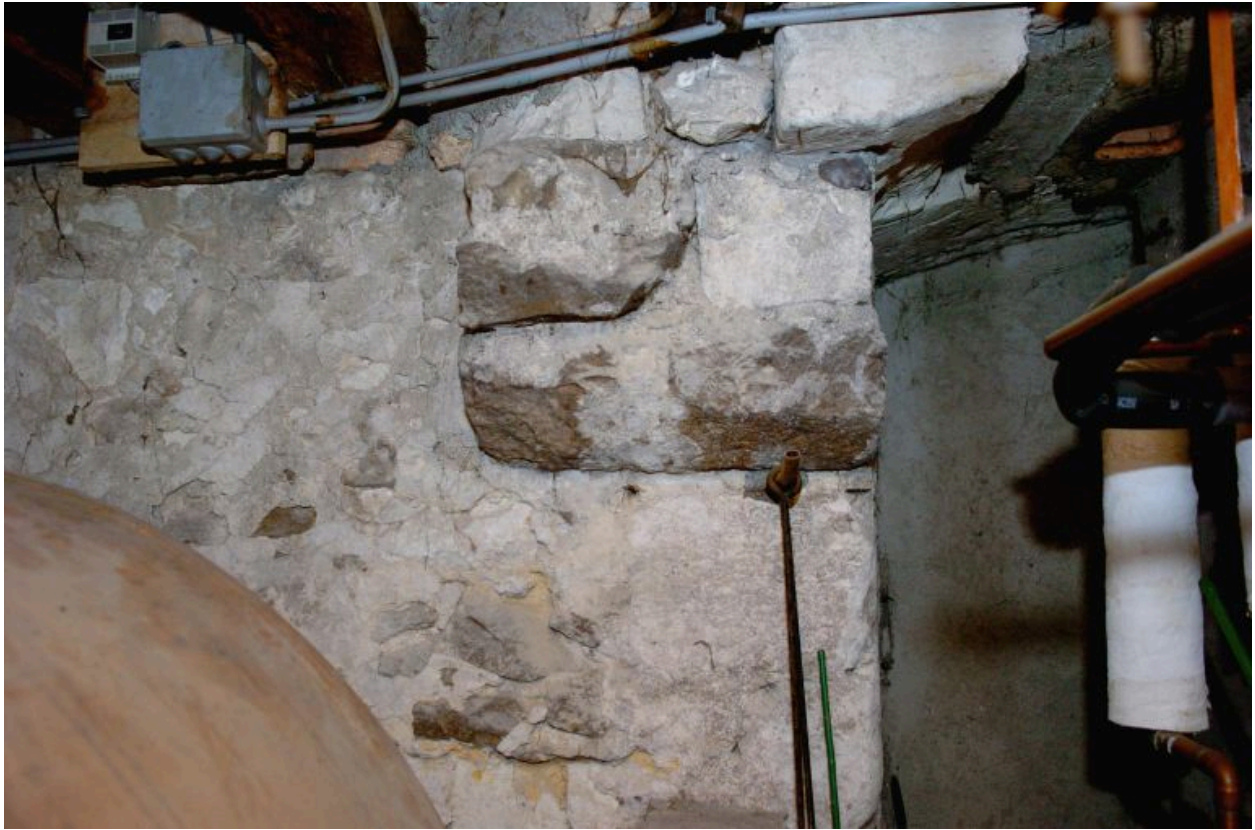
Sous-sol : vestiges d'un corbeau.
