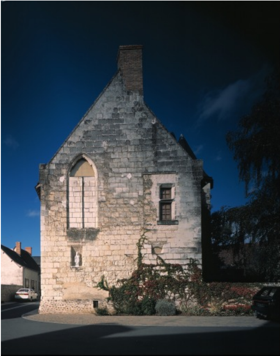
Vue d'ensemble du pignon sud.
