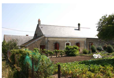
Ferme n°1 : maison d'habitation 1 qui tourne le dos à la cour. Phot. Jean-Baptiste Darrasse IVR52_20067206435NUCA
