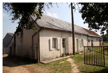
Ferme n°2 : maison d'habitation n°6. Phot. Jean-Baptiste Darrasse IVR52_20067206452NUCA
