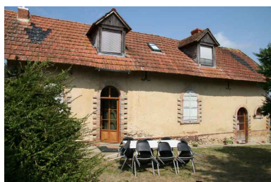
Maison n°5 de garde de la Roltièrre : façade antérieure. Phot. Jean-Baptiste Darrasse IVR52_20067206446NUCA
