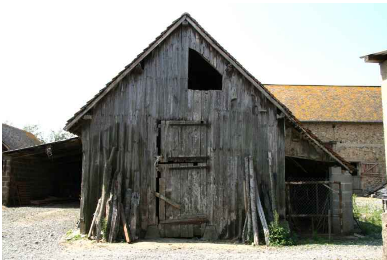
Ferme n°1 : hangar en bois.
