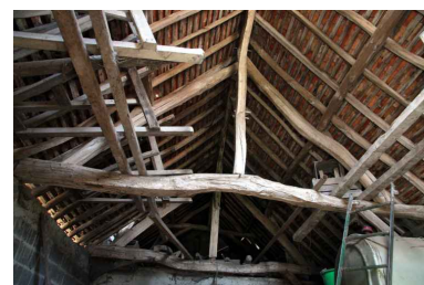
Ferme n°1, le hangar : charpente. Phot. Jean-Baptiste Darrasse IVR52_20067206440NUCA
