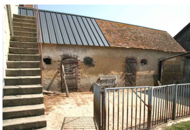
Ferme n°1 : toits à porcs. Phot. Jean-Baptiste Darrasse IVR52_20067206438NUCA
