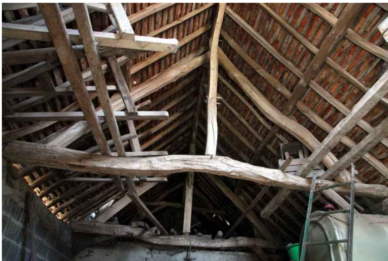
Ferme n°1, le hangar : charpente.
