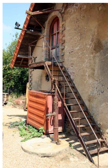
Maison n°5 du garde de la Roltièrre : pignon avec l'échelle pour le grenier. Phot. Jean-Baptiste Darrasse IVR52_20067206449NUCA
