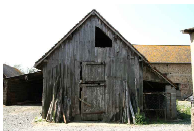
Ferme n°1 : hangar en bois. Phot. Jean-Baptiste Darrasse IVR52_20067206439NUCA
