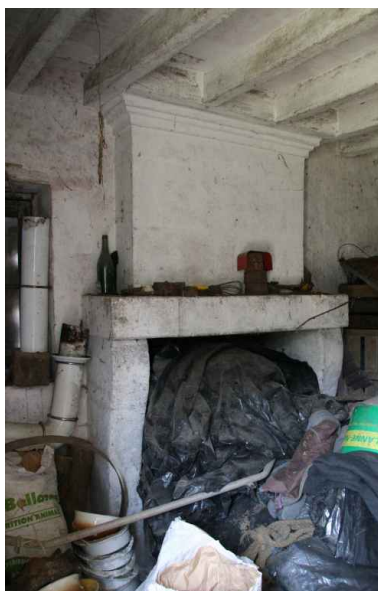
Ferme n°2, dépendance 1 : chambre à feu. Phot. Jean-Baptiste Darrasse IVR52_20067206456NUCA
