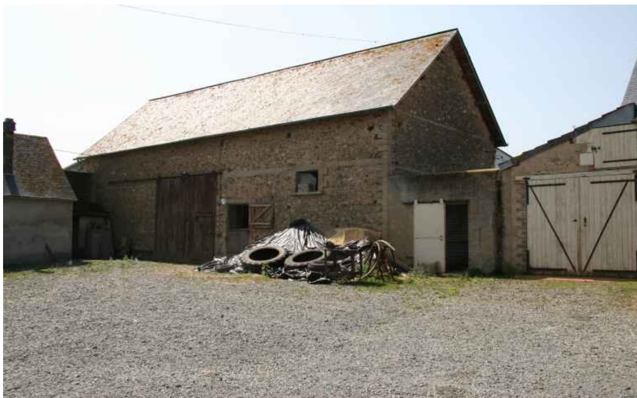
Ferme n°1 : grange en moellons de silex et parpaings.
