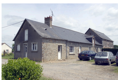
Le logis et l'étable à chevaux. Phot. François Lasa IVR52_20045301766NUCA
