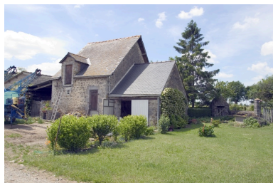
L'élévation est de la porcherie et le puits. Phot. François Lasa IVR52_20045301768NUCA
