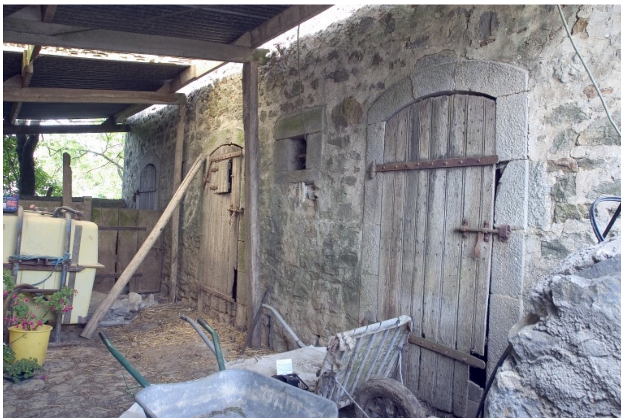
L'élévation sud de la porcherie : les portes des sous.
