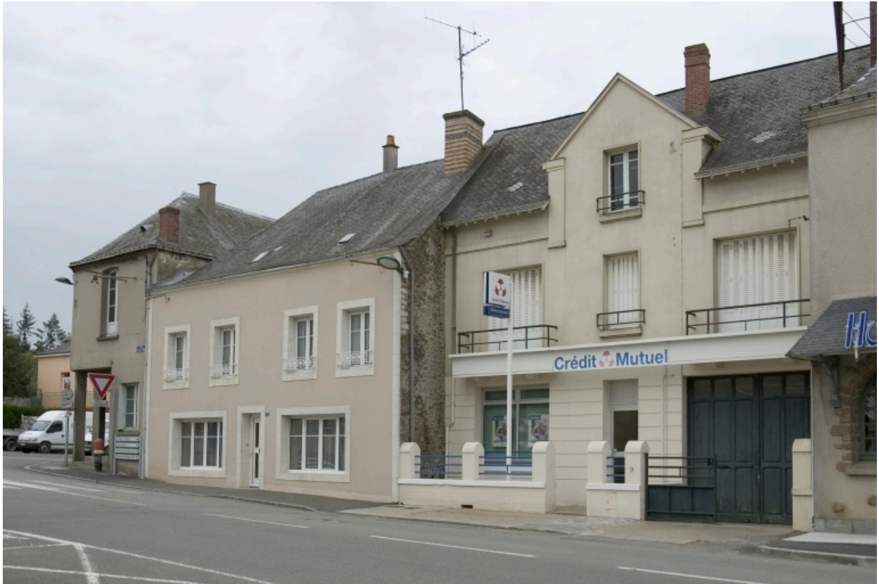
Vue depuis la rue du Fief-aux-Moines. La maison est à gauche.
