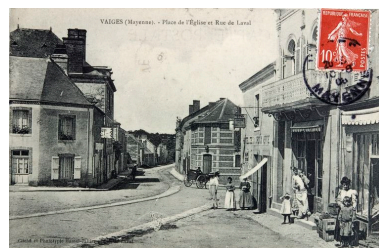
Carte postale, avant 1908. Vue depuis la place de l'église. La maison est au centre. Autr. Désiré et Henriette Hamel-Jallier, Repro. François Lasa IVR52_20045302994NUCA
