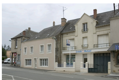
Vue depuis la rue du Fief-aux-Moines. La maison est à gauche. Phot. François Lasa IVR52_20045303341NUCA
