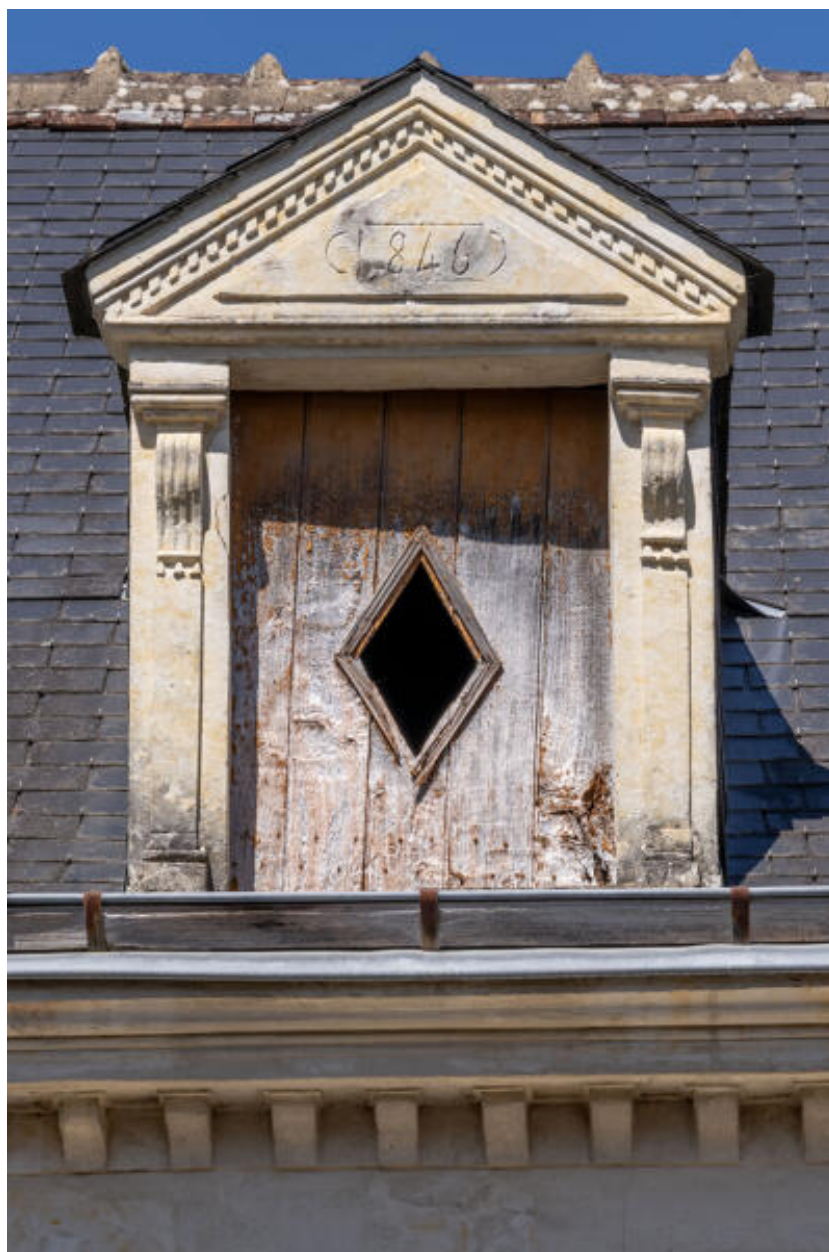
Lucarne avec date portée, logis de ferme, 3 rue de la Petite Fontaine.
