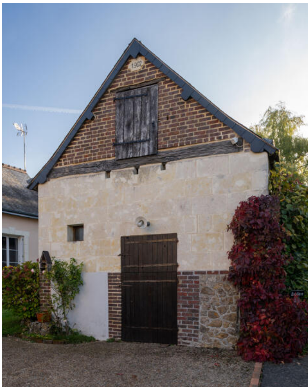
Pignon en pierre de taille calcaire et brique belge, étable, la Davilière.
