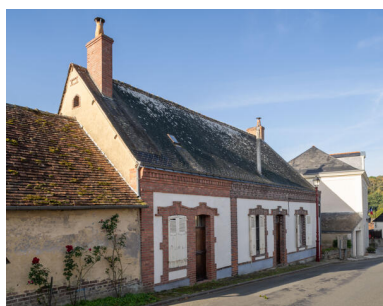
Décor de frise et corniche en brique, façade de maison, 13 rue de la Petite Fontaine.
