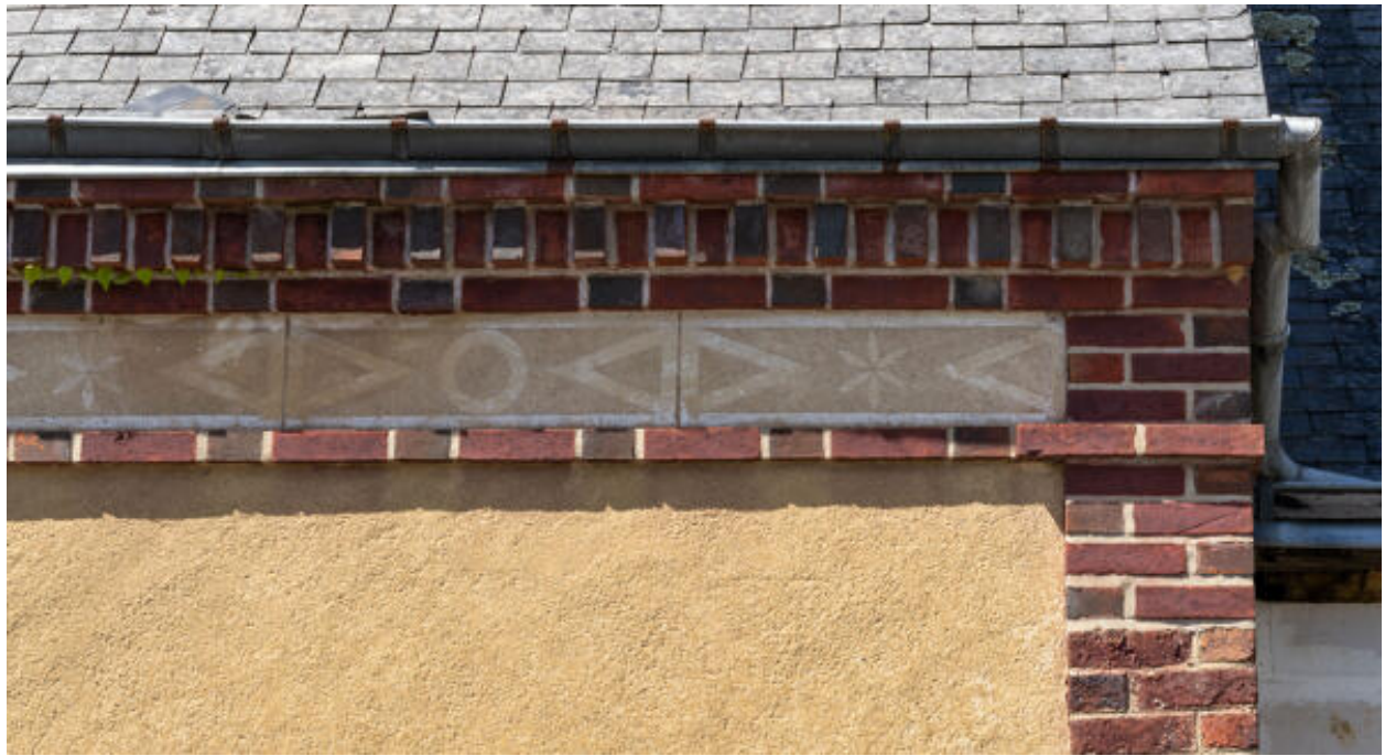
Décor de frise et corniche en brique, façade de maison, 13 rue de la Petite Fontaine.
