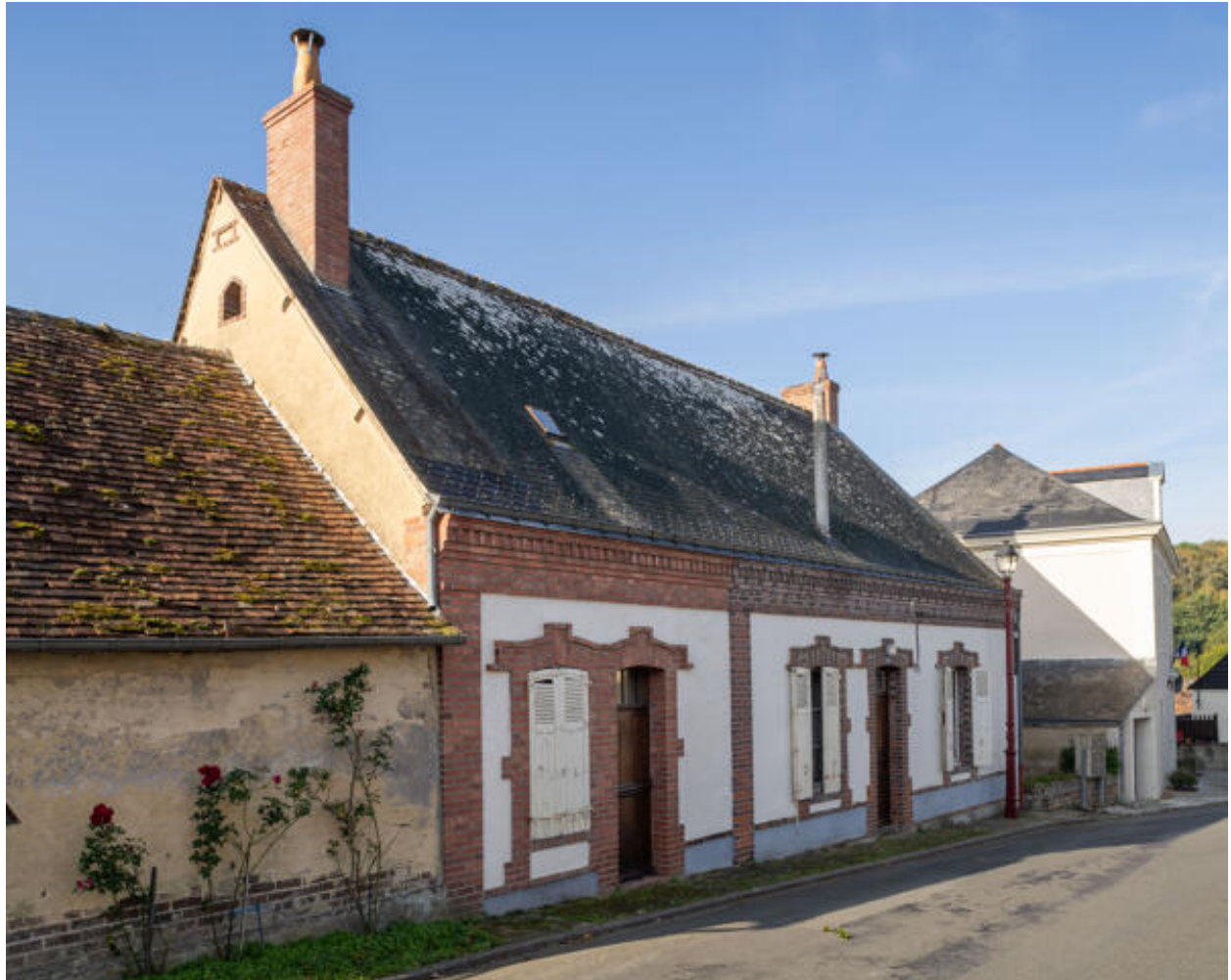
Maison, 10 rue de la Petite Fontaine.
