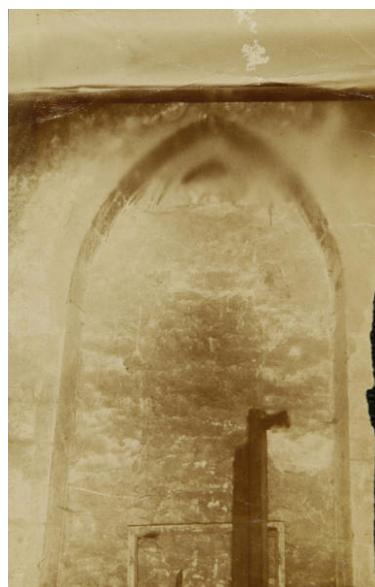
Le bâtiment conventuel, photographie du milieu du XXe siècle. Repro. Morgane Acou-Le Noan IVR52_20215300181NUCA
