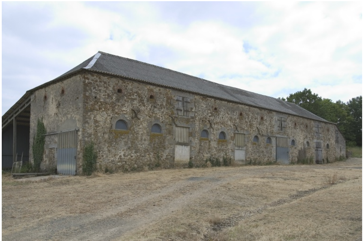
L'étable-grange vue depuis le nord-est.
