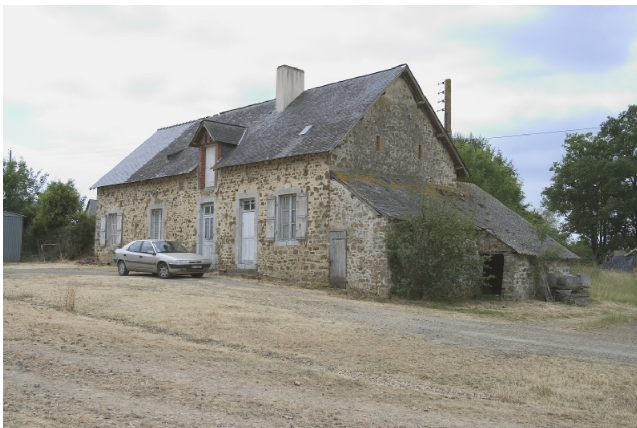
Le logis vu depuis le nord-est.
