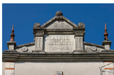
Détail du fronton de l'élévation antérieure.
