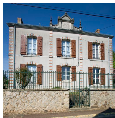
Élévation principale du logis et mairie. Phot. Yves Guillotin IVR52_20117200499NUCA
