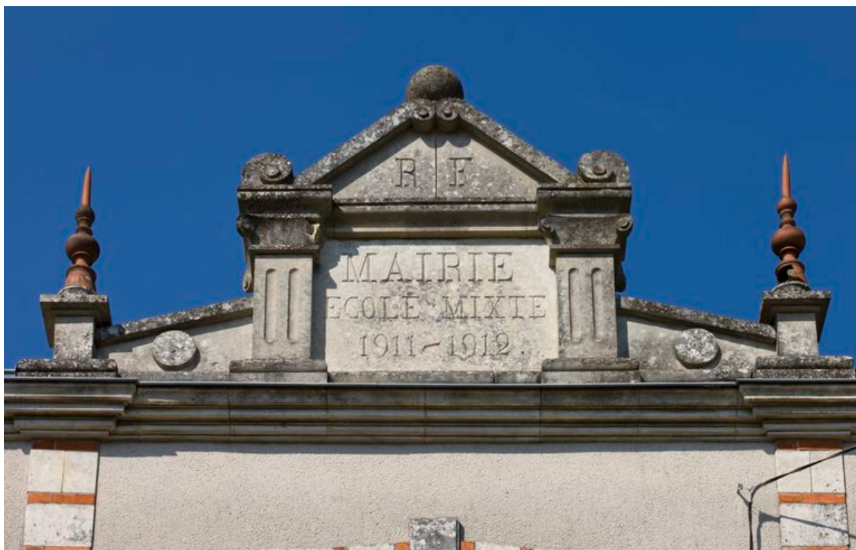
Détail du fronton de l'élévation antérieure.
