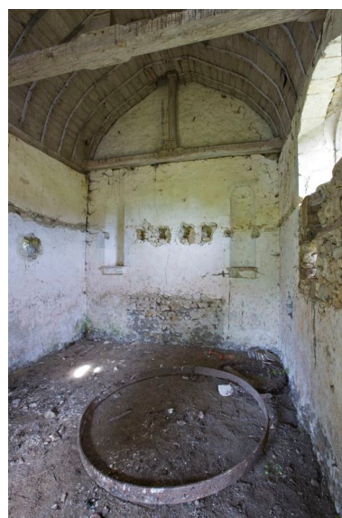
Vue intérieure depuis l'entrée Phot. Yves Guillotin IVR52_20117200693NUCA
