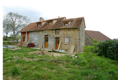
Le logis du XIXe siècle vu depuis le sud. Phot. François Lasa IVR52_20035301430NUCA
