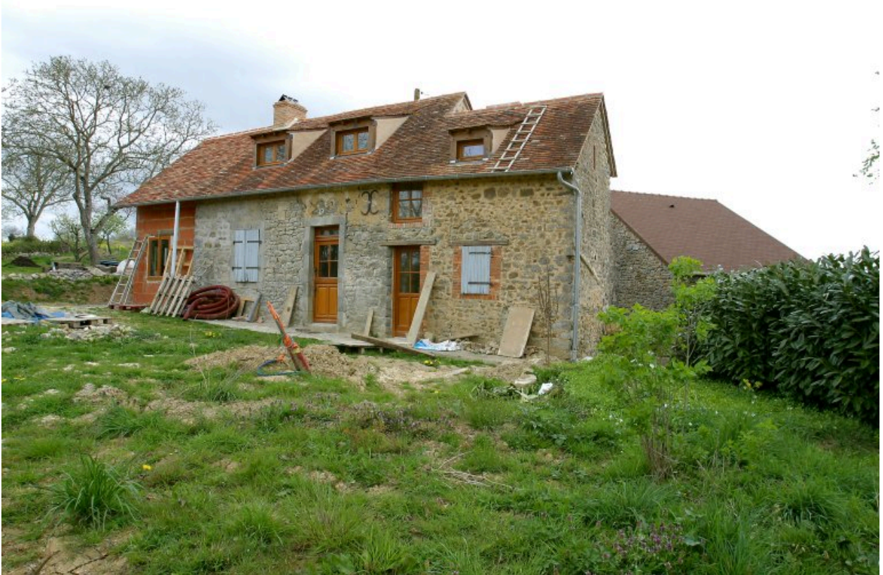
Le logis du XIXe siècle vu depuis le sud.
