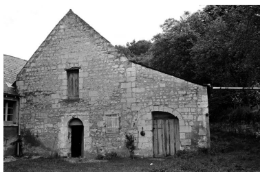
Grange, vue générale en 1979. Phot. Dominique Eraud IVR52_19794902218Z
