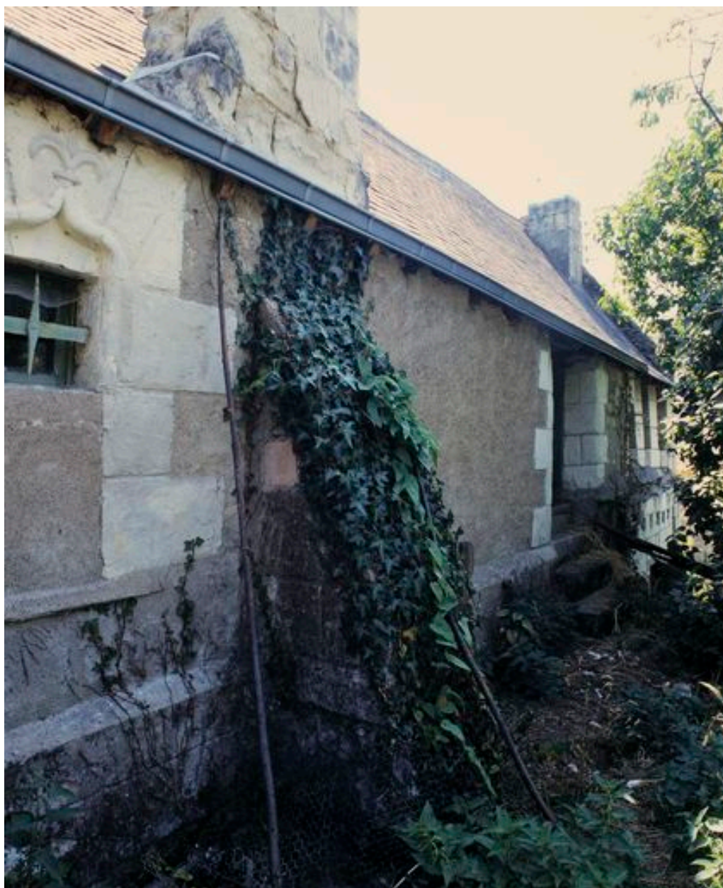
Façade nord de l'ancienne boucherie.
