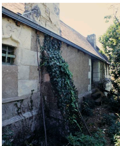
Façade nord de l'ancienne boucherie.
