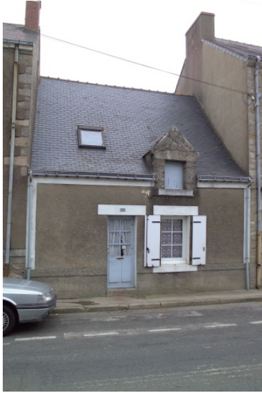
Vue de la façade sur rue. Phot. Denis Pillet IVR52_20074400127NUCA
