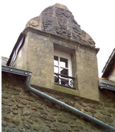
Partie arrière dans la rue du Saint-Esprit, détail de la lucarne. Phot. Denis Pillet IVR52_20074400385NUCA
