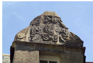
Partie arrière dans la rue du Saint-Esprit, détail de la lucarne. Phot. Denis Pillet IVR52_20074400740NUCA
