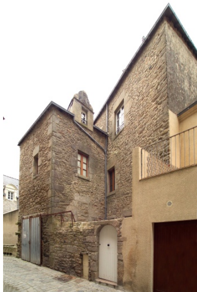
Vue de la partie arrière dans la rue du Saint-Esprit. Phot. Denis Pillet IVR52_20074400384NUCA
