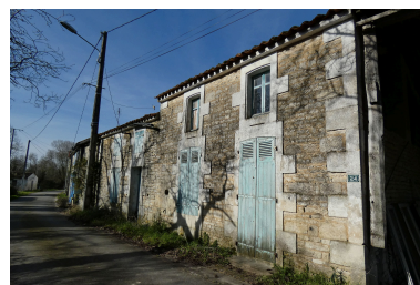
Le logis et ses deux parties, vus depuis le sud-est. Phot. Yannis Suire IVR52_20238500700NUCA
