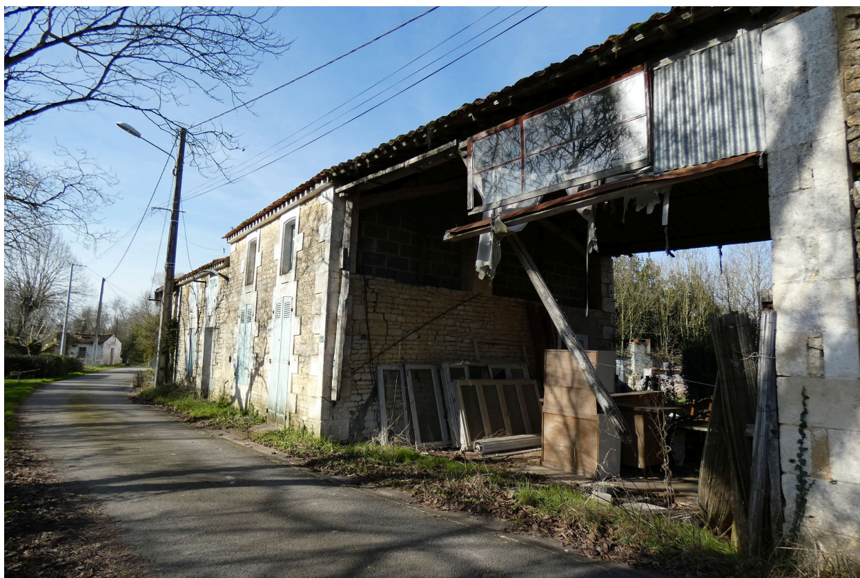
Le logis et le hangar vus depuis le sud-est.
