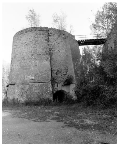
Four à chaux de l'Union, au dessus de l'ébraisoir solin et arrachements
