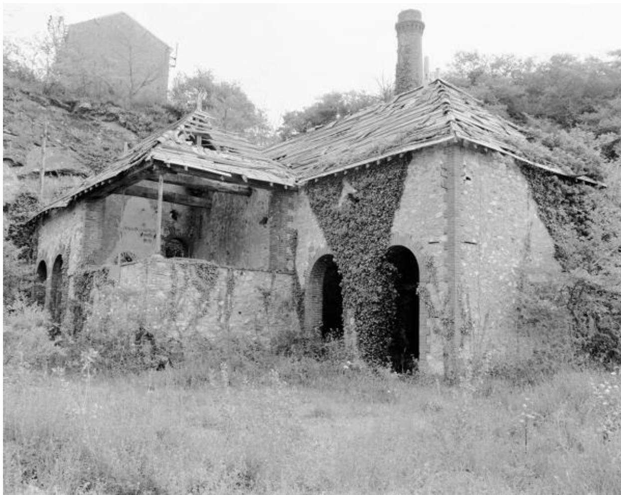
Bâtiments de la machine et du treuil de la carrière (parcelle 128), faces ouest et sud, Maison-Blanche, Montjean-sur-Loire.
