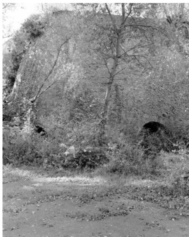
Face nord du four à chaux de Jalousie, Maison-Blanche, Montjean-sur-Loire. Phot. Bruno Rousseau IVR52_19854901703X
