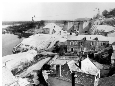
Vue d'ensemble de la chauxfournerie depuis l'ouest, Maison-Blanche, Montjean-sur-Loire. Cliché de Valentin Laroute, vers 1920, collection privée de Maurice Chrétien. Phot. Bruno Rousseau IVR52_19864900585X
