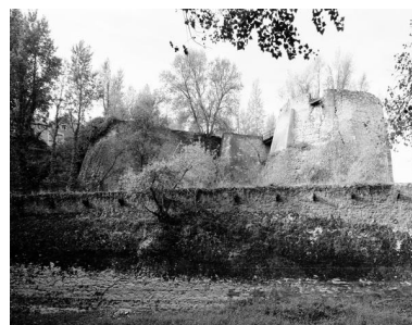
Four en tour avec contreforts, vue d'ensemble depuis le nord-est, au premier plan, quai bordant le ruisseau du Petit-Fourneau, au second plan, à droite le four de l'Union, à gauche
