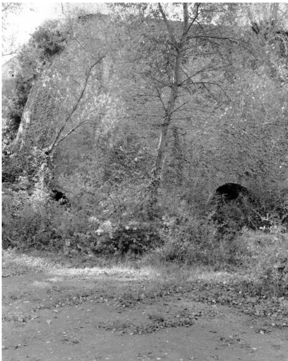
Face nord du four à chaux de Jalousie, Maison-Blanche, Montjean-sur-Loire.
