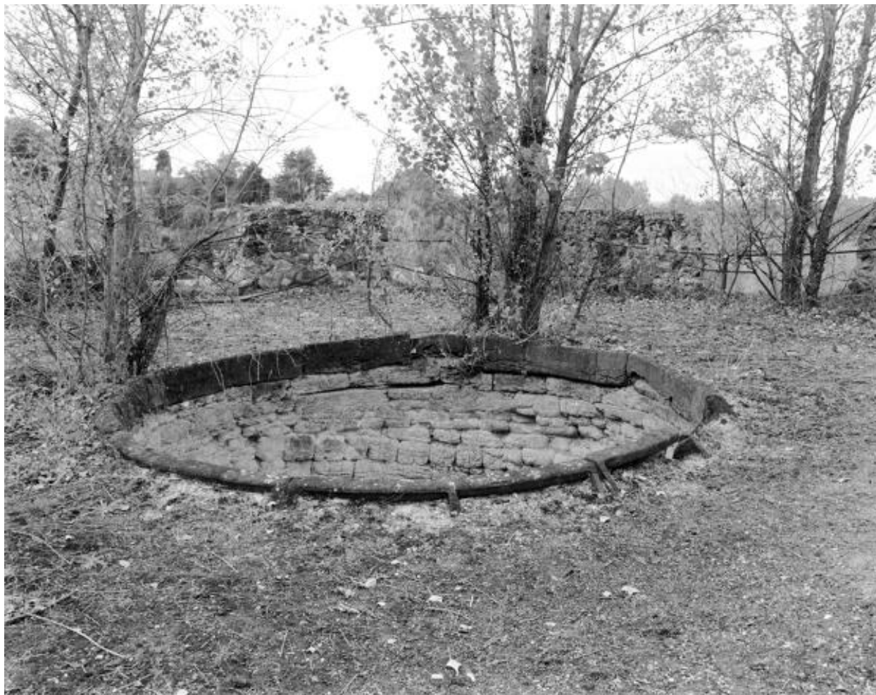
Cerclage de gueulard en fonte, plate-forme du massif, four à chaux de Clermont depuis l'est, Maison-Blanche, Montjean-sur-Loire.
