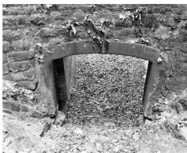
Four à chaux de la Jalousie, porte de déchargement est, vue depuis l'intérieur de la chambre de combustion, Maison- Blanche, Montjean-sur-Loire. Phot. Bruno Rousseau IVR52_19854901712X
