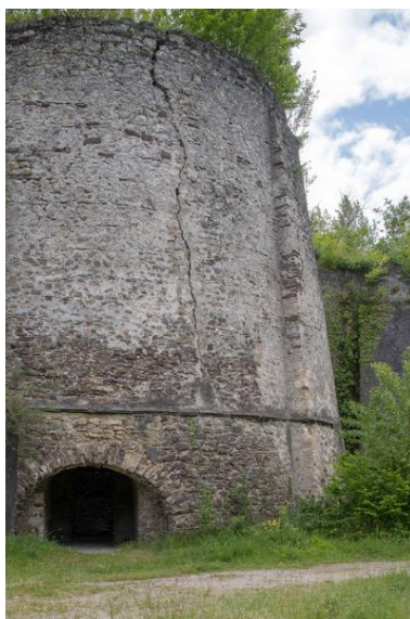
Four à chaux de l'Union, vue depuis le nord, au-dessus de l'ébraisoir solin, vestiges de la chambre de compression (système Bied), Maison-Blanche, Montjean-sur-Loire.
