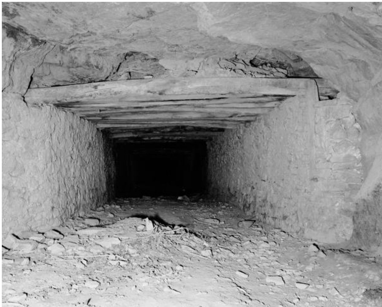
Tunnel reliant la carrière aux fours à chaux, vue intérieure du sud vers le nord, Maison-Blanche, Montjean-sur-Loire.
