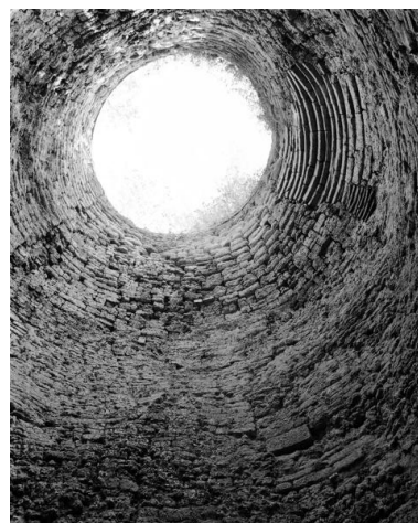
Chambre de combustion du four à chaux de Jalousie, vue verticale de bas en haut, Maison- Blanche, Montjean-sur-Loire. Phot. Bruno Rousseau IVR52_19854901711X
