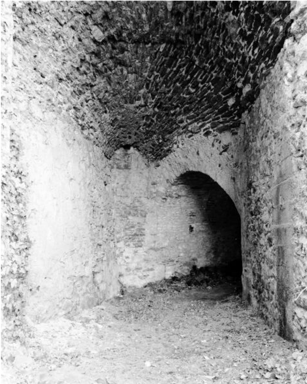
Four à chaux de Clermont, couloir d'accès à l'ébraisoir est, pénétrant dans le massif construit entre 1829 et 1845. Au fond, à gauche de l'ébraisoir, parement de l'ancien massif, antérieur à 1829. Maison-Blanche, Montjean-sur-Loire.
