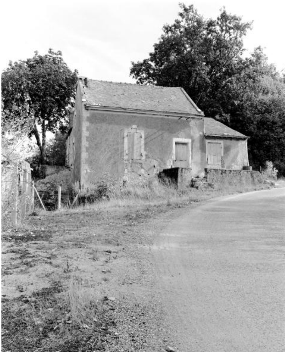
Plateforme sud située au-dessus des fours à chaux (parcelle 121), maison du contremaître de Châteaupanne, Maison-Blanche, Montjean-sur-Loire.
