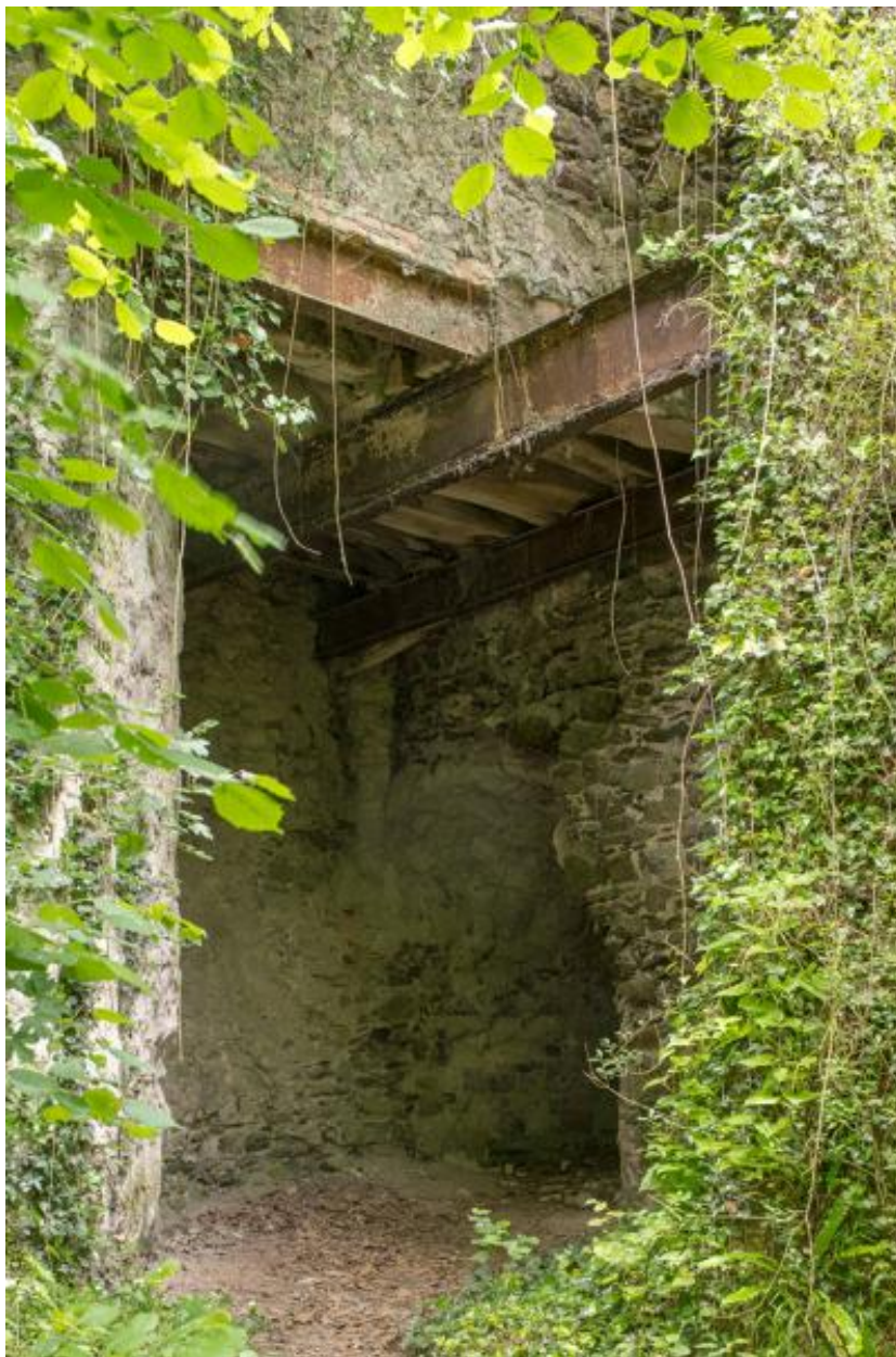
Détail d'une structure du site chaufournier de Châteaupanne, Montjean-sur-Loire.
