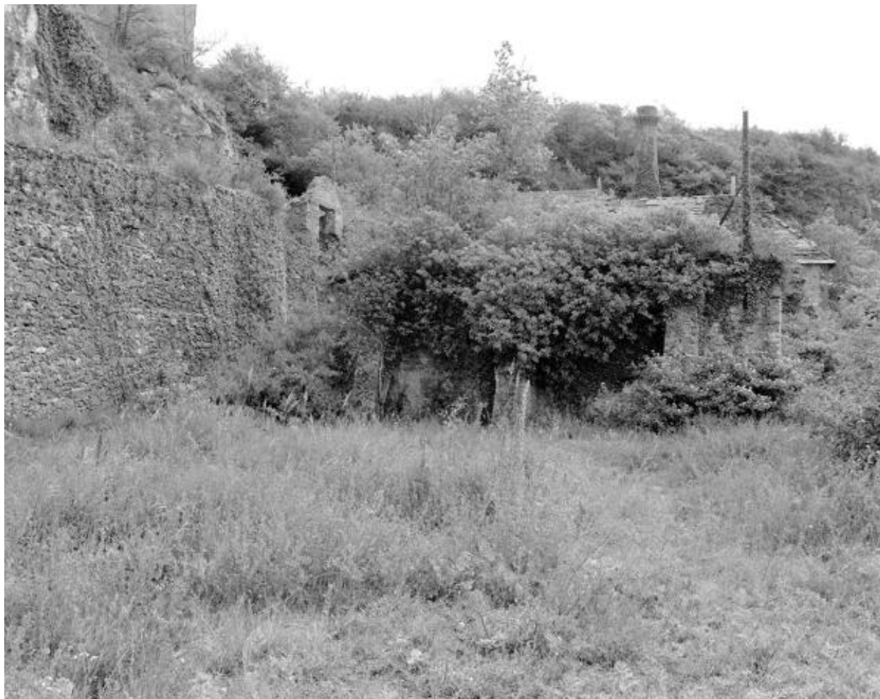
Bâtiments de la machine et du treuil de la carrière (parcelle 128), vue d'ensemble depuis l'ouest, Maison-Blanche, Montjean-sur-Loire.
