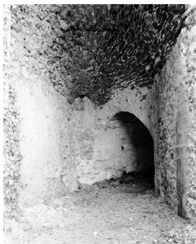
Four à chaux de Clermont, couloir d'accès à l'ébraisoir est, pénétrant dans le massif construit entre 1829 et 1845. Au fond, à gauche de l'ébraisoir, parement de l'ancien massif, antérieur à 1829. Maison-Blanche, Montjean-sur-Loire. Phot. Bruno Rousseau IVR52_19854901708X
