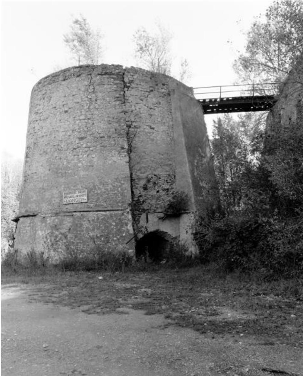
Four à chaux de l'Union, au dessus de l'ébraisoir solin et arrachements métalliques, vestiges de la chambre de compression (système Bied), Maison-Blanche, Montjean-sur-Loire.
