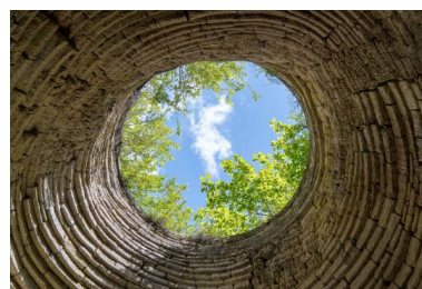
Chambre de combustion du four à chaux de Jalousie, vue verticale de bas en haut, Maison- Blanche, Montjean-sur-Loire. Phot. Armelle Maugin IVR52_20194900835NUCA
