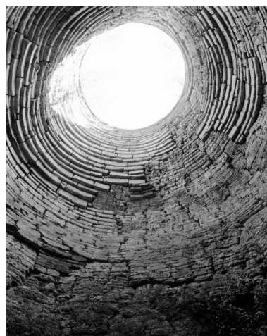
Four à chaux de Clermont, intérieur de la chambre de combustion, vue verticale de bas en haut, robe en pierre de Saint Pierre du Chemin, Maison-Blanche, Montjean-sur-Loire. Phot. Bruno Rousseau IVR52_19854901709X
