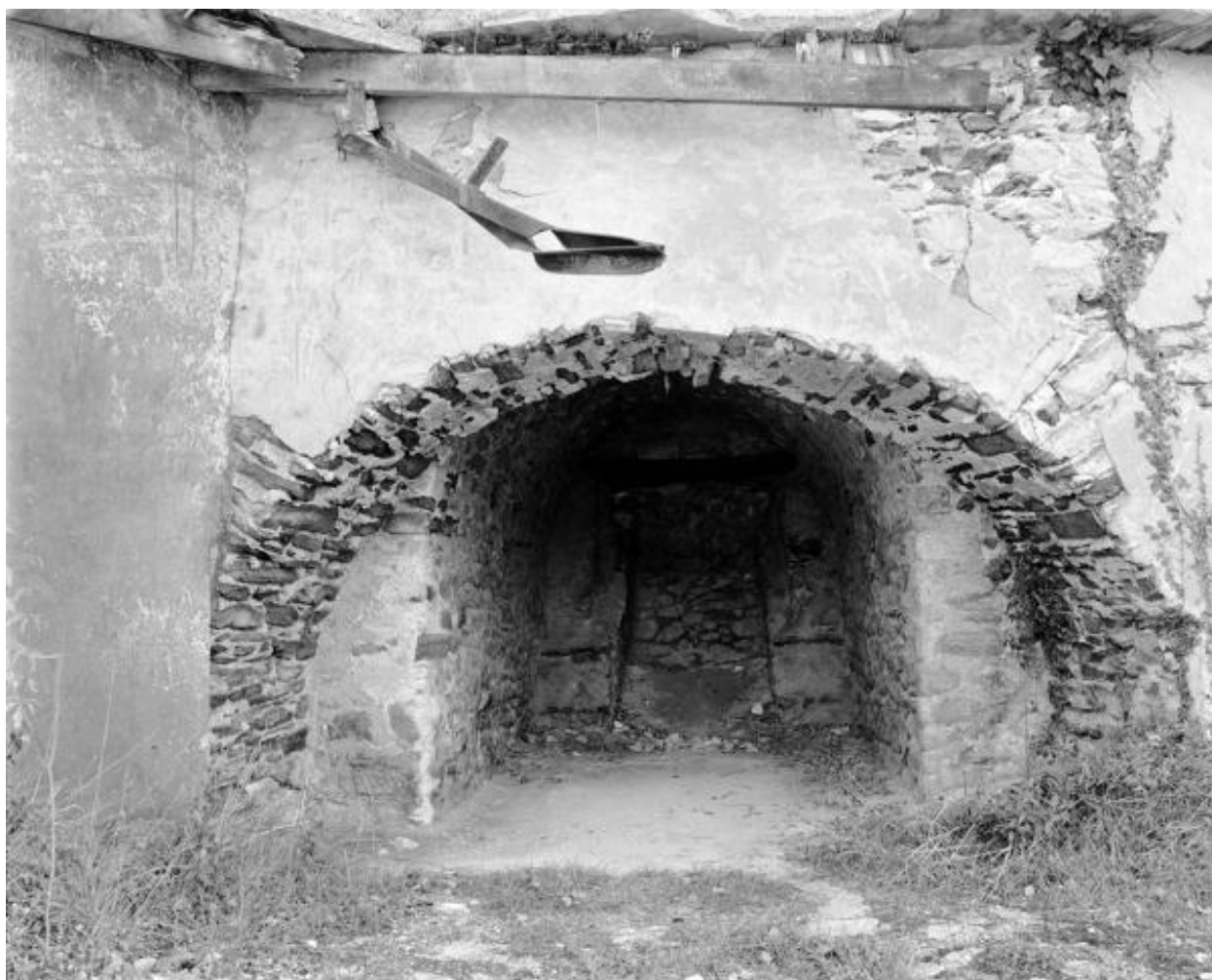
Four à chaux de l'Union, ébraisoir nord, Maison-Blanche, Montjean-sur-Loire.
