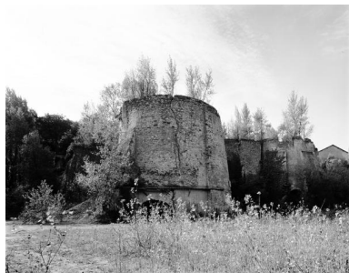
Vue d'ensemble du site depuis le nord, au centre le four à chaux de l'Union, à droite le four à chaux de Clermont, Maison-Blanche, Montjean-sur-Loire. Phot. Bruno Rousseau IVR52_19854901752V
