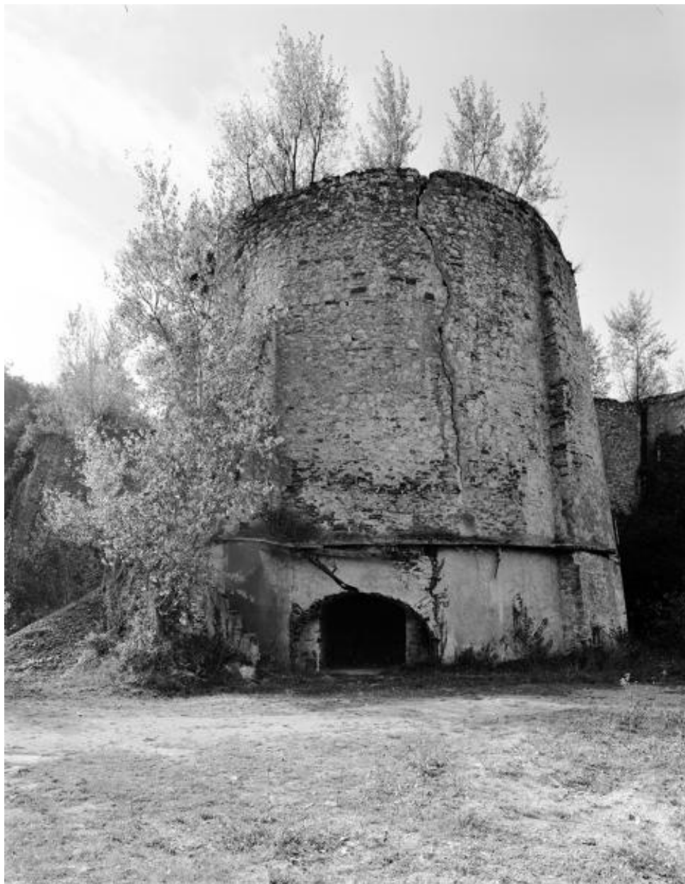
Four à chaux de l'Union, vue depuis le nord, au-dessus de l'ébraisoir, solin et arrachements métalliques, vestiges de la chambre de compression (système Bied), Maison-Blanche, Montjean-sur-Loire.
