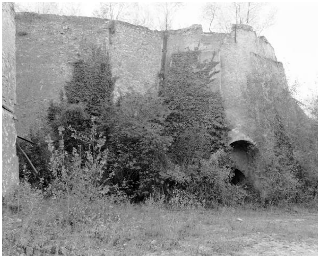
Four à chaux de Clermont, face nord-est et partie ouest du massif joignant Clermont au four à chaux de Jalousie, Maison-Blanche, Montjean-sur-Loire.
