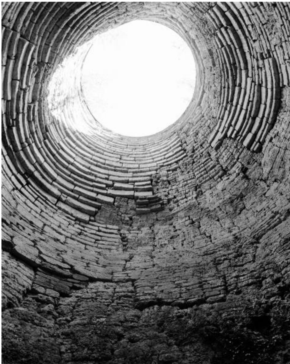
Four à chaux de Clermont, intérieur de la chambre de combustion, vue verticale de bas en haut, robe en pierre de Saint Pierre du Chemin, Maison-Blanche, Montjean-sur-Loire.
