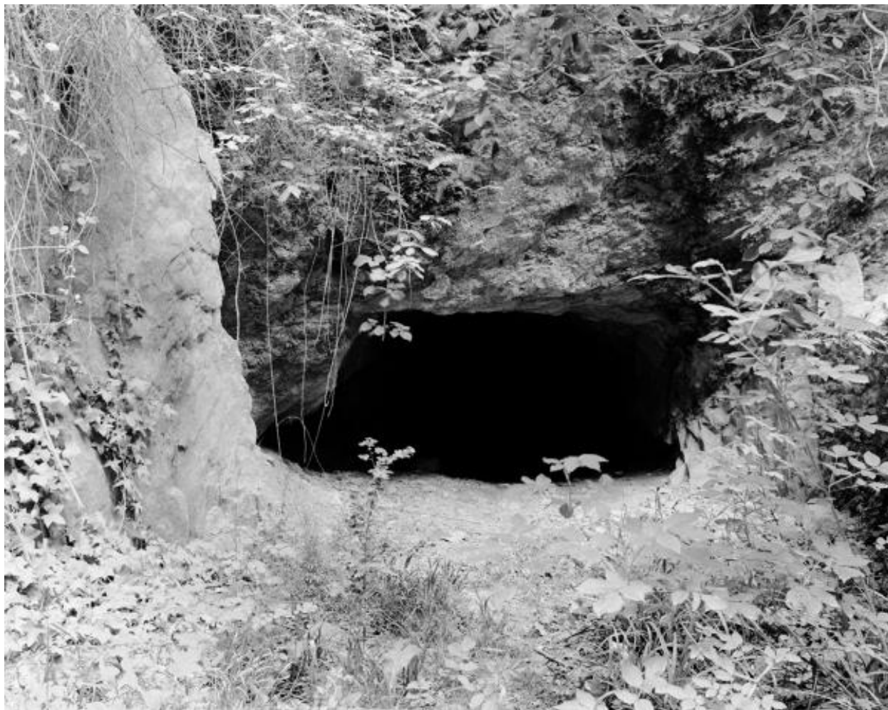
Entrée du tunnel partant de la carrière vers les fours à chaux, vue depuis le sud, Maison-Blanche, Montjean-sur-Loire.
