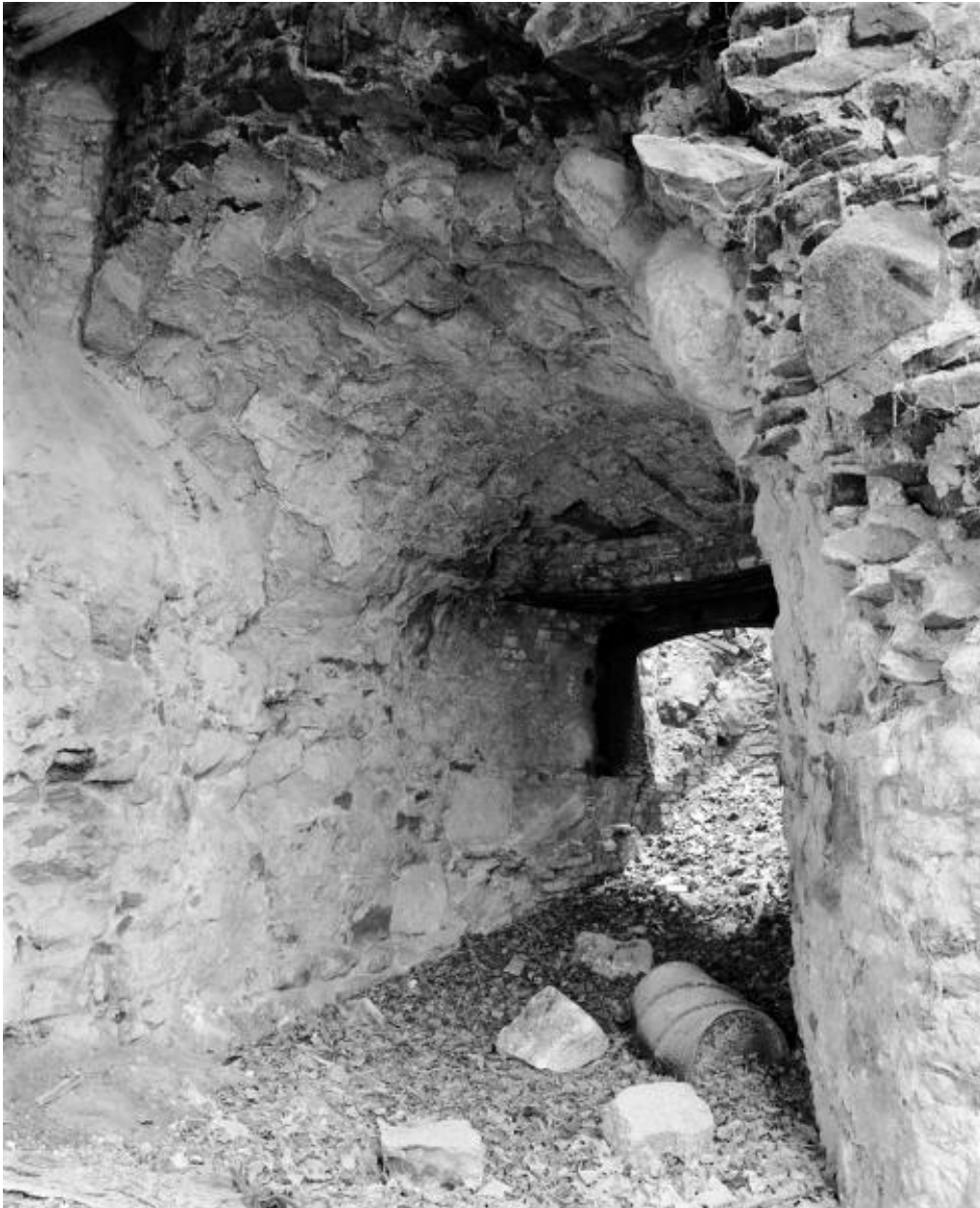
Ebraisoir sud-est du four à chaux de Jalousie, Maison-Blanche, Montjean-sur-Loire.
