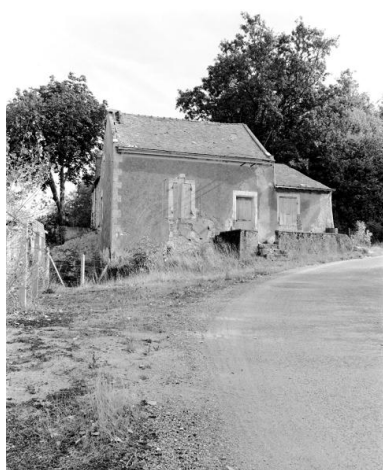
Plateforme sud située au-dessus des fours à chaux (parcelle 121), maison du contremaître de Châteaupanne, Maison-Blanche, Montjean-sur-Loire.
