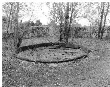
Cerclage de gueulard en fonte, plate- forme du massif, four à chaux de Clermont depuis l'est, Maison- Blanche, Montjean-sur-Loire. Phot. Bruno Rousseau IVR52_19854901718X
