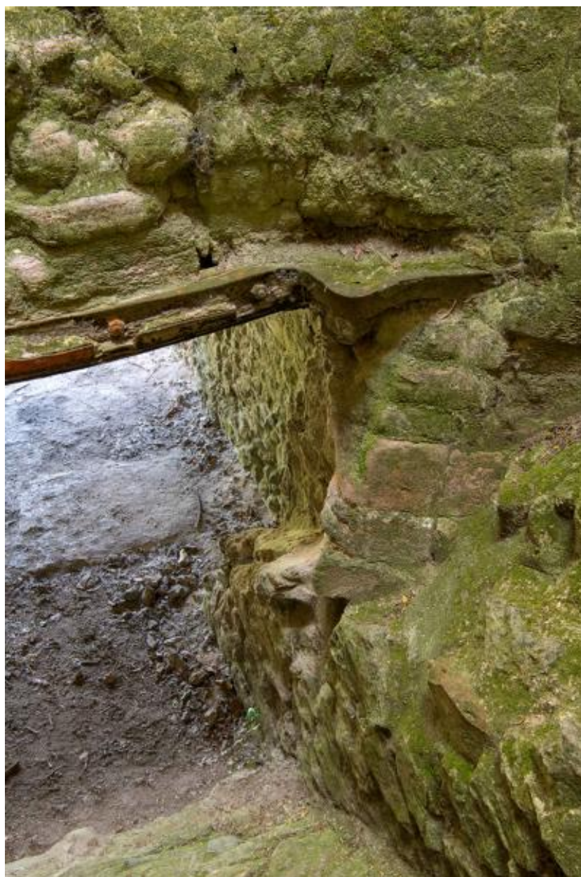
Ebraisoir, four à chaux de Jalousie, Maison-Blanche, Montjean-sur-Loire.
