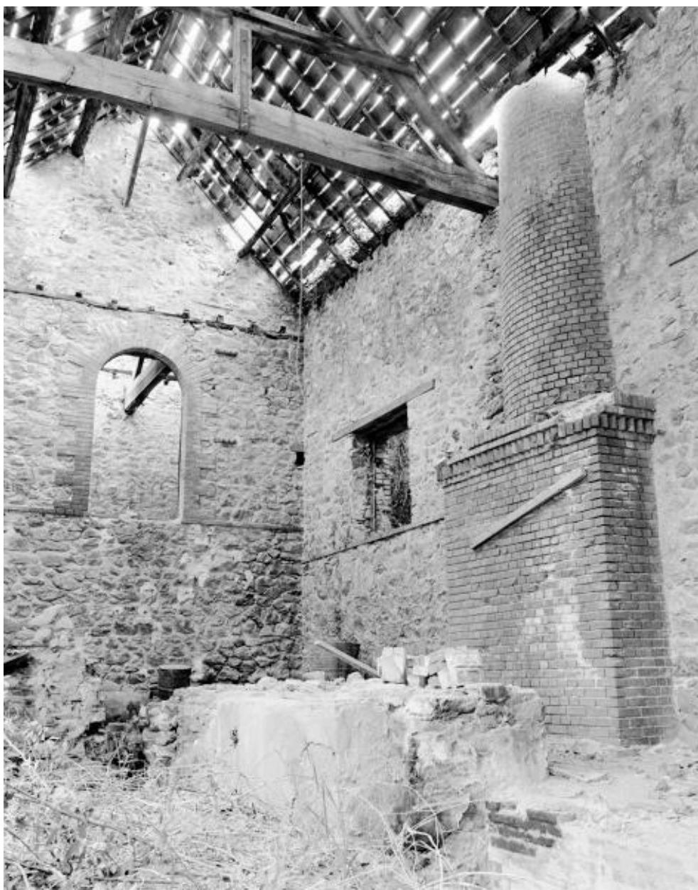
Bâtiments de la machine et du treuil de la carrière, bâtiment est, vue intérieure, Maison-Blanche, Montjean-sur-Loire.
