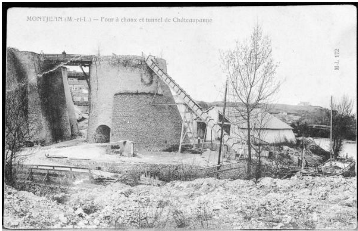
Au premier plan, cale du ruisseau du Petit-Fourneau, four de l'Union et au second plan, la passerelle du four Saint-Hubert. Four à chaux et tunnel de Châteaupanne, Maison-Blanche, Montjean-sur-Loire. Carte postale, ML 172, photographie du début du XXème siècle (avant 1911), collection privée.
