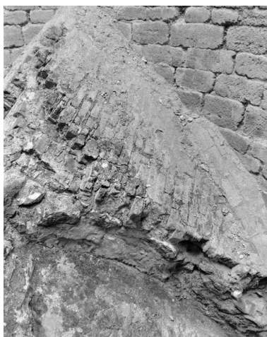
Four à chaux de Clermont, intérieur de la chambre de combustion, éperon sud de la sole, Maison-Blanche, Montjean-sur-Loire. Phot. Bruno Rousseau IVR52_19854901706X
