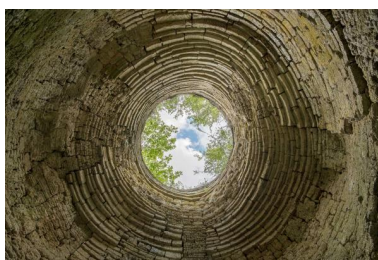
Chambre de combustion du four à chaux de Jalousie, vue verticale de bas en haut, Maison- Blanche, Montjean-sur-Loire. Phot. Armelle Maugin IVR52_20194900838NUCA
