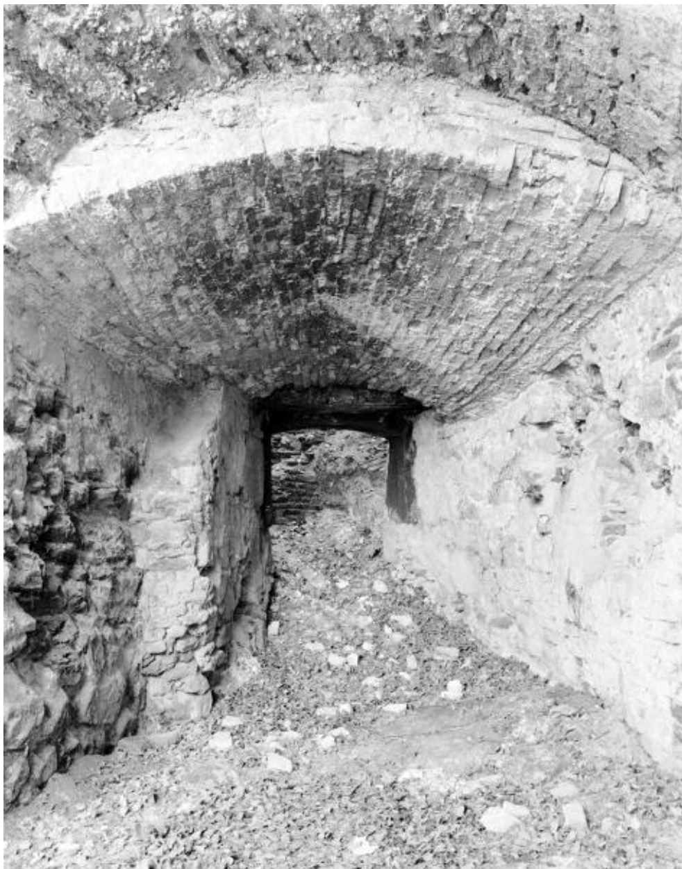
Ebraisoir nord du four à chaux de la Jalousie, Maison-Blanche, Montjean-sur-Loire.
