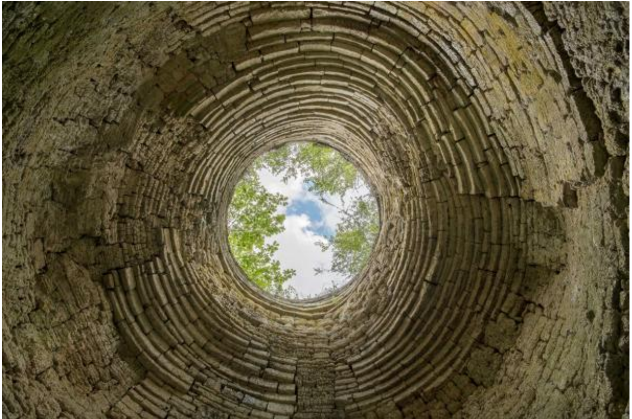
Chambre de combustion du four à chaux de Jalousie, vue verticale de bas en haut, Maison-Blanche, Montjean-sur-Loire.
