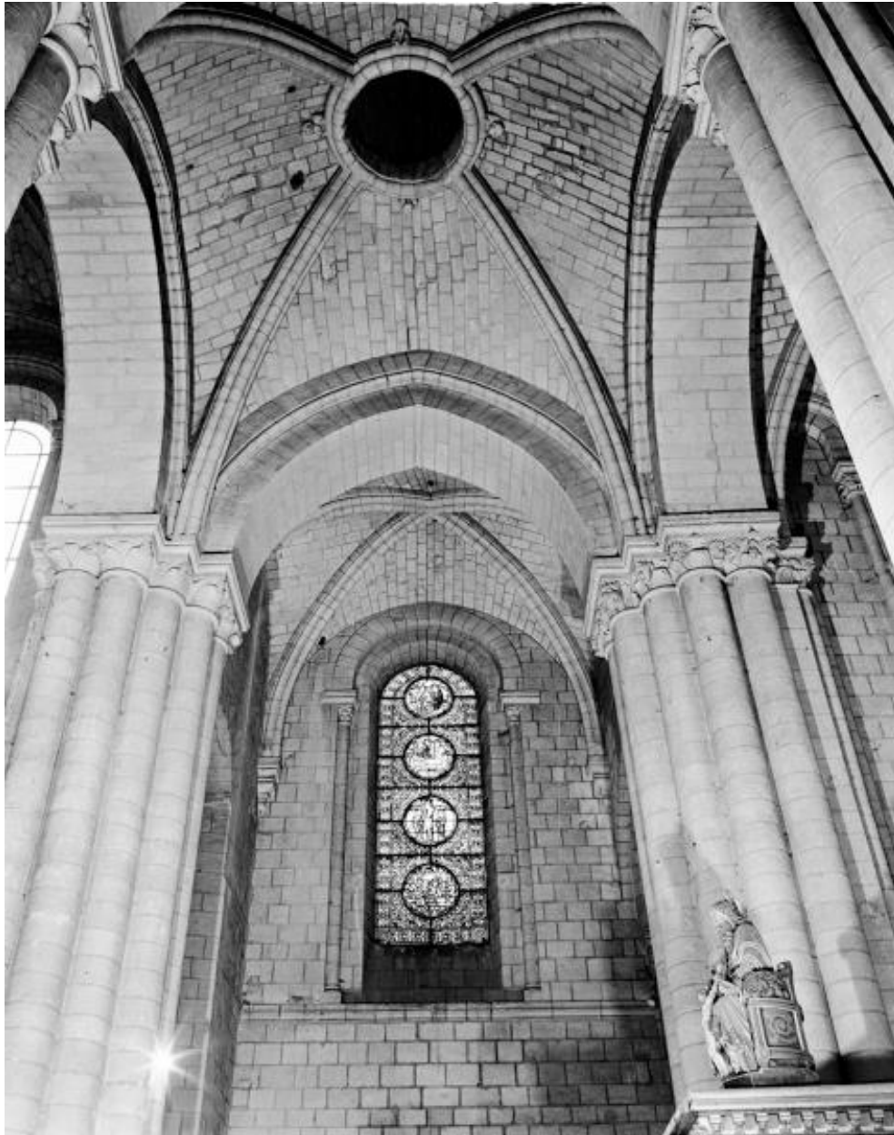
Transept, croisée et bras nord.
