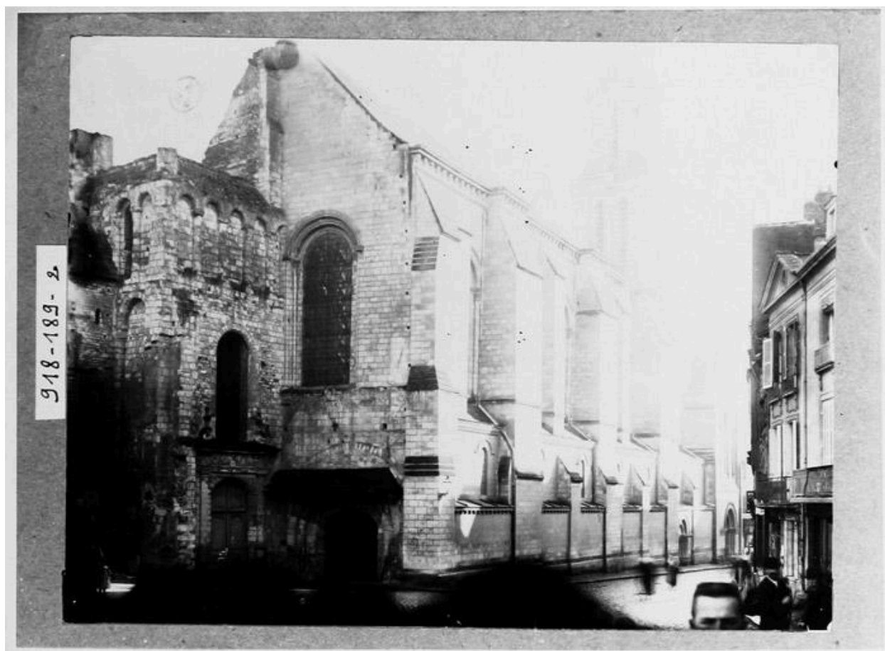
Entrée ouest de l'église de la Trinité et façade rue Beaurepaire, fotogr., [av. 1918].
