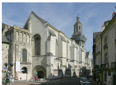
Vue de situation à l'ouest, sur la place. Phot. Patrice Giraud IVR52_20024904093NUCA
