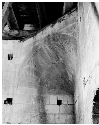
Clocher, chambre des cloches, détail sur l'une des trompes d'angle portant le plancher de l'étage du dôme octogonal : vue trois-quarts. Phot. François Lasa IVR52_19974900420X
