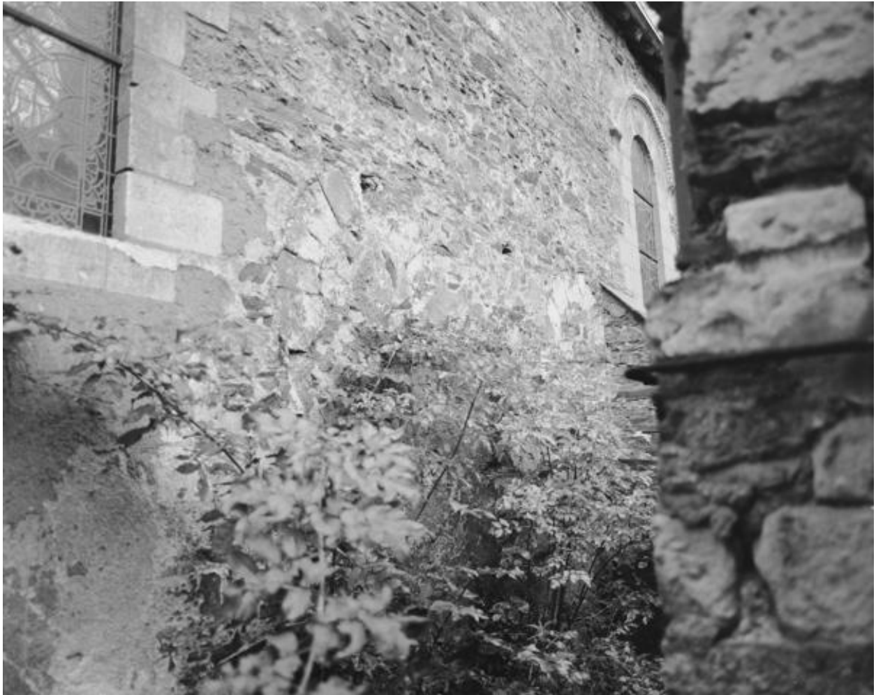
Mur nord, baies XIe s. murées.
