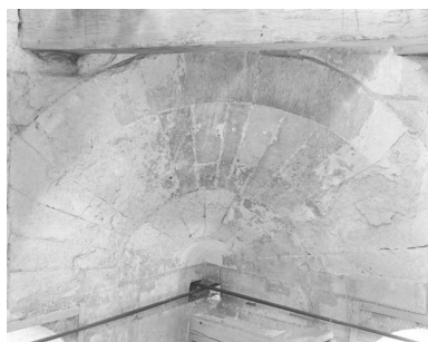
Clocher, chambre des cloches, détail sur l'une des trompes d'angle portant le plancher de l'étage du dôme octogonal : vue de face.
