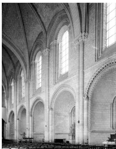
La nef, élévation intérieure nord.
