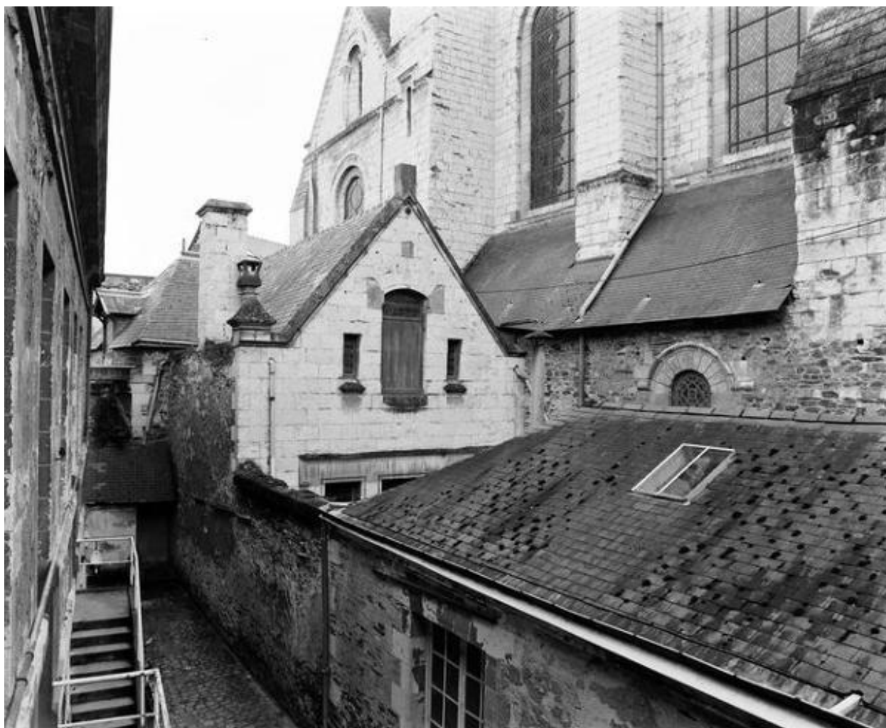
Sacristie sur le flanc nord de l'église, à hauteur du transept.
