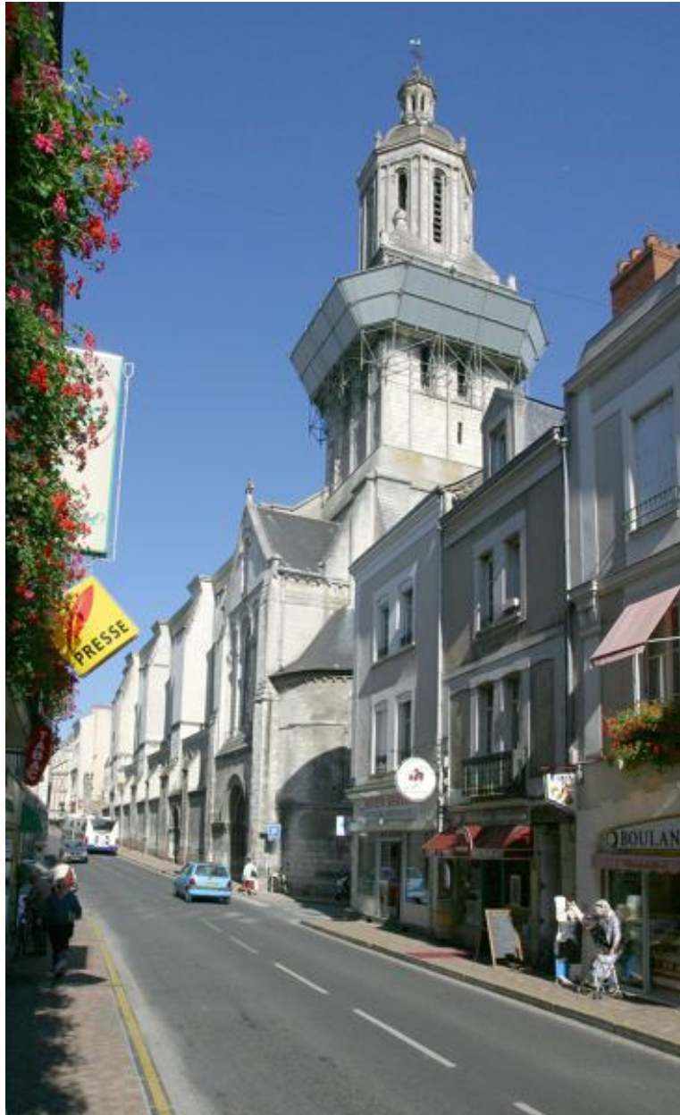
Vue de situation, depuis l'est, rue Beaurepaire.
