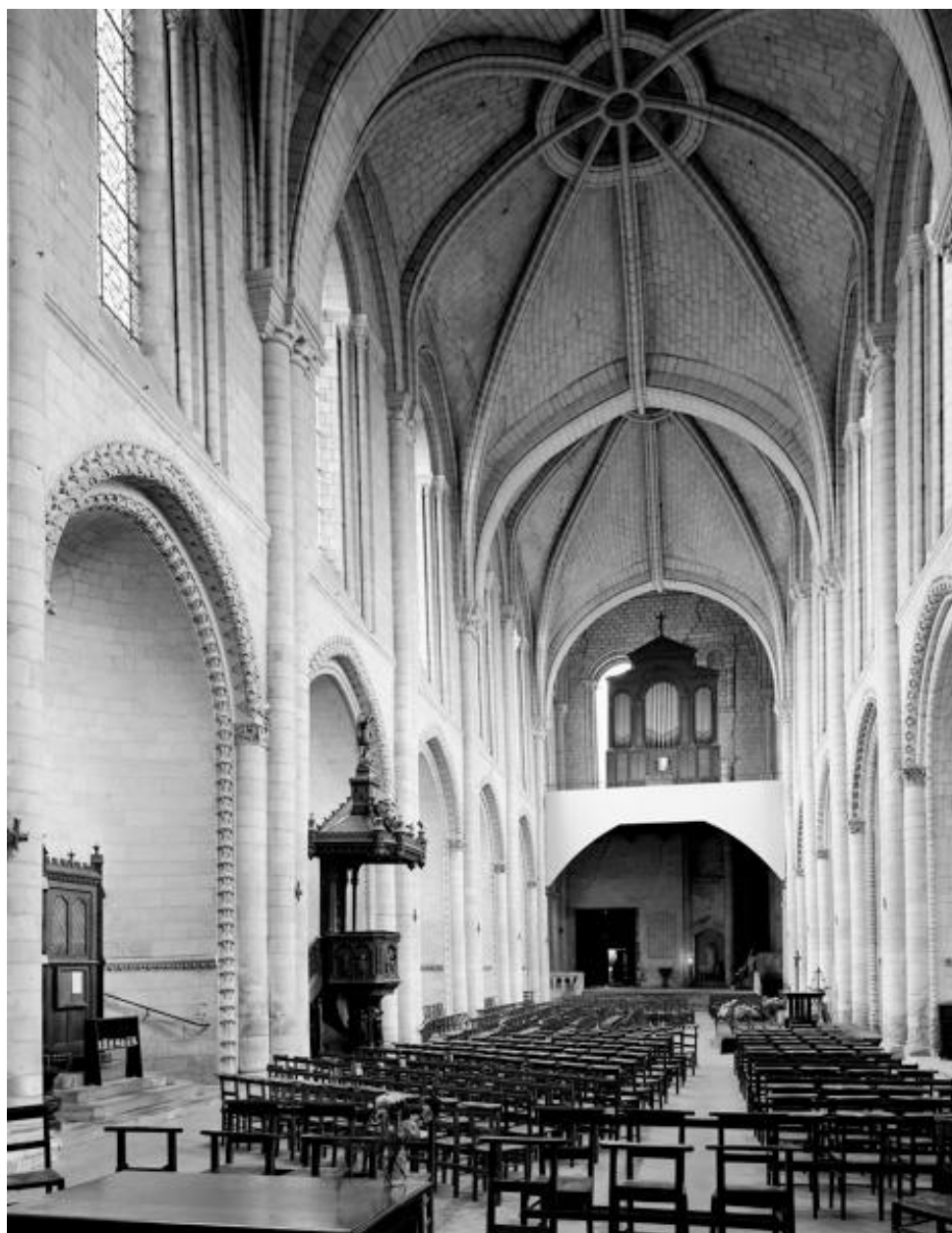
La nef, vue d'ouest en est.
