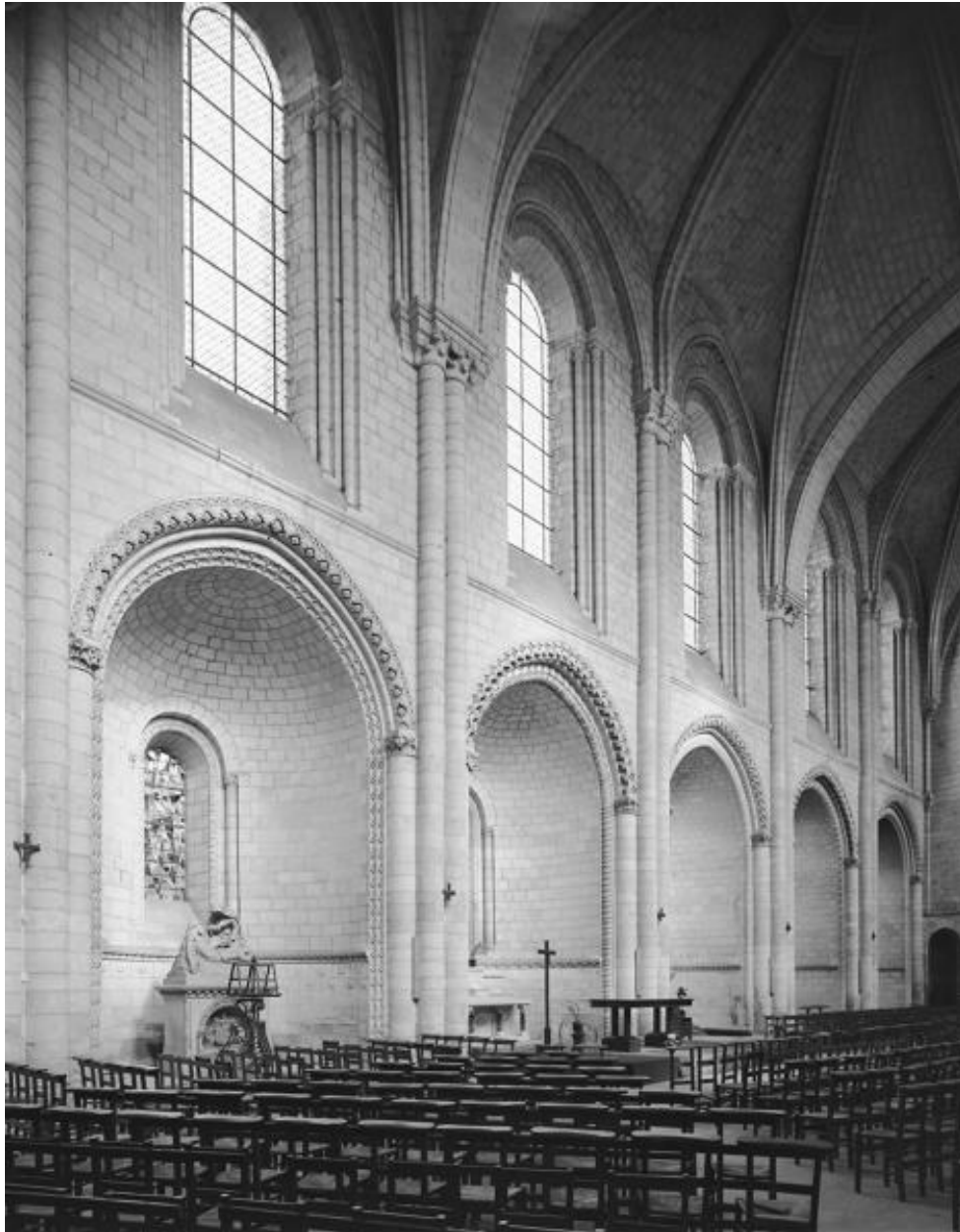
Elévation nord de la nef.
