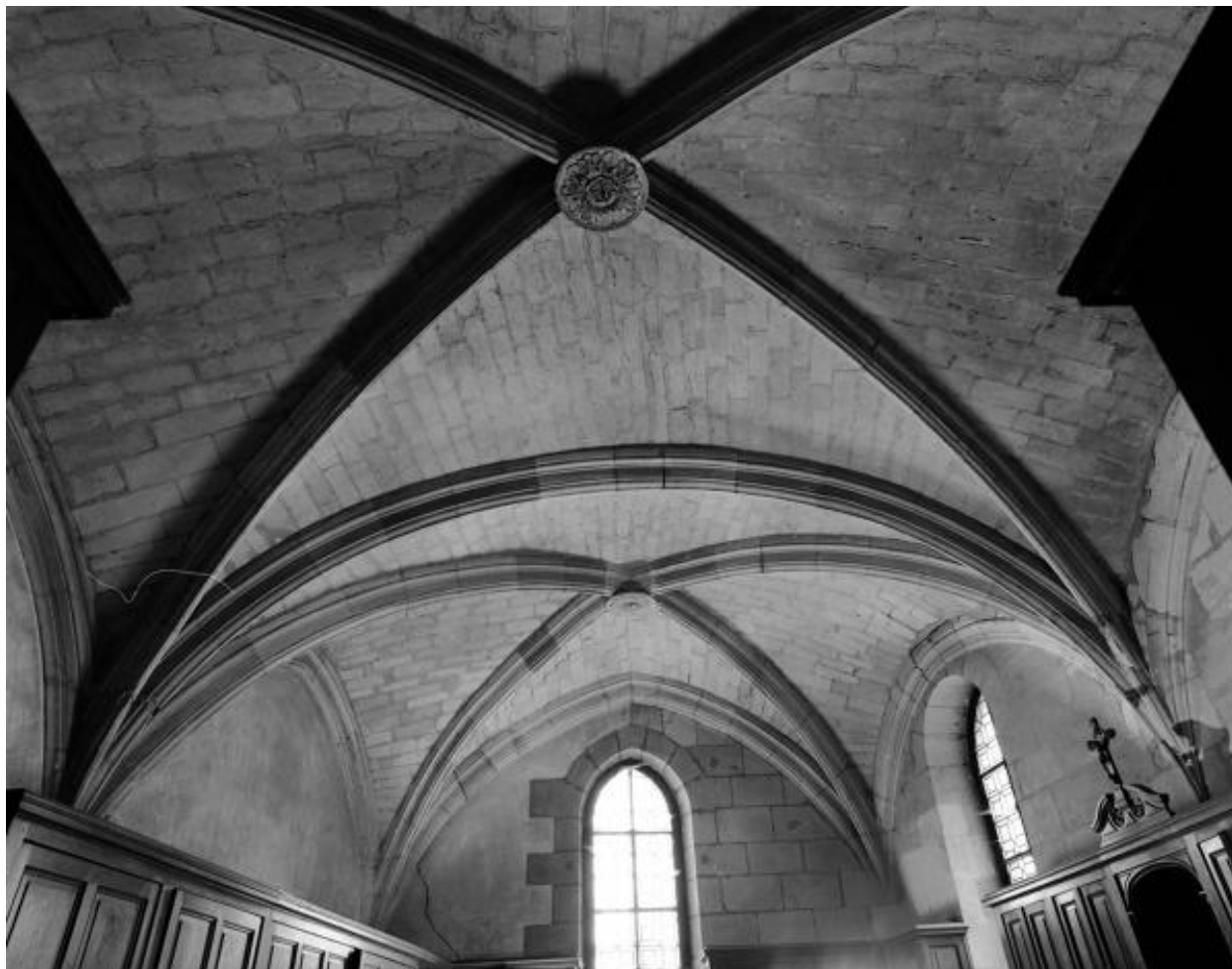
Sacristie : vue d'ensemble des voûtes, de l'entrée au sud vers le nord.
