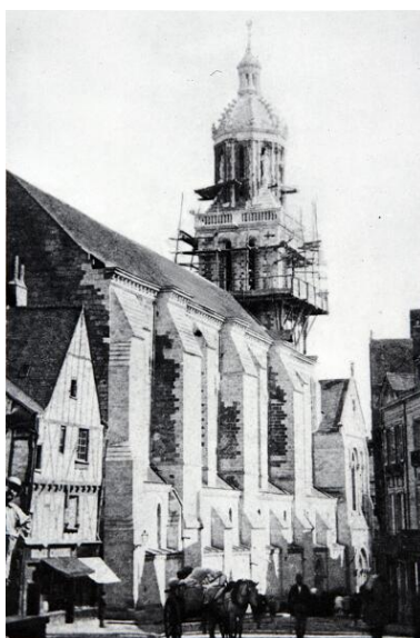
Vue d'ensemble de l'église depuis l'ouest avec la place de la Laiterie, fotogr., 1885 Repro. François Lasa IVR52_20054901376NUCA
