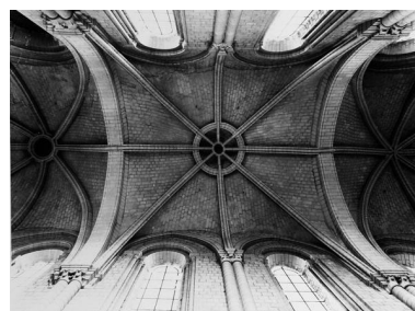
Voûte centrale de la nef. Phot. François Lasa IVR52_19874900122V
