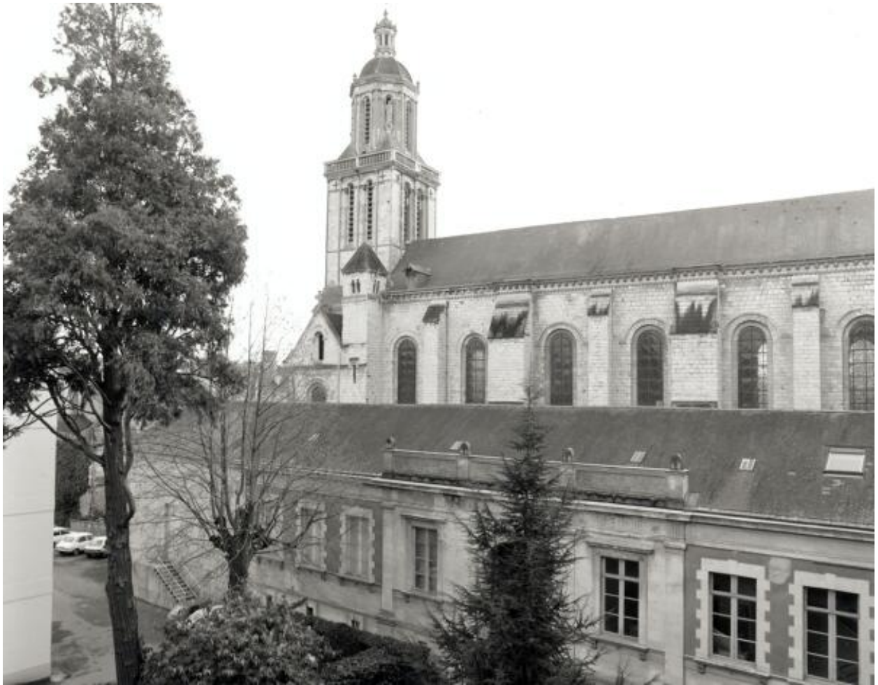
Bâtiment des études de la salle de distribution des prix : façade antérieure. Au second plan, élavation nord de l'église paroissiale de la Trinité.
