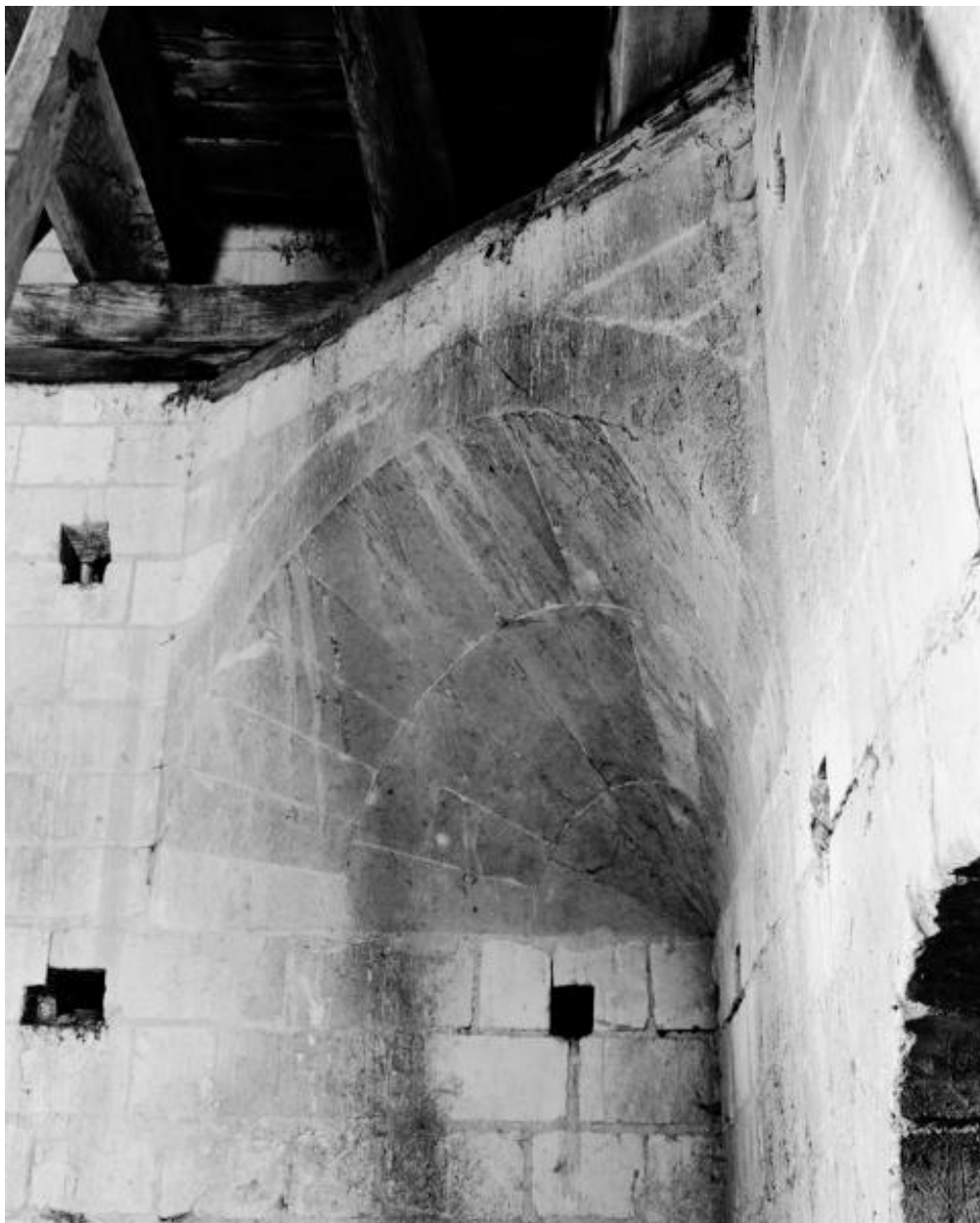
Clocher, chambre des cloches, détail sur l'une des trompes d'angle portant le plancher de l'étage du dôme octogonal : vue trois-quarts.
