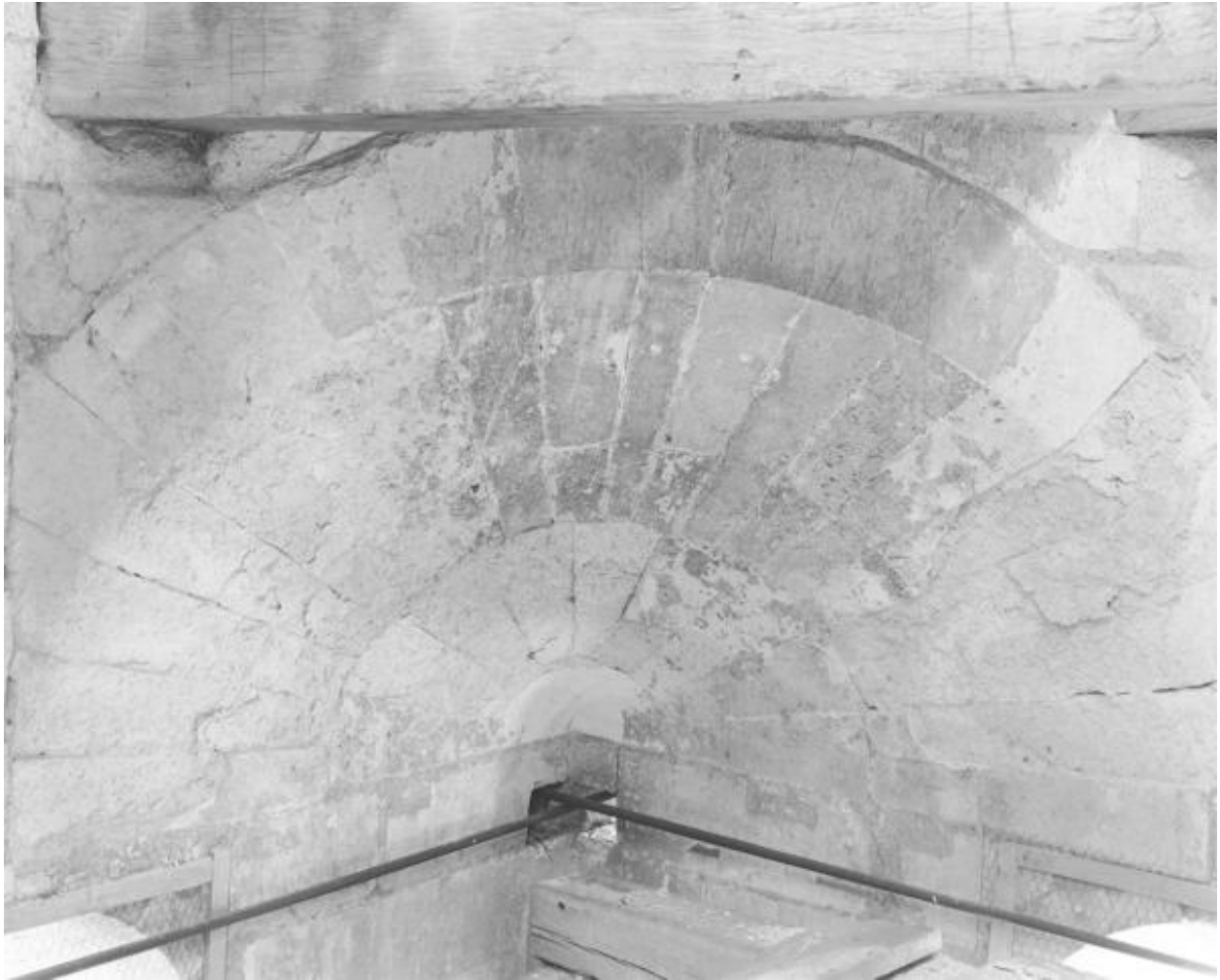
Clocher, chambre des cloches, détail sur l'une des trompes d'angle portant le plancher de l'étage du dôme octogonal : vue de face.
