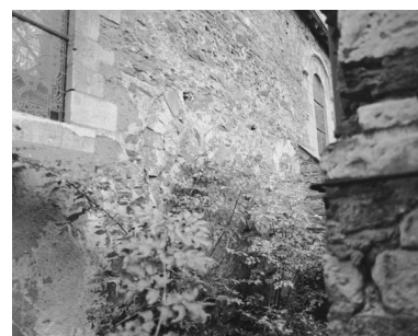
Mur nord, baies XIe s. murées. Phot. François Lasa IVR52_19834902127X
