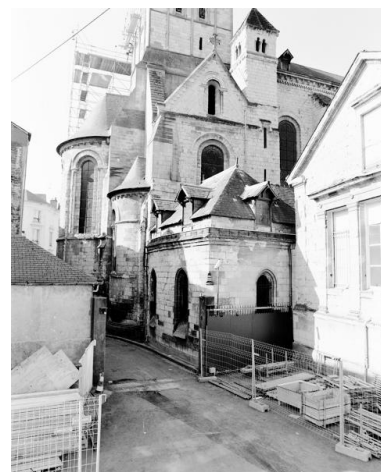
Vue d'ensemble au nord-est : le massif du transept et chevet. Au premier plan, la sacristie. Phot. François Lasa IVR52_19974900421X
