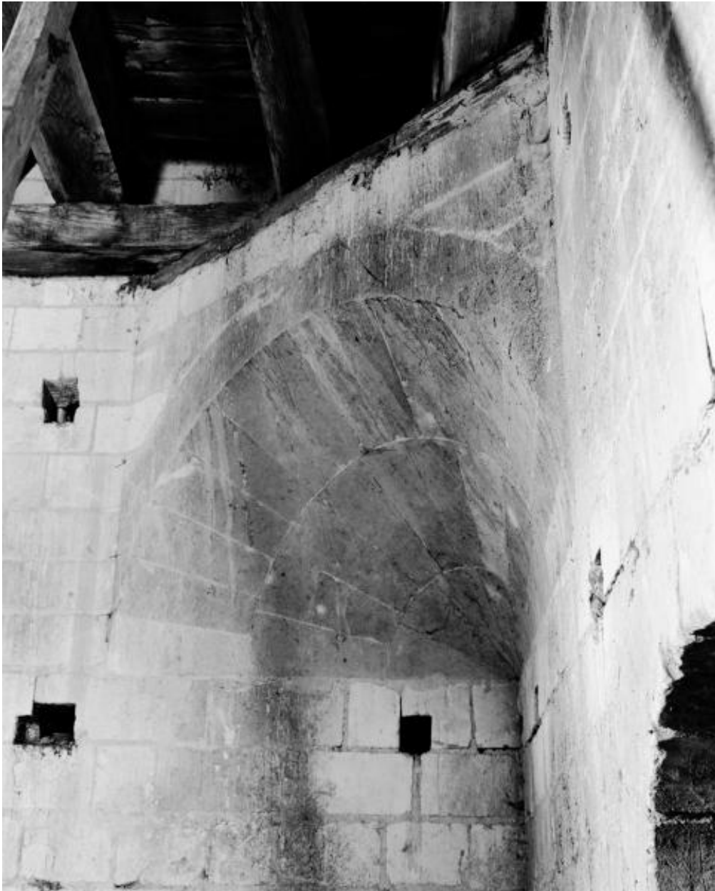
Clocher, chambre des cloches, détail sur l'une des trompes d'angle portant le plancher de l'étage du dôme octogonal : vue trois-quarts.
