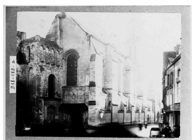
Entrée ouest de l'église de la Trinité et façade rue Beaurepaire, fotogr., [av. 1918]. Repro. Patrice Giraud IVR52_19754902083X
