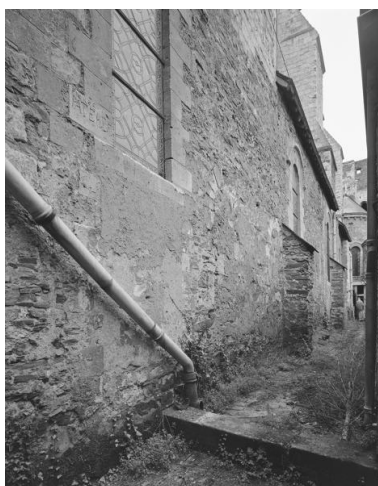
Mur nord-est. Phot. Patrice Giraud IVR52_19814900538V
