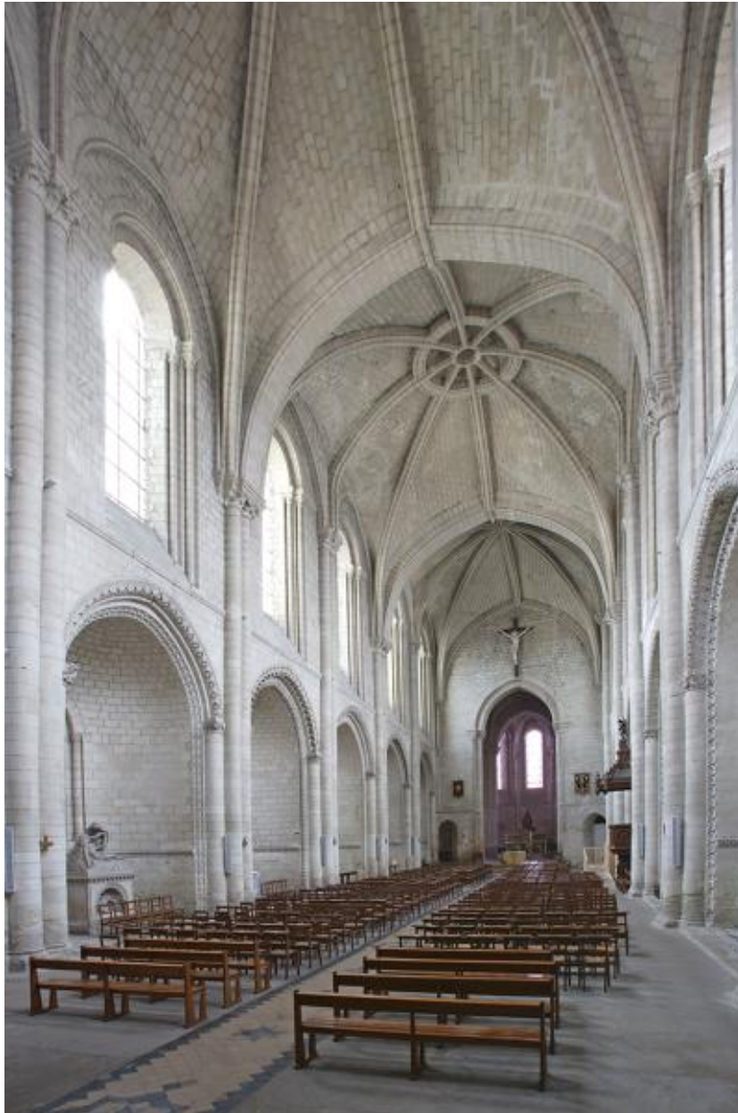
Vue d'ensemble de la nef vers le ch#ur.
