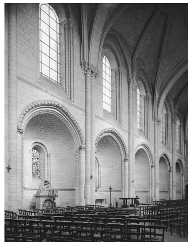
Élévation nord de la nef. Phot. Patrice Giraud IVR52_19814900539V
