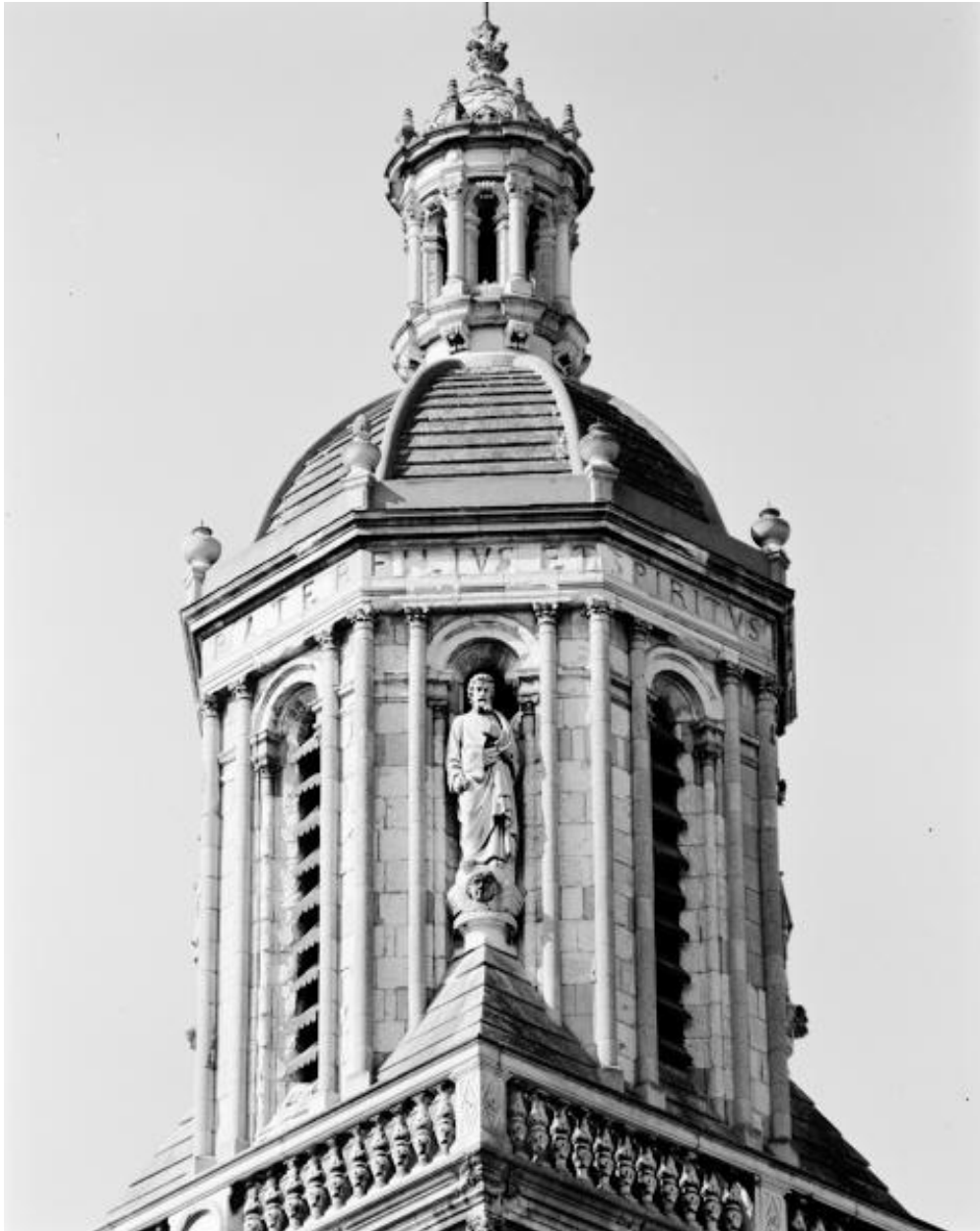
Le clocher : dôme et lanternon, vus du nord-est.
