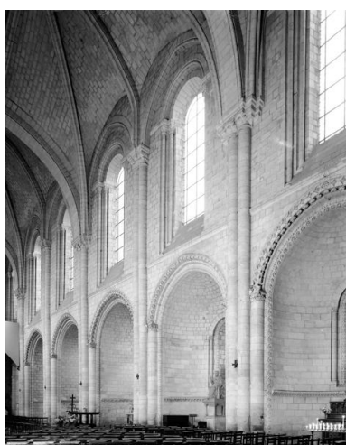
La nef, élévation intérieure nord.
