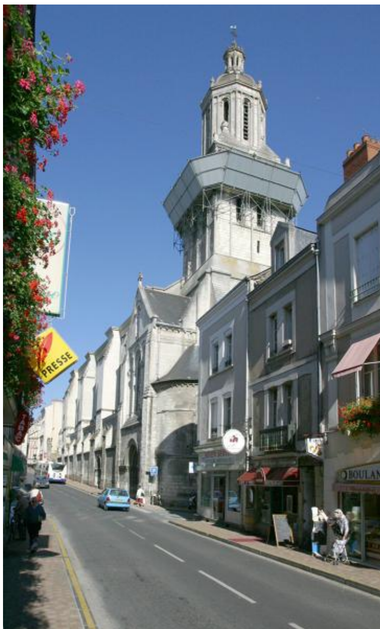
Vue de situation, depuis l'est, rue Beaurepaire.
