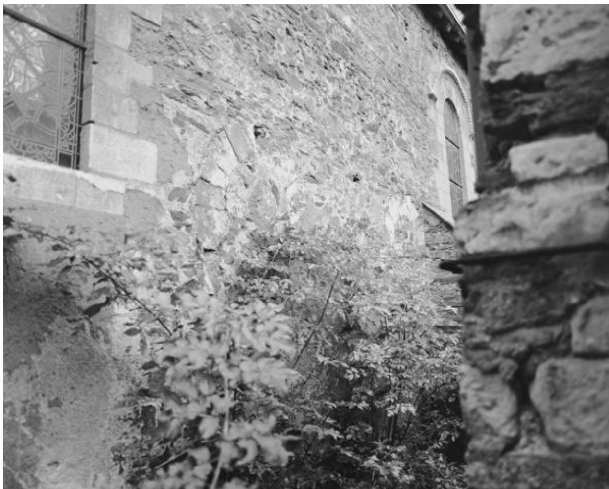
Mur nord, baies XIe s. murées.
