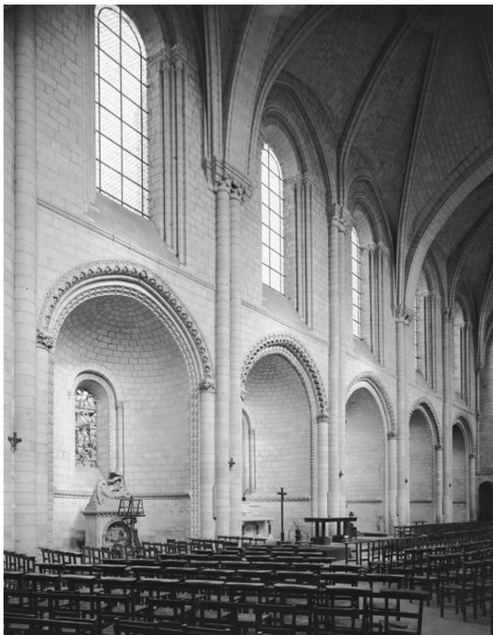
Elévation nord de la nef.
