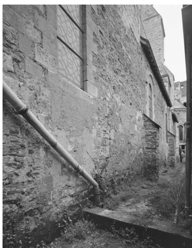
Mur nord-est. Phot. Patrice Giraud IVR52_19814900538V
