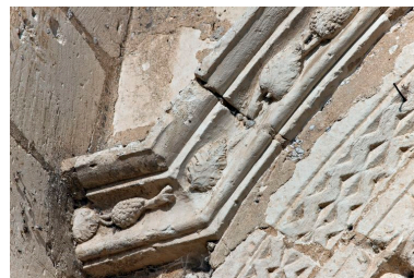
Vue intérieure du logement Phot. Yves Guillotin IVR52_20127200227NUCA
