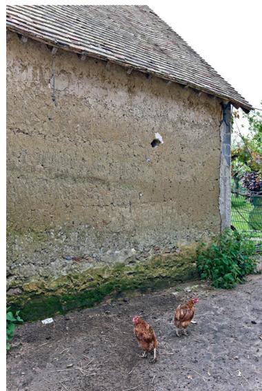
Elévation en bauge du logement.
