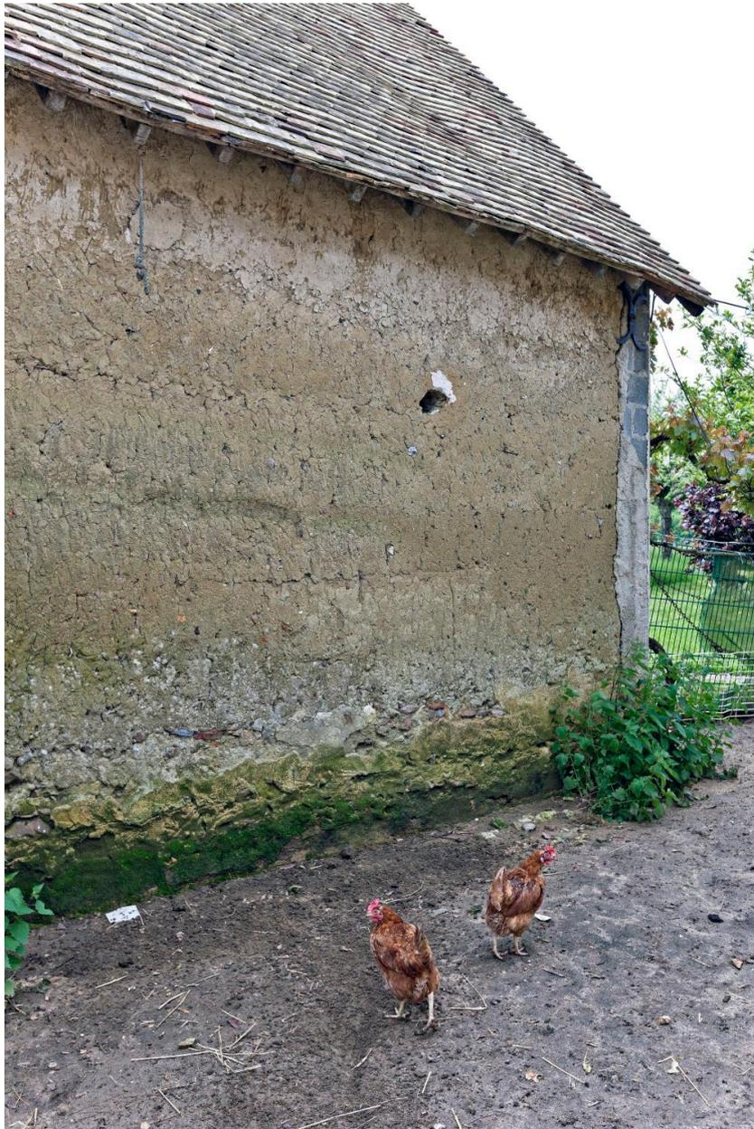
Elévation en bauge du logement.
