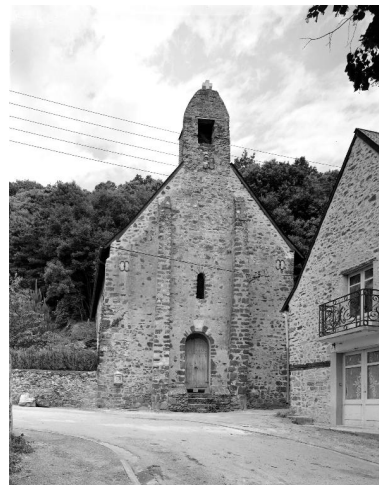
Elévation antérieure ouest. Phot. François Lasa IVR52_19825300319V
