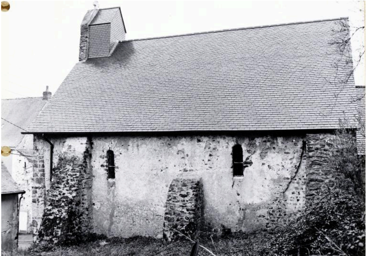
Nef, élévation latérale sud.
