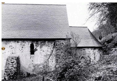
Chœur, élévation latérale sud. Phot. François Lasa IVR52_19835300255X
