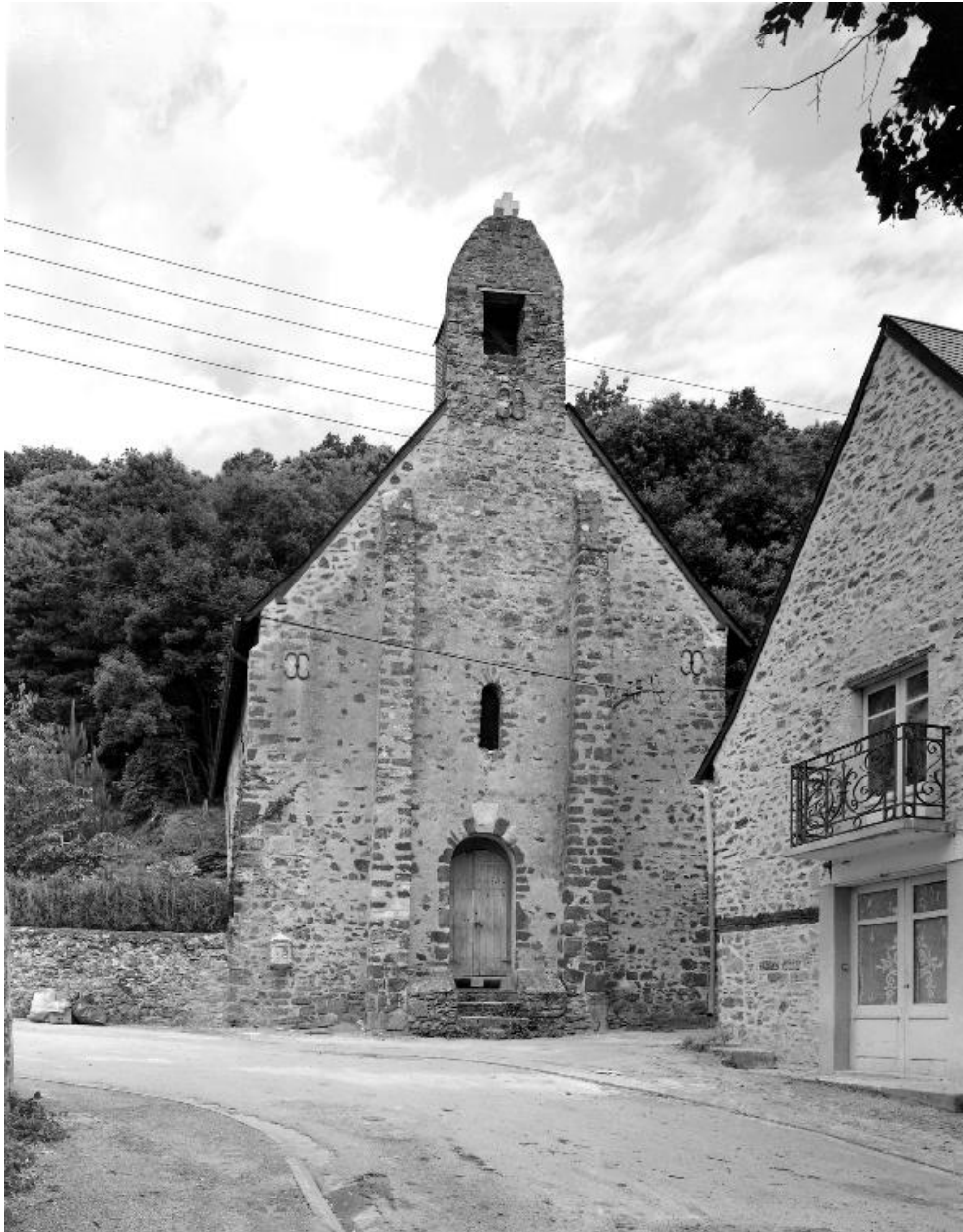
Elévation antérieure ouest.
