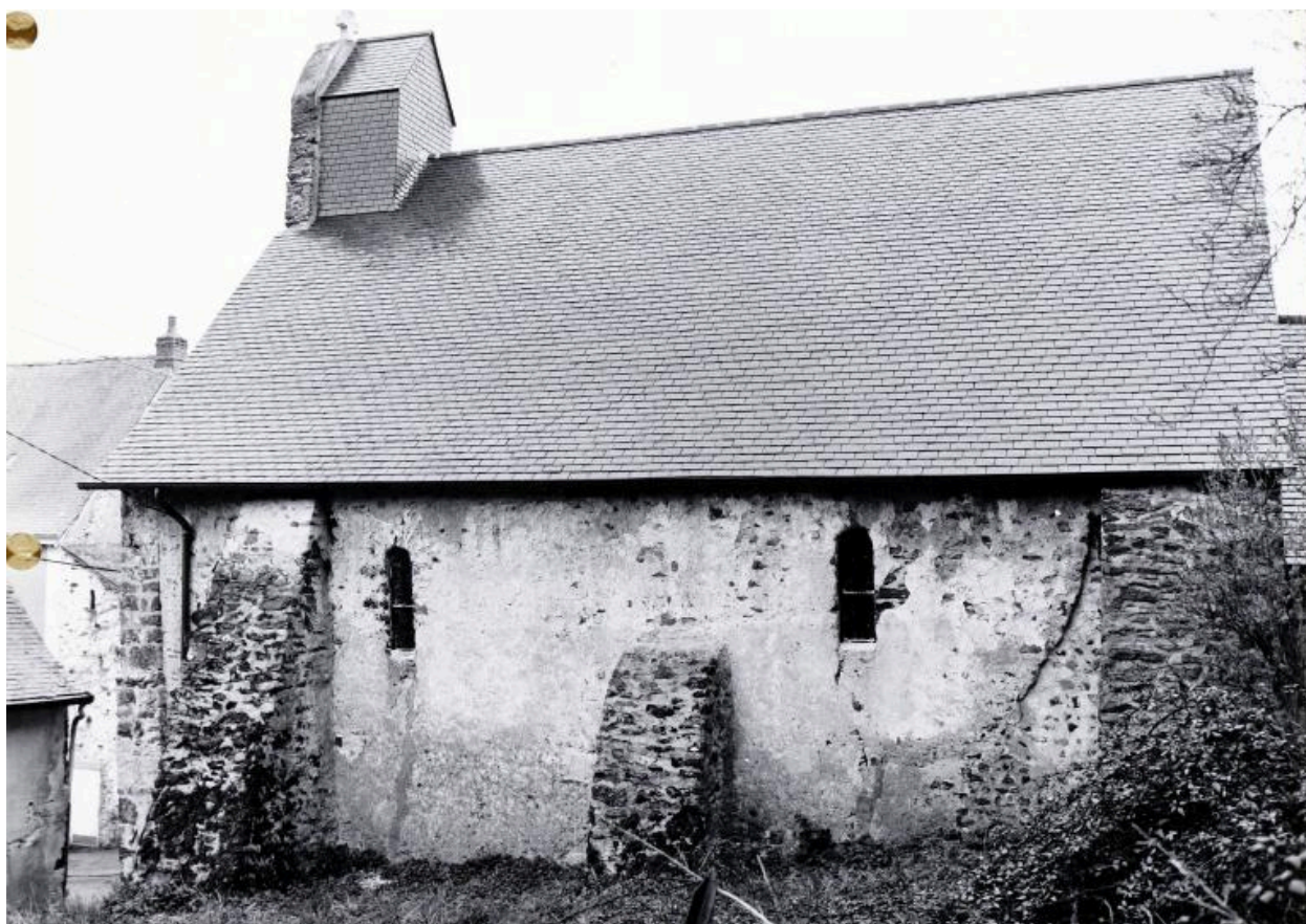
Nef, élévation latérale sud.
