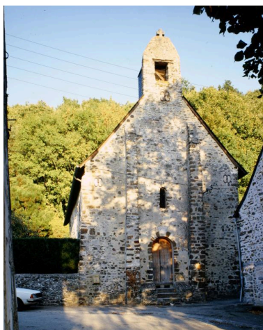
Elévation antérieure ouest. Phot. François Lasa IVR52_19885300750XA
