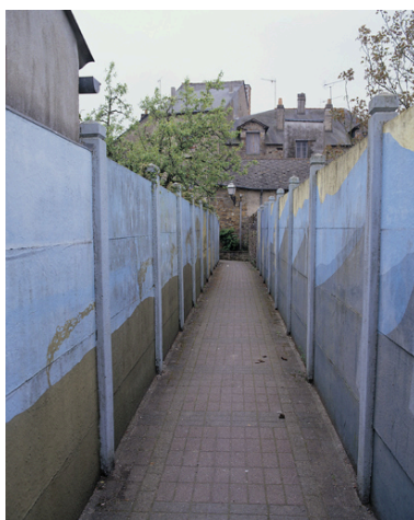
Vue d'ensemble. Phot. Denis Pillet IVR52_20004400975XA
