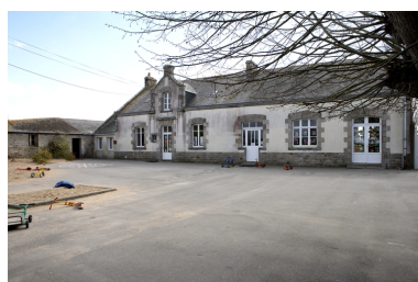
Vue de la façade principale. Phot. Denis Pillet IVR52_20084400470NUCA
