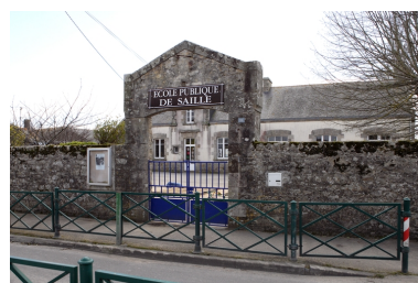
Vue du portail d'entrée de l'école. Phot. Denis Pillet IVR52_20084400471NUCA
