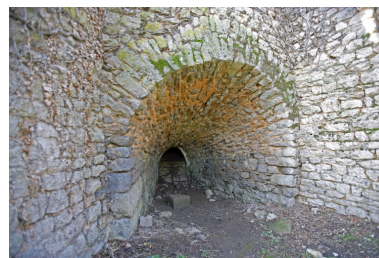
L'ouverture de déchargement centrale. Phot. François Lasa IVR52_20065302868NUCA
