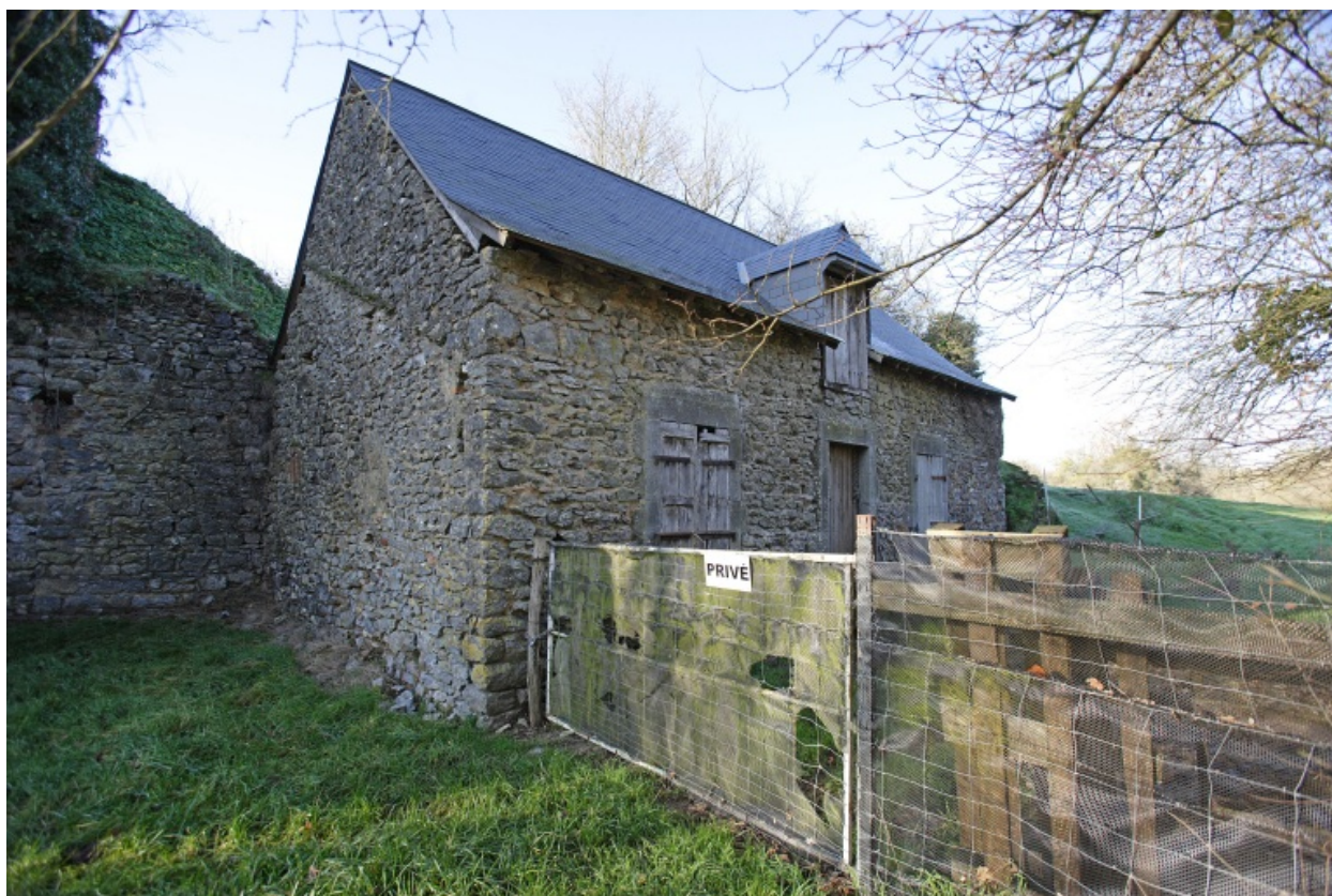
Le logis vu depuis le sud-est.
