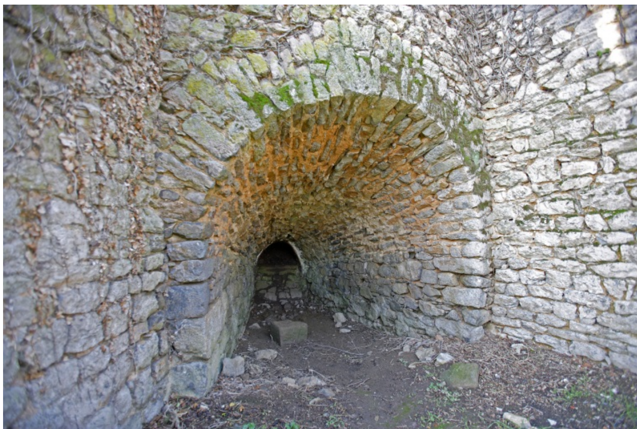
L'ouverture de déchargement centrale.
