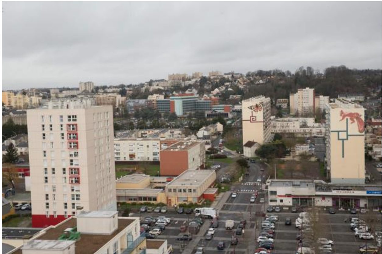
Vue du nord du quartier depuis le sud.
