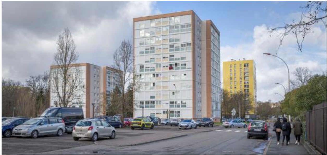
Vue des tours bordant le parc des Sablons depuis l'ouest.
