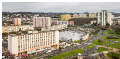
Vue de l'immeuble Lafitte, du centre-commercial ouest et de la tour cristal des Sablons. Phot. Pierre-Bernard Fourny IVR52_20197200028NUCA
