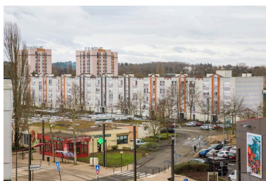
Vue du centre commercial de l'Epau. Phot. Pierre-Bernard Fourny IVR52_20197200138NUCA
