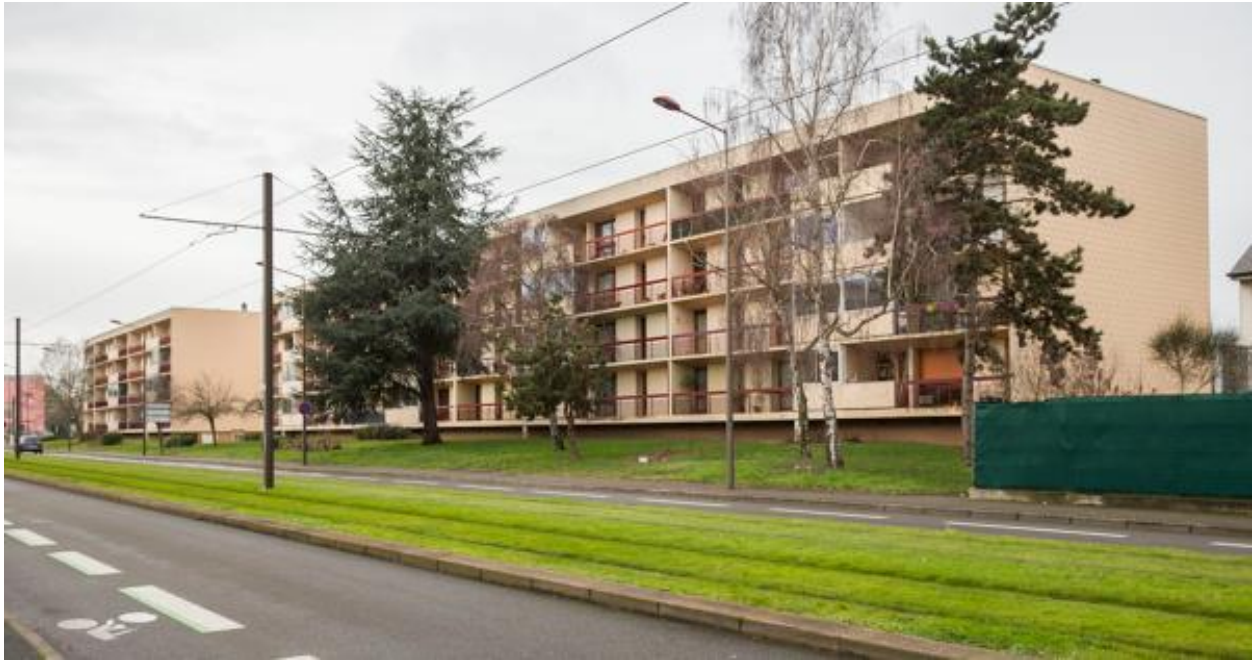
Vue de la façade sud de la barre rue du Mont Pelvoux.
