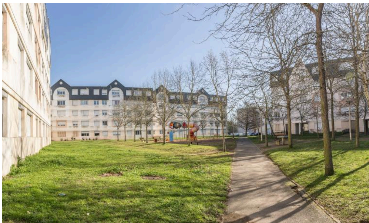
Vue des immeubles à l'est de la Z.U.P.
