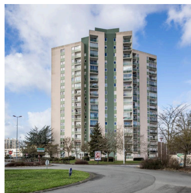
Vue de la tour dite cristal depuis le sud. Phot. Pierre-Bernard Fourny IVR52_20197200230NUCA
