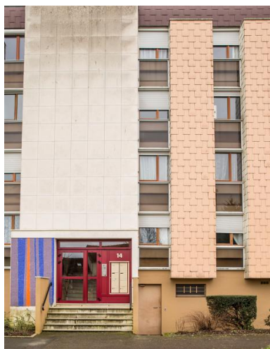
Vue de la travée d'entrée est de la barre rue du Mont Pelvoux, façade nord. Phot. Pierre-Bernard Fourny IVR52_20197200103NUCA
