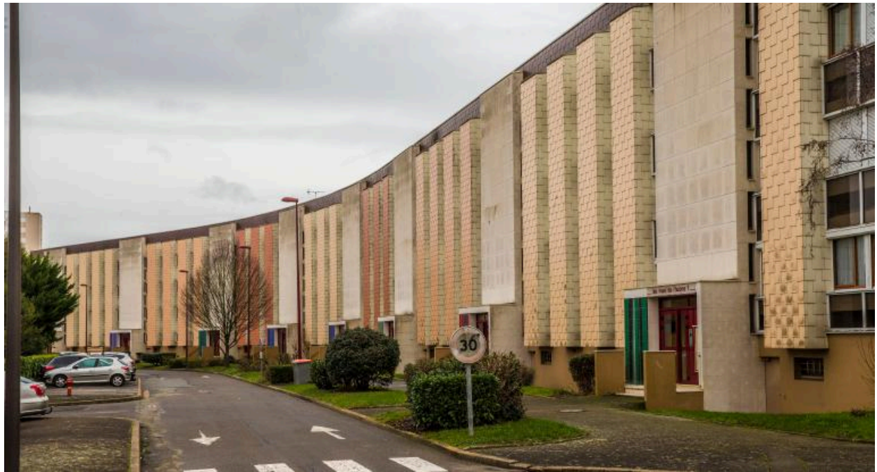
Vue de la barre rue du Mont Pelvoux.
