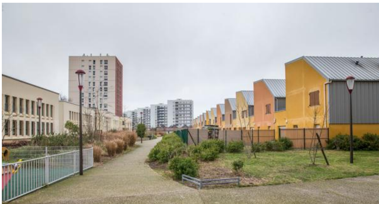
Vue de la rue des Alpes depuis l'est.
