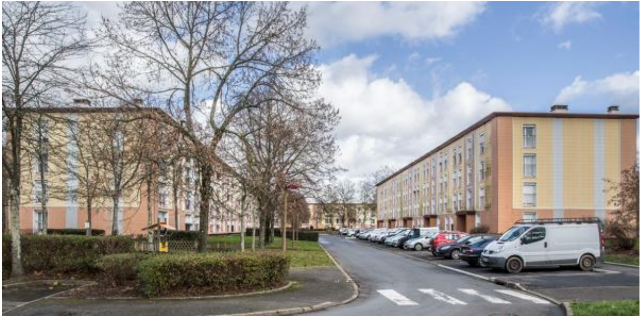
Vue des immeubles rue d'Allemagne depuis l'est.
