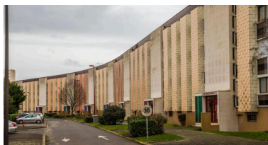
Vue de la barre rue du Mont Pelvoux. Phot. Pierre-Bernard Fourny IVR52_20197200100NUCA
