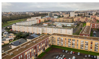
Vue des immeubles de la première tranche, partie ouest. Phot. Pierre-Bernard Fourny IVR52_20197200045NUCA
