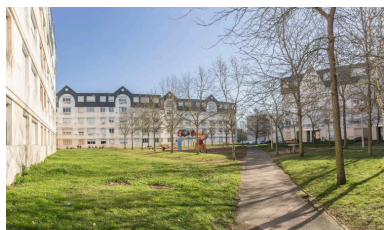
Vue des immeubles à l'est de la Z.U.P. Phot. Pierre-Bernard Fourny IVR52_20197200280NUCA
