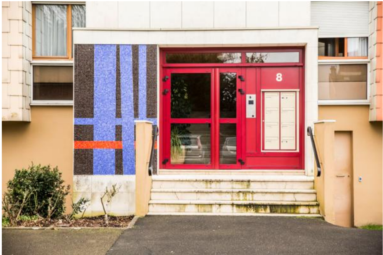
Vue de l'entrée est de la barre rue du Mont Pelvoux, façade nord.
