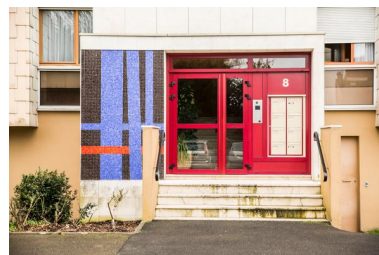
Vue de l'entrée est de la barre rue du Mont Pelvoux, façade nord. Phot. Pierre-Bernard Fourny IVR52_20197200102NUCA
