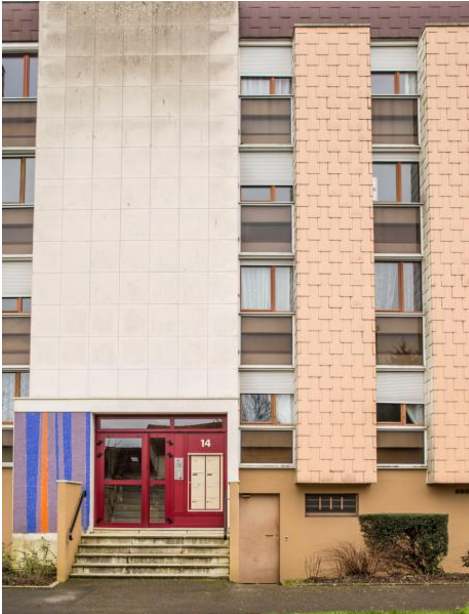
Vue de la travée d'entrée est de la barre rue du Mont Pelvoux, façade nord.
