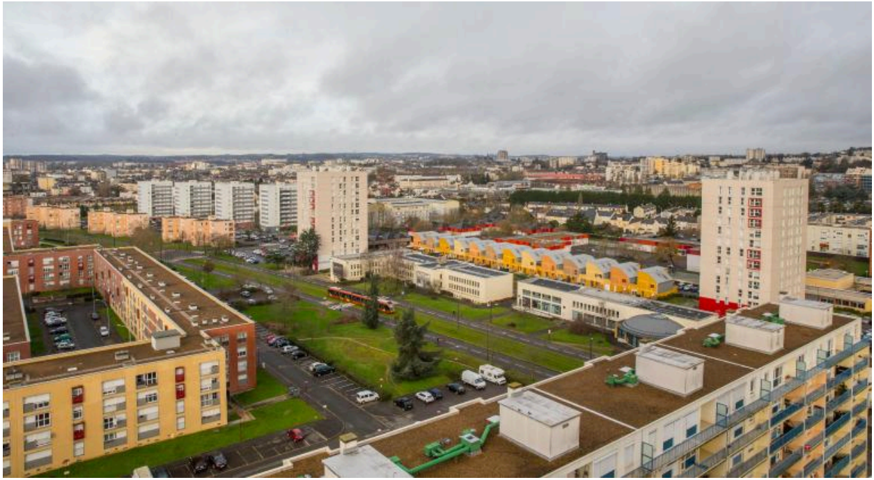
Vue du nord ouest de la Z.U.P. des Sablons.
