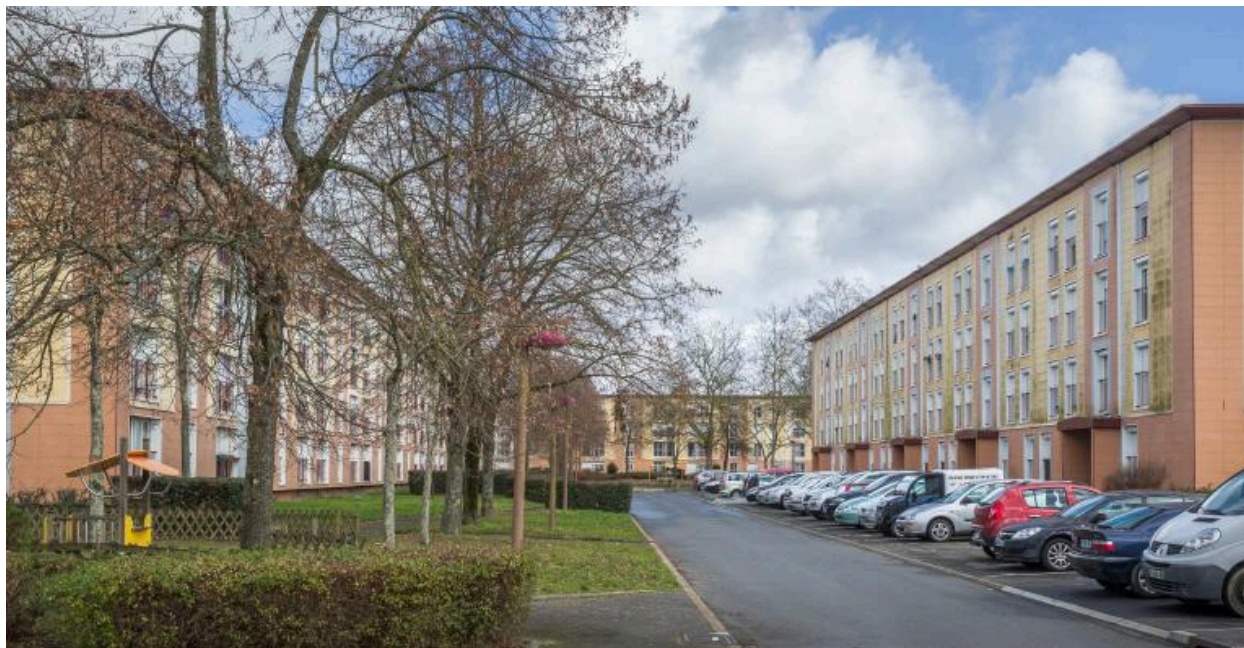
Vue des immeubles de la première phase de la partie est.
