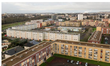
Vue des immeubles Vergnaud avec l'école centrale. Phot. Pierre-Bernard Fourny IVR52_20197200055NUCA
