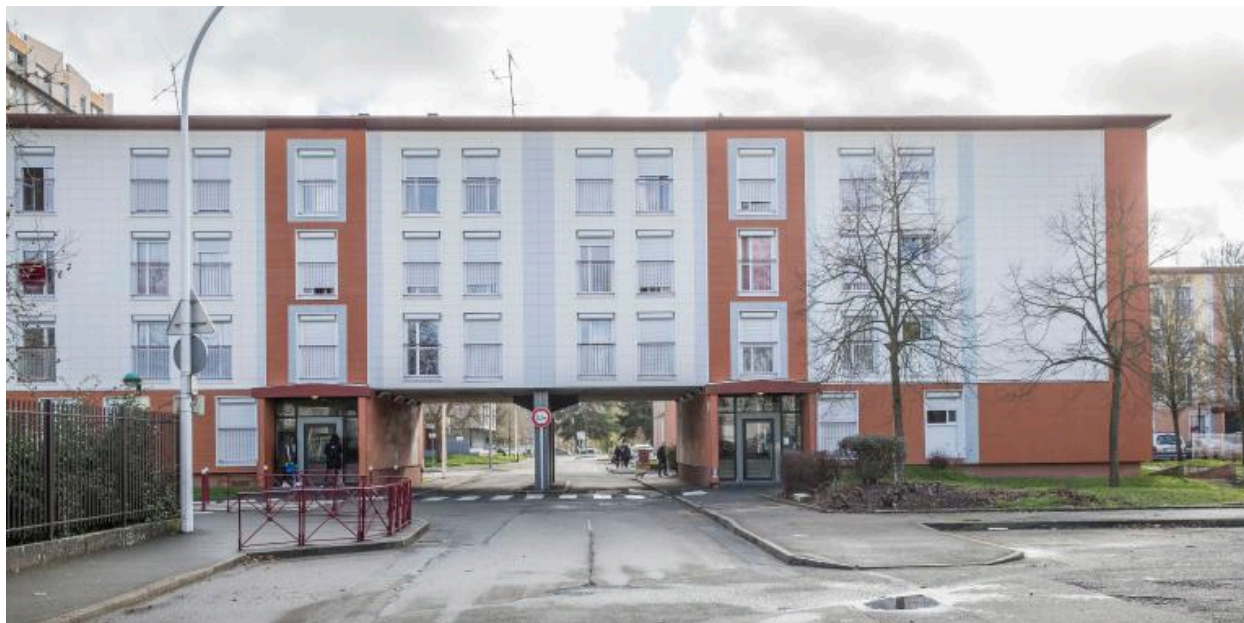
Vue du passage sous immeuble.
