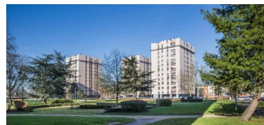
Vue des tours du sud est de la Z.U.P. des Sablons. Phot. Pierre-Bernard Fourny IVR52_20197200276NUCA
