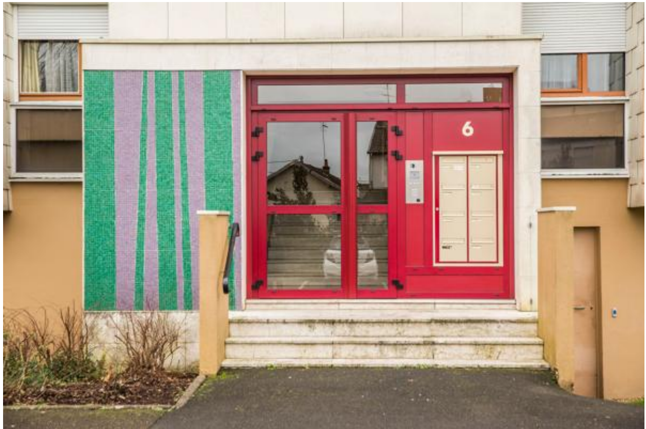
Vue d'une entrée sur la façade nord de la barre rue du Mont Pelvoux.
