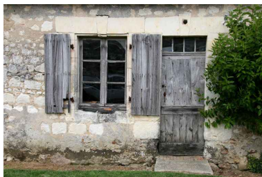
Ferme 1 : porte et fenêtre de la maison. Phot. Jean-Baptiste Darrasse IVR52_20057203354NUCA
