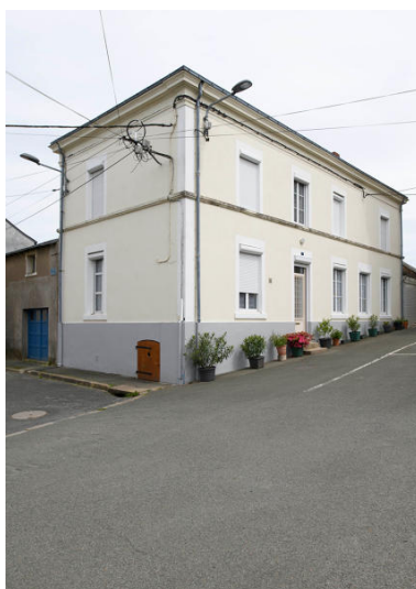
Ancienne mairie-école de Beausse ; actuellement maison. Phot. Xaël Despré, Phot. Armelle Maugin IVR52_20214900327NUCA
