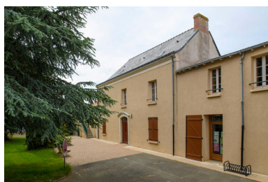
Vue de l'ancien presbytère. Phot. Xaël Despré, Phot. Armelle Maugin IVR52_20214900326NUCA
