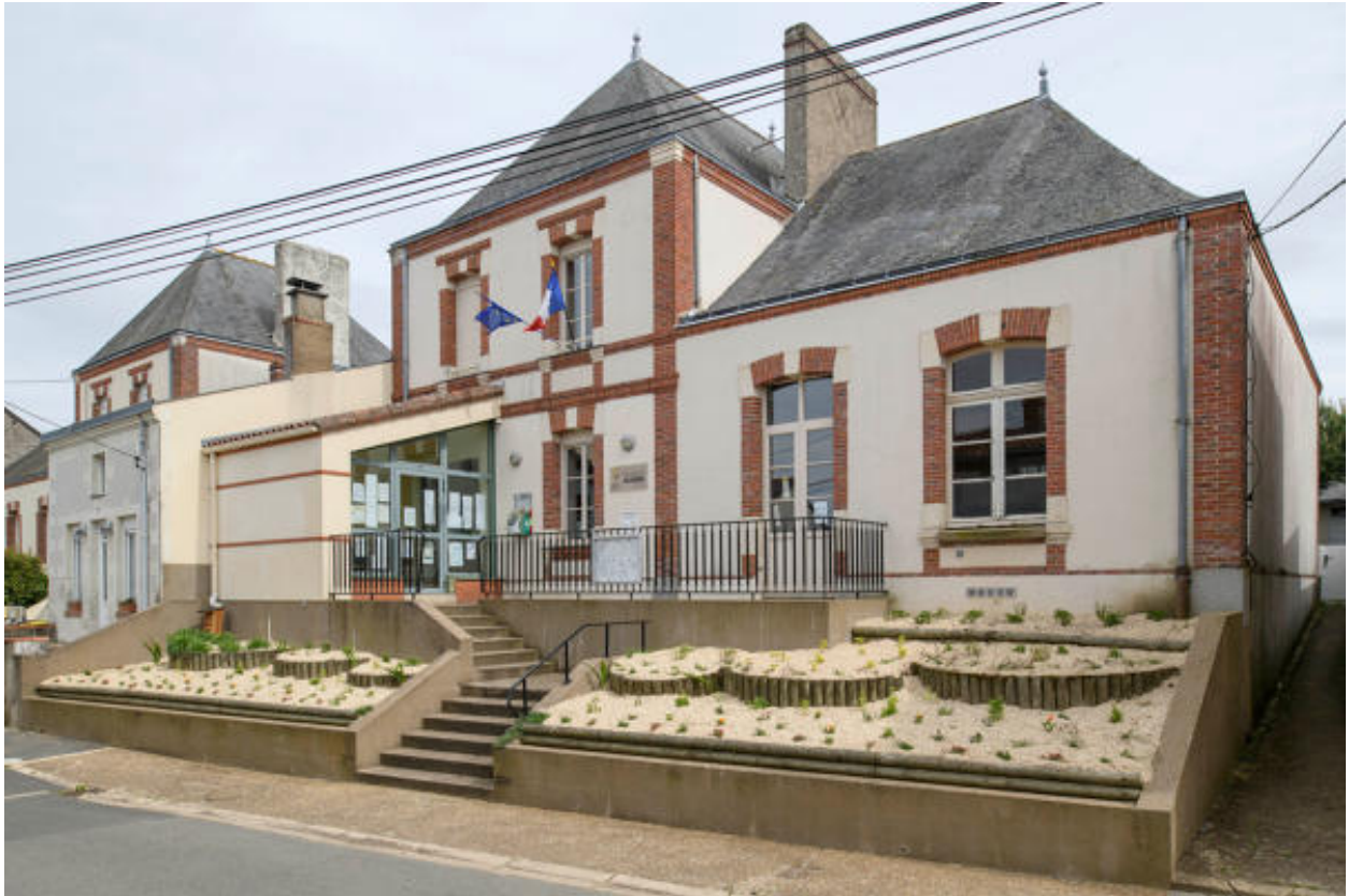
Vue de la façade principale de la mairie.
