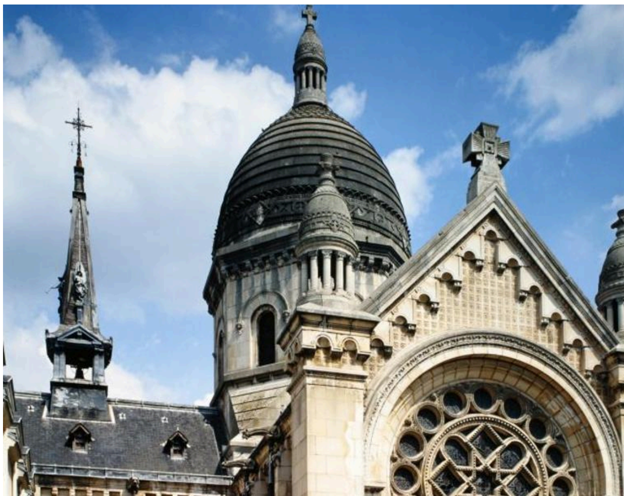
Dôme et campanile : vue d'ensemble.
