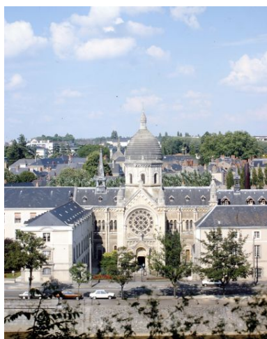
Façade ouest : vue d'ensemble. Phot. François Lasa IVR52_19885300516XA
