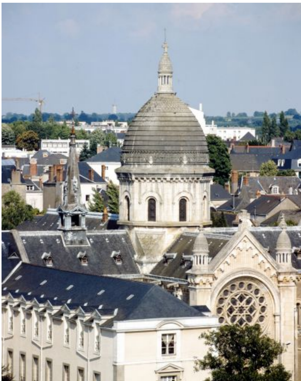
Façade ouest et dôme : vue d'ensemble.
