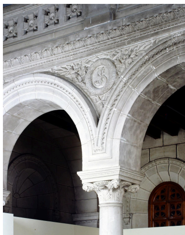
Nef, arcades, vue de détail : chapiteau, arcs et écoinçon. Phot. François Lasa IVR52_19885300519XA
