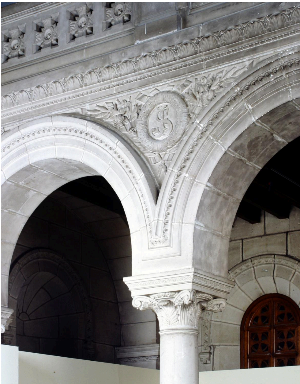
Nef, arcades, vue de détail : chapiteau, arcs et écoinçon.
