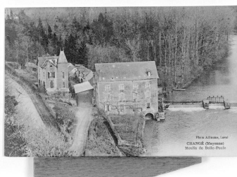
Vue d'ensemble du moulin et de ses dépendances depuis l'ouest : au premier plan à gauche, la maison du meunier. A droite, le pertuis du barrage. Autr. Alliaume, Repro. François Lasa IVR52_20015300334X
