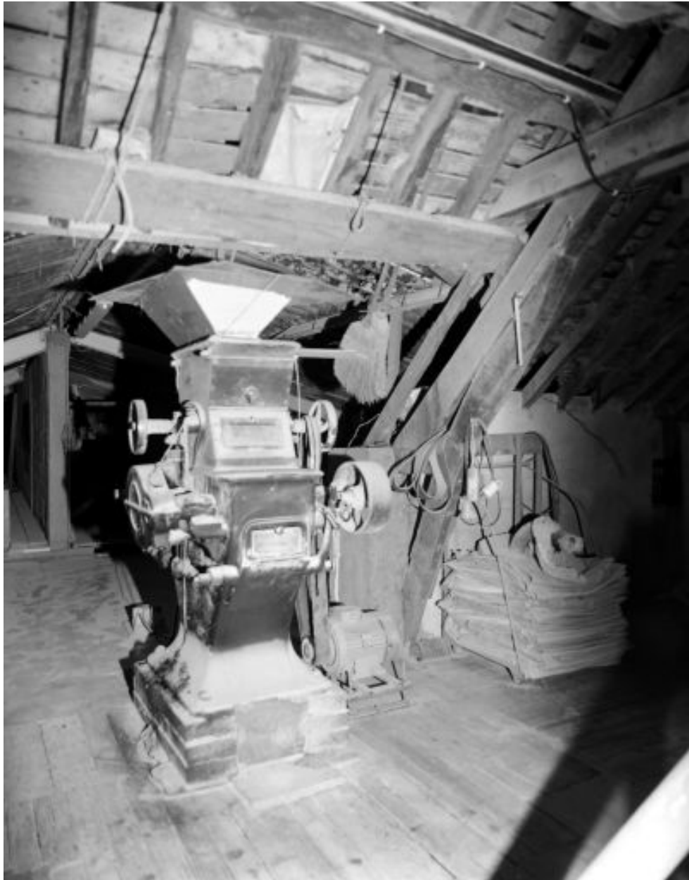
Comble. Aplatisseur d'orge.
