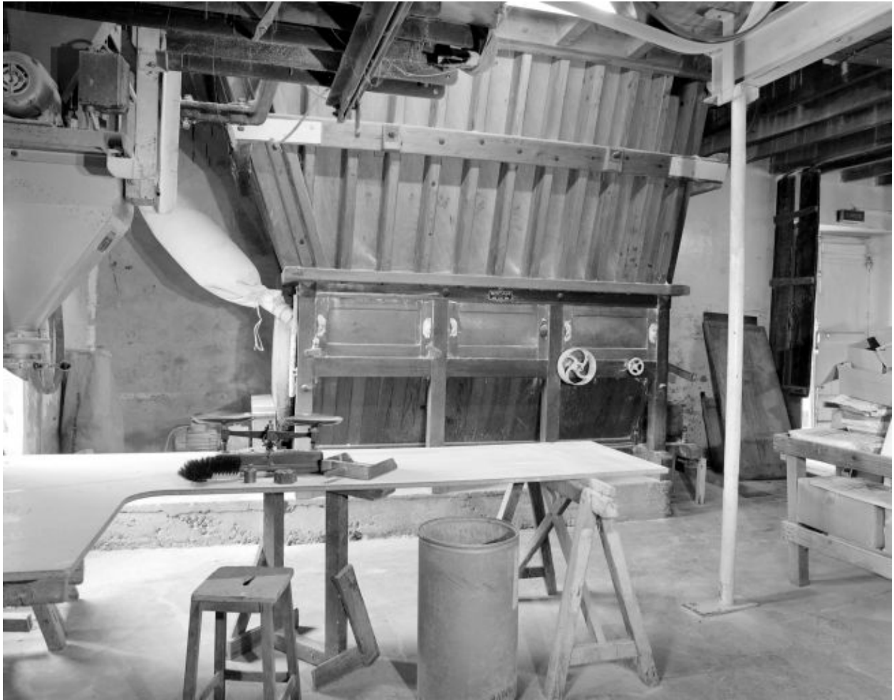
Rez-de-chaussée, partie sud-ouest. La mélangeuse.
