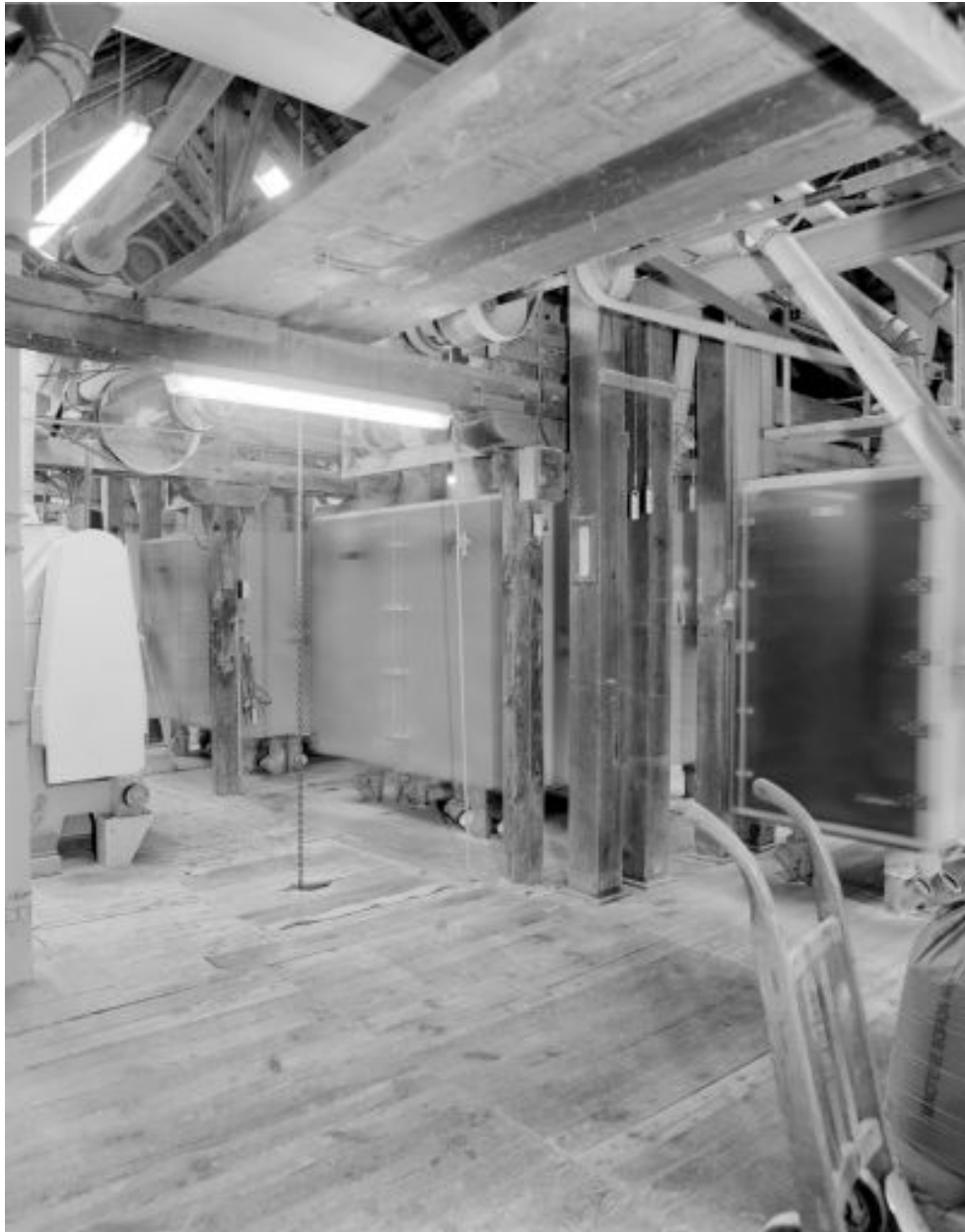
Comble. Les plansichters, vus de l'ouest.
