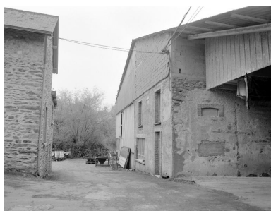
Les anciennes dépendances vues du nord. A gauche, le bâtiment qui servait à loger les ouvriers. A droite, les anciennes écuries, doublées vers la rivière et rattachées au moulin. Phot. François Lasa IVR52_20025301238X
