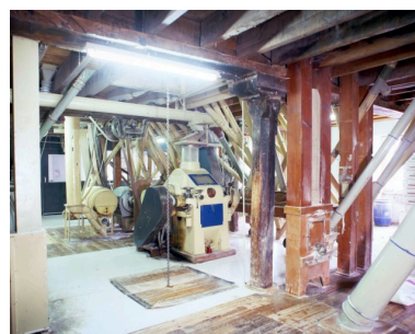
Deuxième étage. Vue d'ensemble depuis l'accès, à l'ouest. Au centre, un broyeur à cylindre. Phot. François Lasa IVR52_20025300781XA
