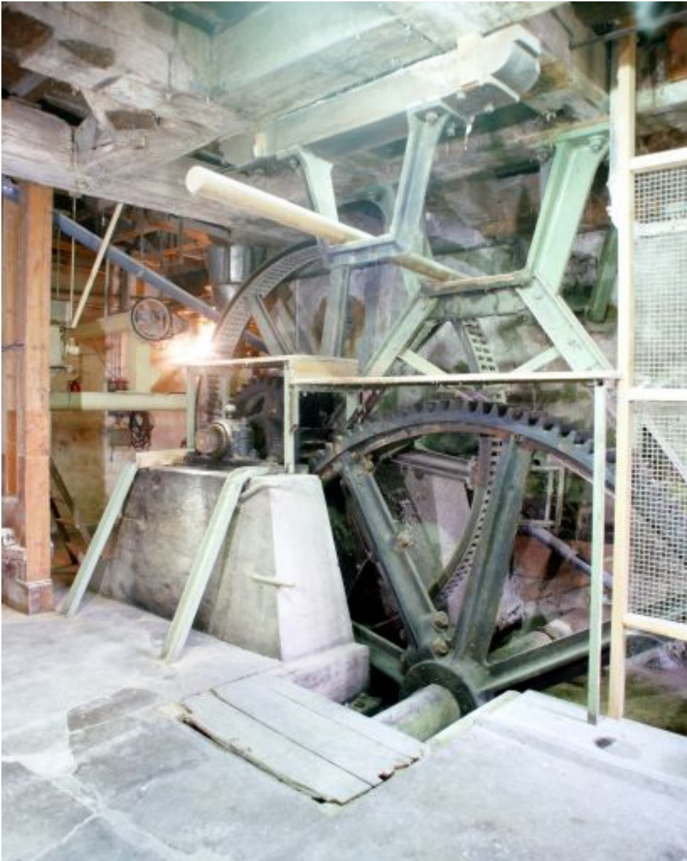
Rez-de-chaussée, partie sud-est. Le mécanisme de transmission, vu de l'ouest.
