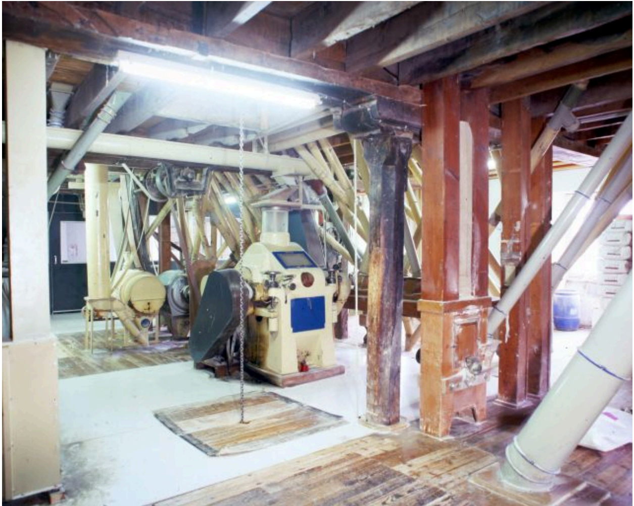
Deuxième étage. Vue d'ensemble depuis l'accès, à l'ouest. Au centre, un broyeur à cylindre.
