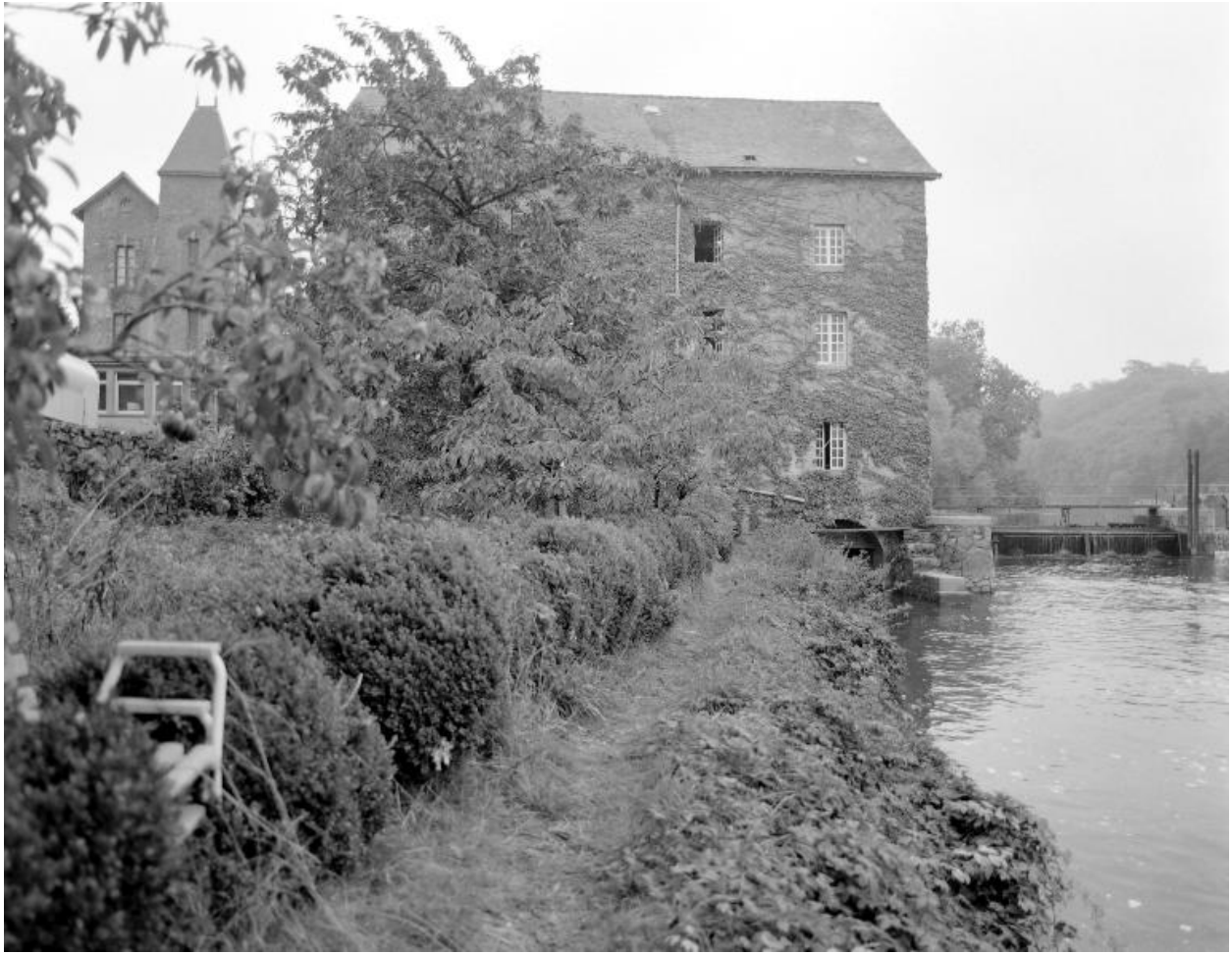
Le moulin et la maison vus du sud-ouest, en aval.
