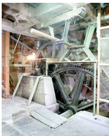
Rez-de-chaussée, partie sud-est. Le mécanisme de transmission, vu de l'ouest. Phot. François Lasa IVR52_20025300775XA
