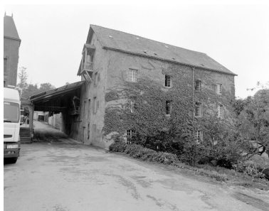
La façade sud-ouest du moulin, depuis la cour antérieure. Phot. François Lasa IVR52_20025301234X
