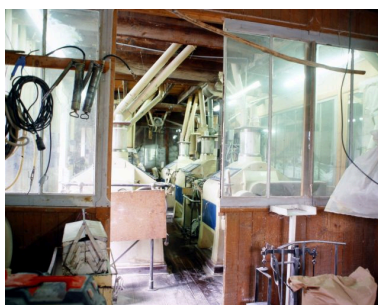
Premier étage. Les broyeurs à cylindres, vus du nord-est. Phot. François Lasa IVR52_20025300779XA
