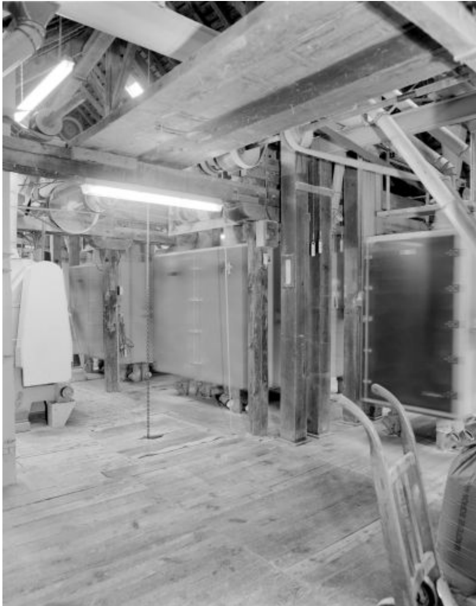
Comble. Les plansichters, vus de l'ouest.
