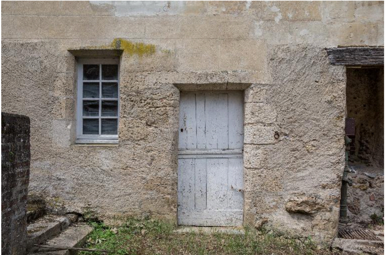
Maison, mur-pignon (?), rez-de-chaussée : baies à encadrement chanfreiné.
