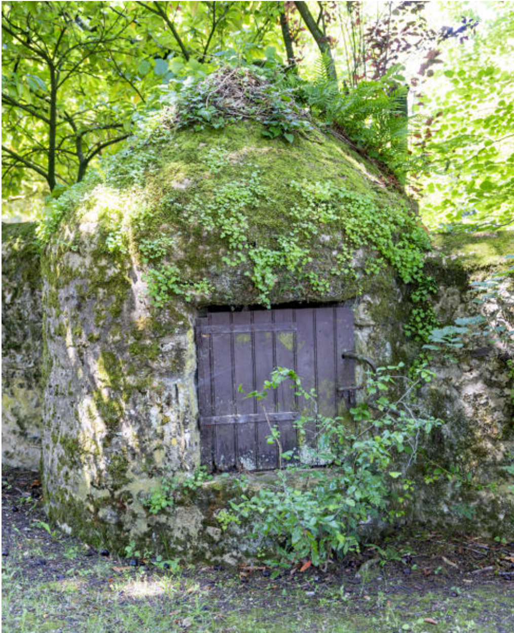
Puits situé le long du mur de clôture.
