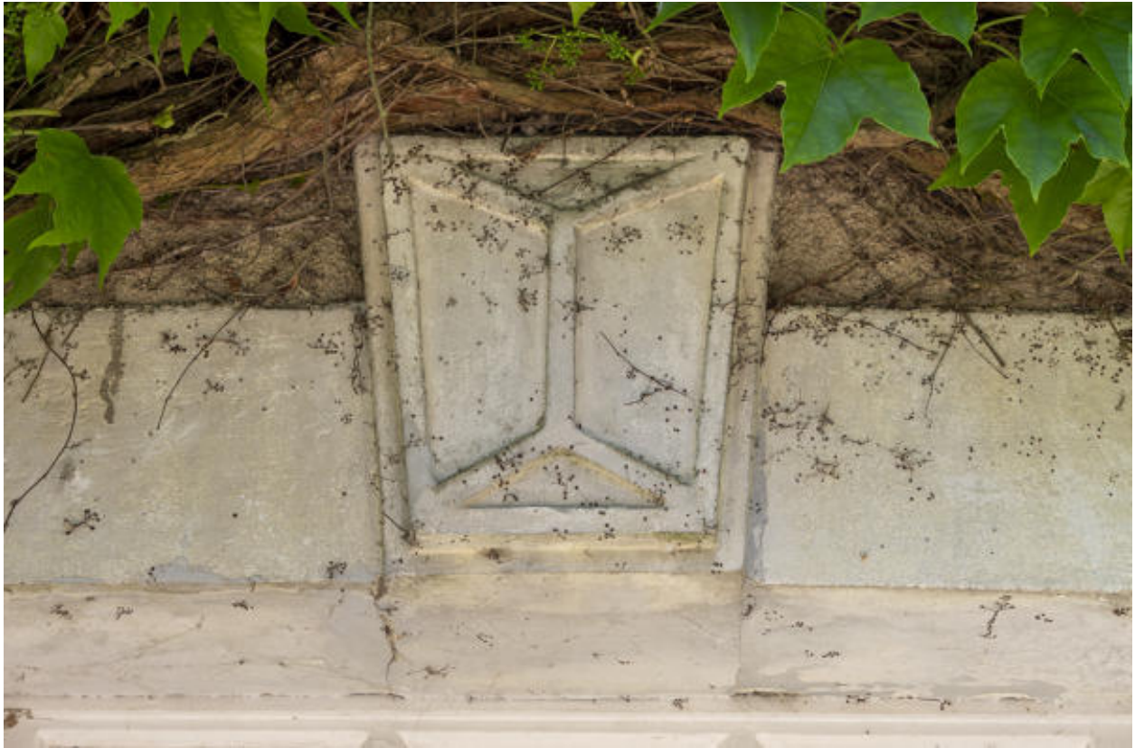
Détail d'une clé en pointe de diamant d'une des baies de la façade principale du prieuré.
