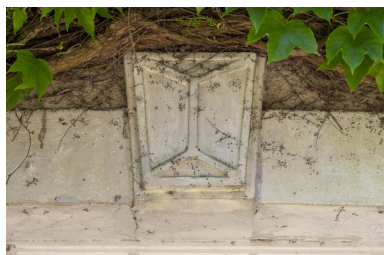
Détail d'une clé en pointe de diamant d'une des baies de la façade principale du prieuré. Phot. Pierre-Bernard Fourny IVR52_20217201153NUCA
