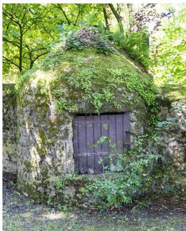
Puits situé le long du mur de clôture. Phot. Pierre-Bernard Fourny IVR52_20217201151NUCA
