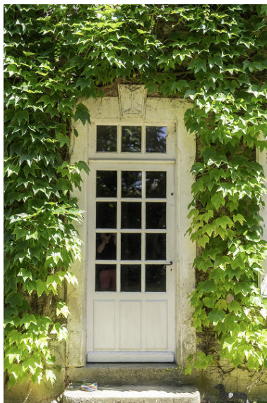
Porte d'entrée du prieuré. Phot. Pierre-Bernard Fourny IVR52_20217201152NUCA
