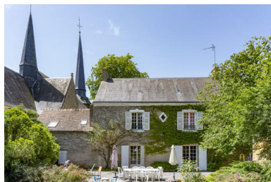
Vue de la façade postérieure du prieuré. Phot. Pierre-Bernard Fourny IVR52_20217201155NUCA
