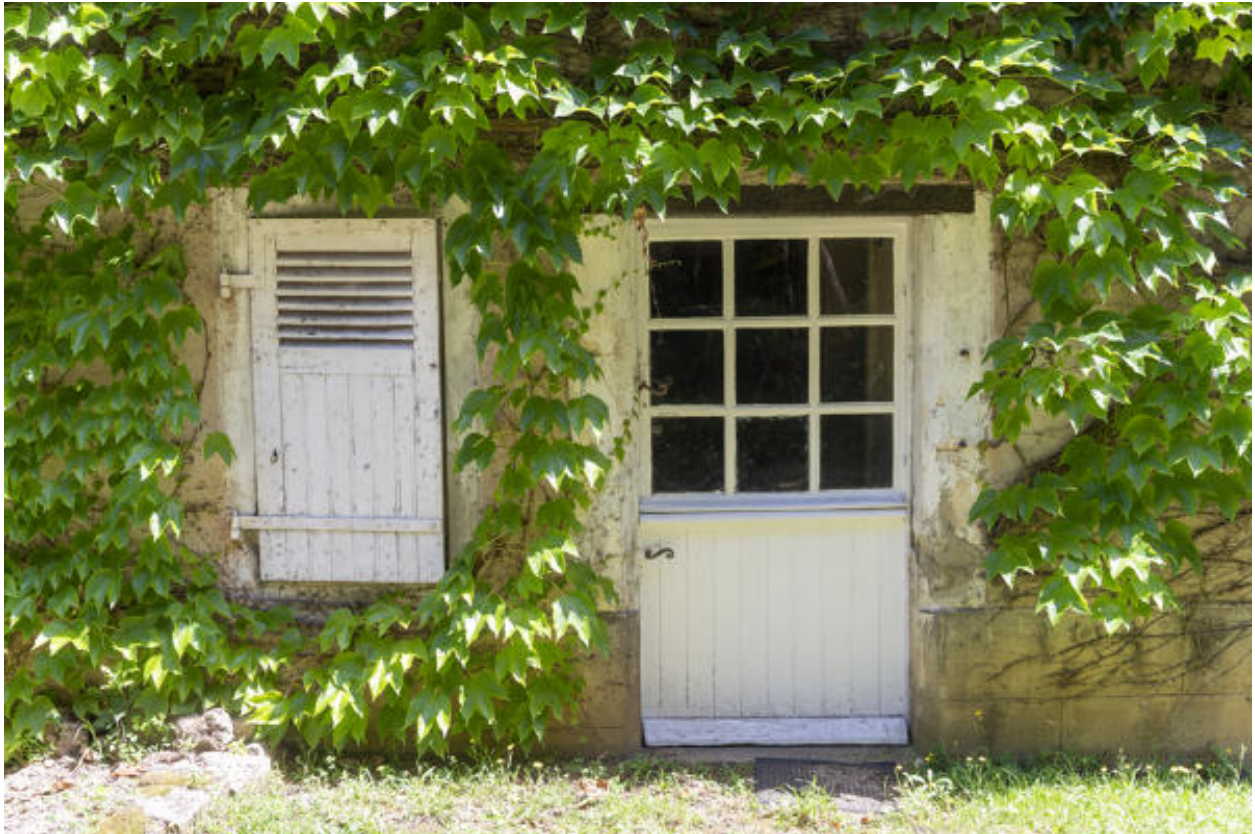
Vue des baies du petit bâtiment accolé au nord du logis principal.
