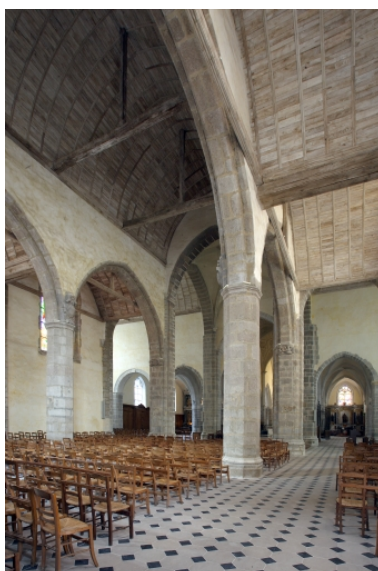
Nef et collatéraux restaurés : vue d'ensemble depuis le bas du collatéral droit. Phot. François Lasa IVR52_20065300637NUCA
