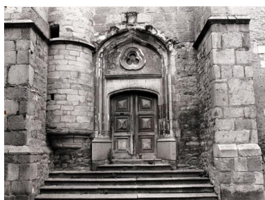
Premier bas-côté droit de la nef, élévation antérieure, vue de détail : porte. Phot. François Lasa IVR52_19855300255X
