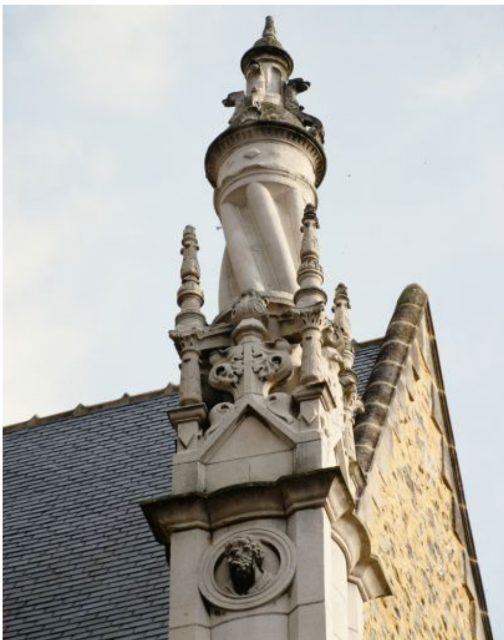
Elévation antérieure, contrefort : vue d'ensemble.
