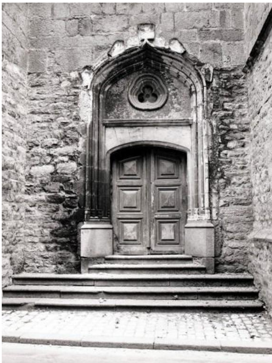
Premier bas-côté gauche de la nef, élévation antérieure, vue de détail : porte.
