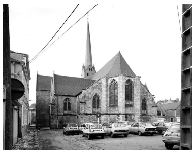
Vue d'ensemble depuis le sud. Phot. Patrice Giraud IVR52_19825300555V
