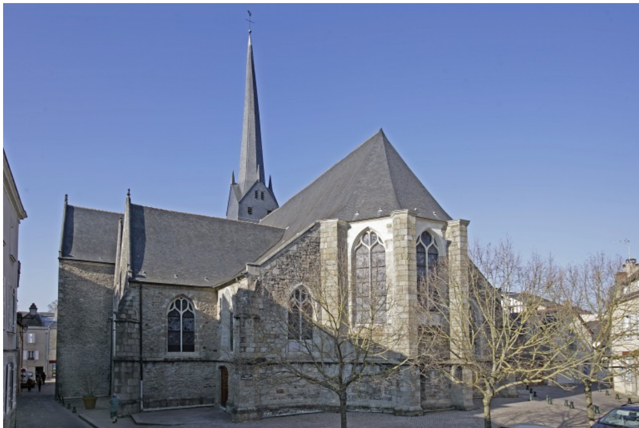
Chevet restauré : vue d'ensemble depuis le sud.
