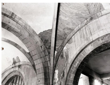
Bas-côté latéral gauche, première travée, vue de détail : voûte. Phot. François Lasa IVR52_19855300261X
