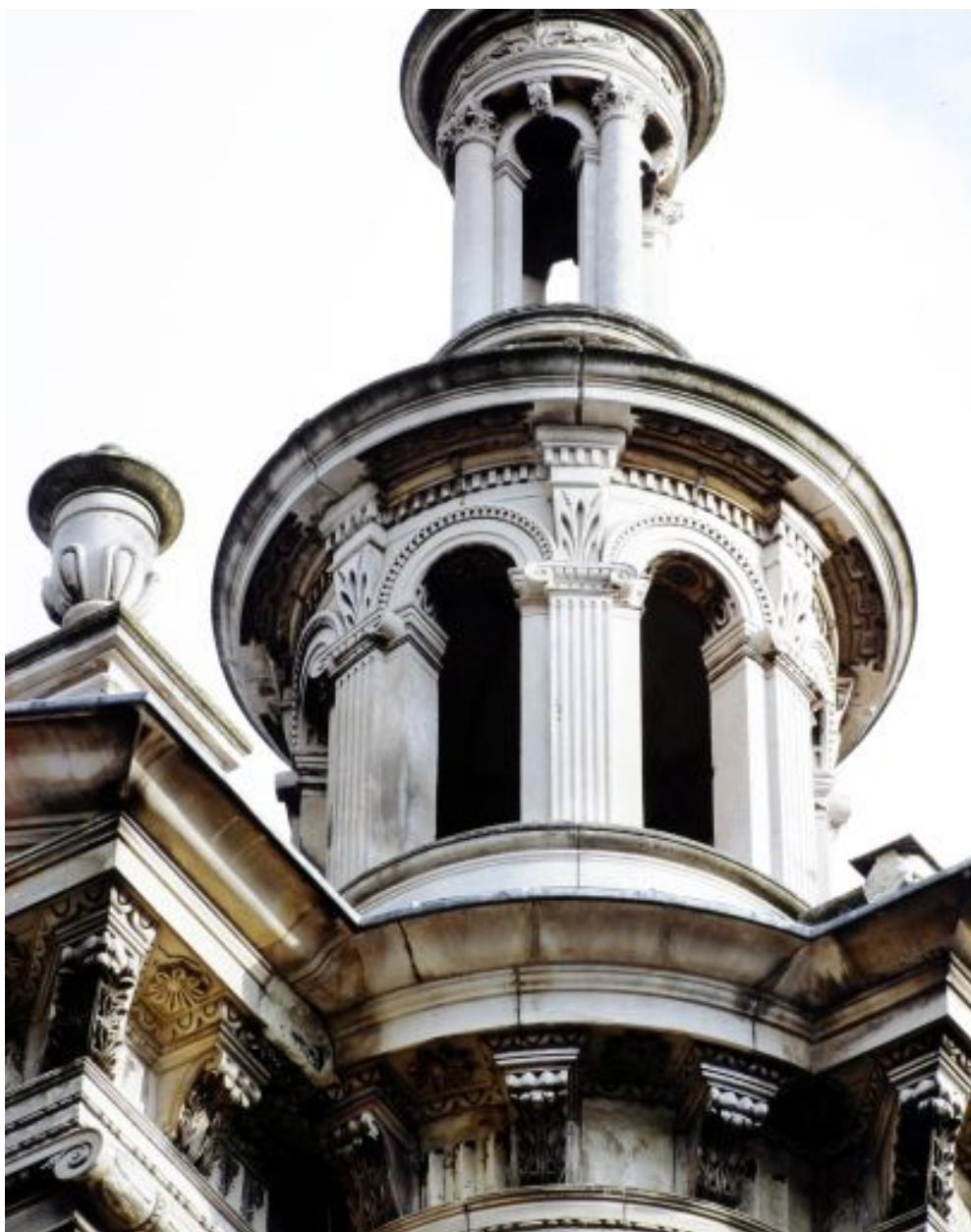
Couronnement de la tourelle d'escalier composé d'une lanterne surmontée d'un lanternon : vue d'ensemble.
