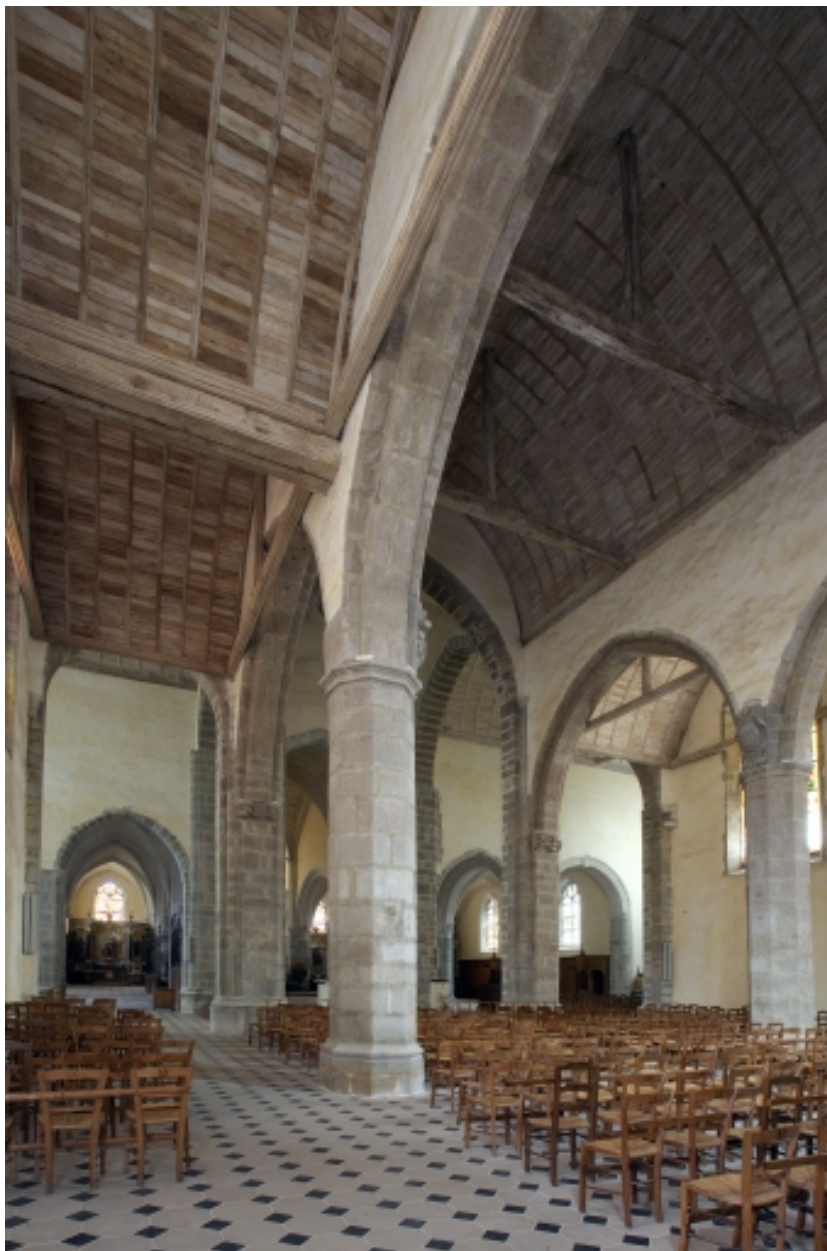
Nef et collatéraux restaurés : vue d'ensemble depuis le bas du collatéral gauche.
