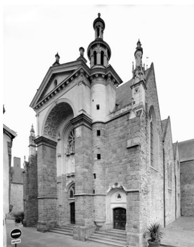
Elévation antérieure : vue d'ensemble. Phot. François Lasa IVR52_20015300133V
