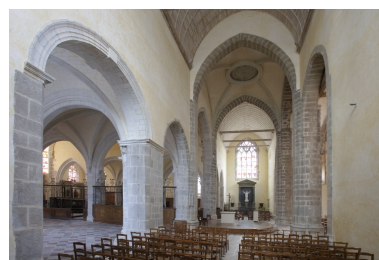
Transept, bras droit restauré : vue d'ensemble depuis le bras gauche. Phot. François Lasa IVR52_20065300646NUCA
