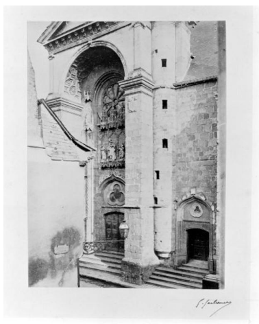
Elévation antérieure, vue de détail : le porche. Phot. François Lasa IVR52_19985300172X
