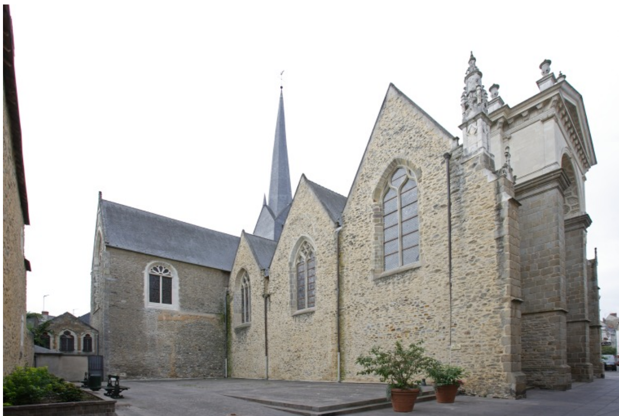
Bas-côté gauche et bras gauche du transept restaurés : vue d'ensemble.
