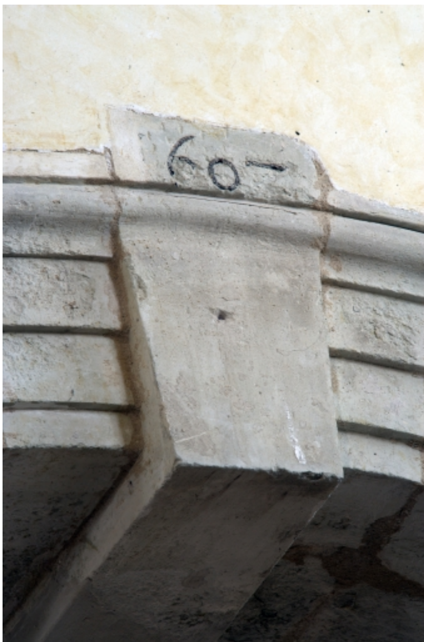
Arcade restaurée reliant le bras droit du transept au deuxième collatéral droit du choeur, vue de détail : clé avec date portée.
