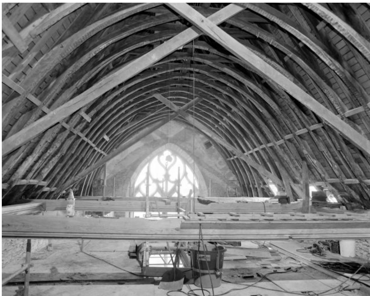
Charpente en cours de restauration, bras droit du transept : vue d'ensemble depuis la croisée.
