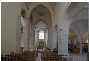
Transept, bras gauche restauré : vue d'ensemble depuis le bras droit. Phot. François Lasa IVR52_20065300647NUCA
