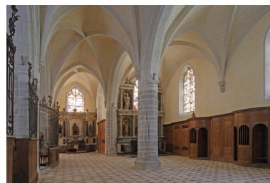
Choeur, collatéraux droit après restauration : vue d'ensemble depuis le bras droit du transept. Phot. François Lasa IVR52_20065300656NUCA
