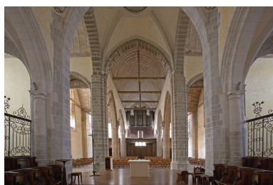
Nef restaurée : vue d'ensemble depuis le chœur. Phot. François Lasa IVR52_20065300643NUCA
