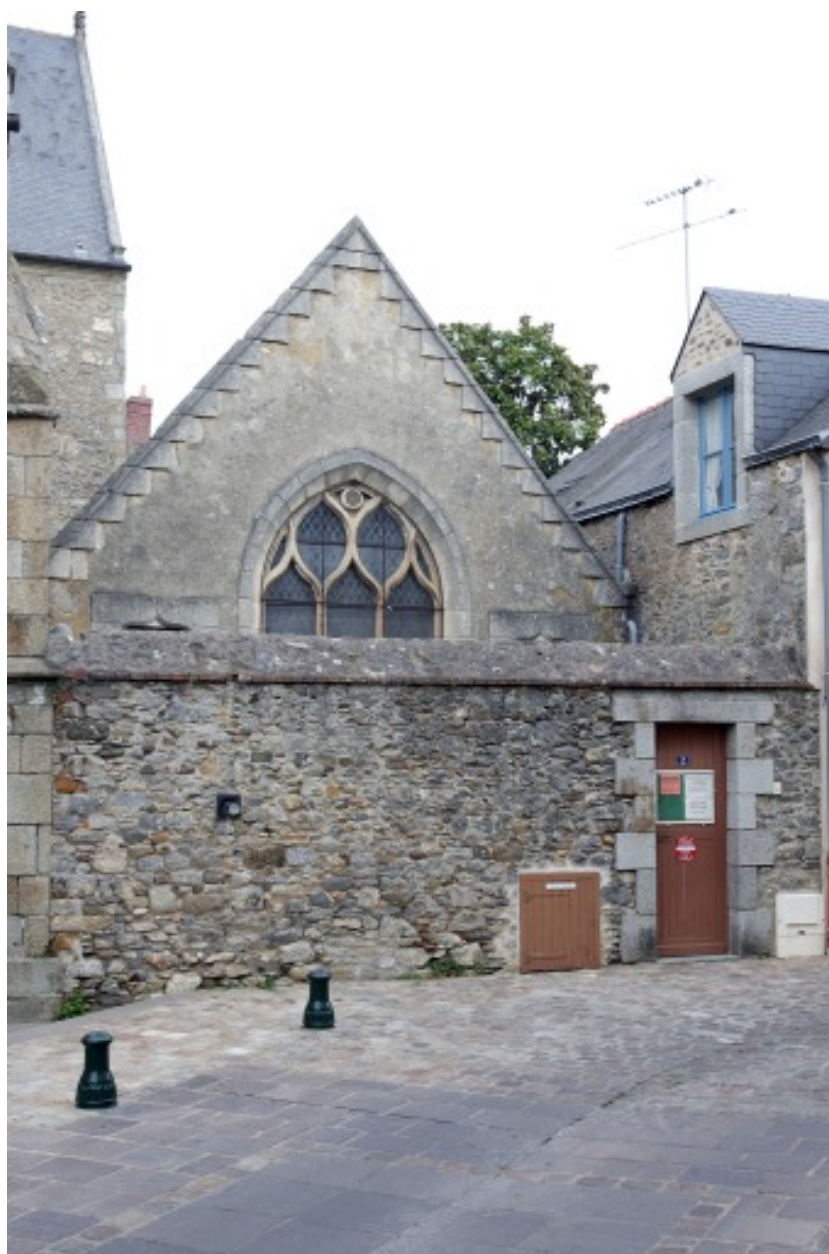
Chapelle de semaine, élévation sud : vue d'ensemble.
