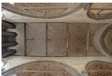
Nef, voûte restaurée : vue géométrale. Phot. François Lasa IVR52_20065300638NUCA
