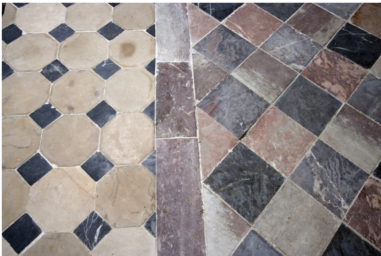
Jonction du premier collatéral droit du choeur et du déambulatoire, vue de détail : pavage restauré.
