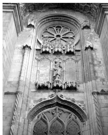
élévation antérieure, porche central : vue d'ensemble. Phot. Patrice Giraud IVR52_19825300629X
