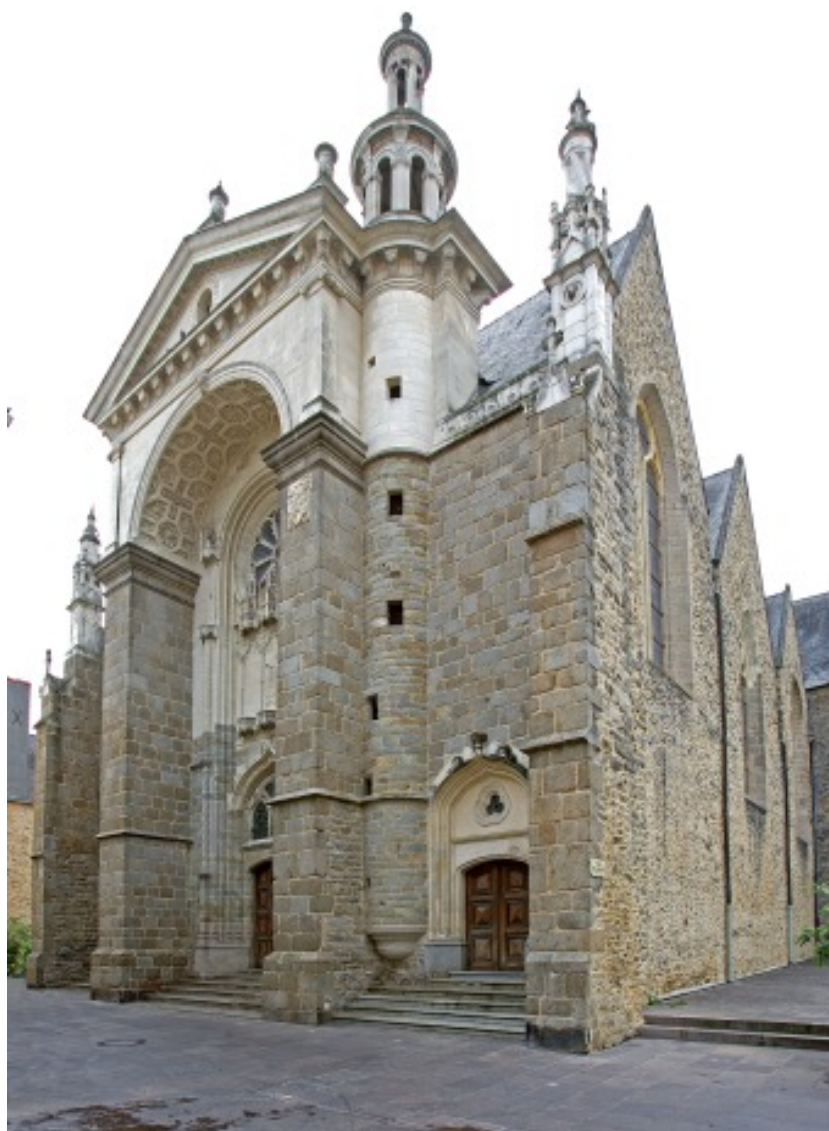
Façade principale restaurée : vue d'ensemble.
