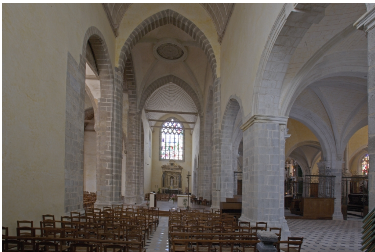
Transept, bras gauche restauré : vue d'ensemble depuis le bras droit.
