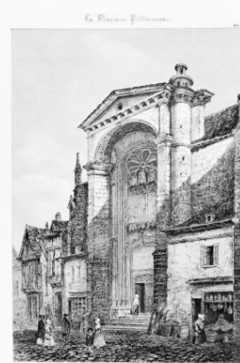
Elévation antérieure : vue d'ensemble. Autr. Jean-Baptiste Messager, Phot. François Lasa IVR52_20025300027X
