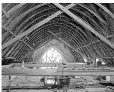
Charpente en cours de restauration, bras droit du transept : vue d'ensemble depuis la croisée. Phot. François Lasa IVR52_20005300365X
