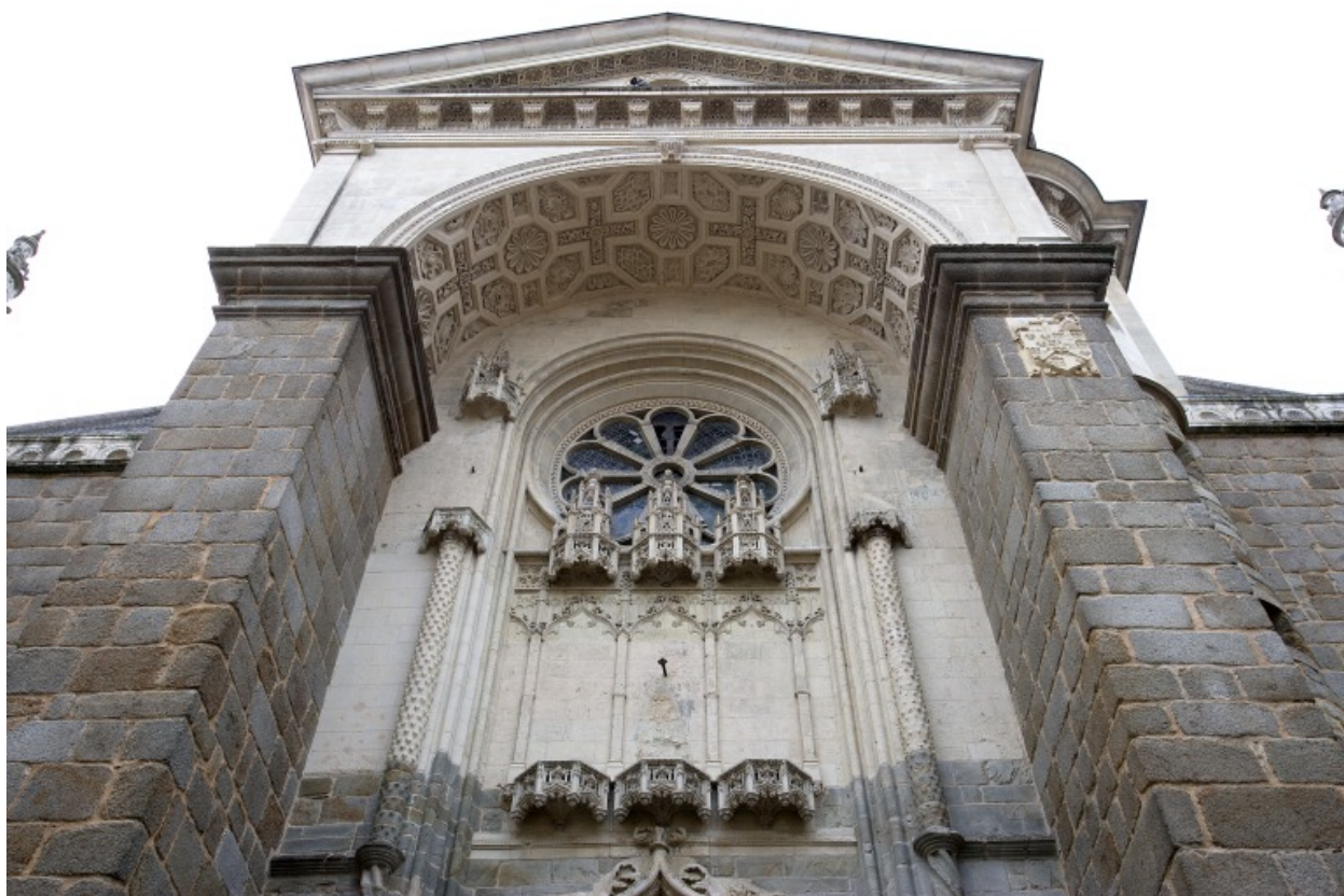
Nef, façade antérieure, portail, vue de détail : partie haute restaurée.
