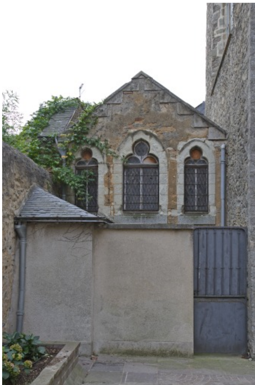
Chapelle de semaine, élévation antérieure : vue d'ensemble.
