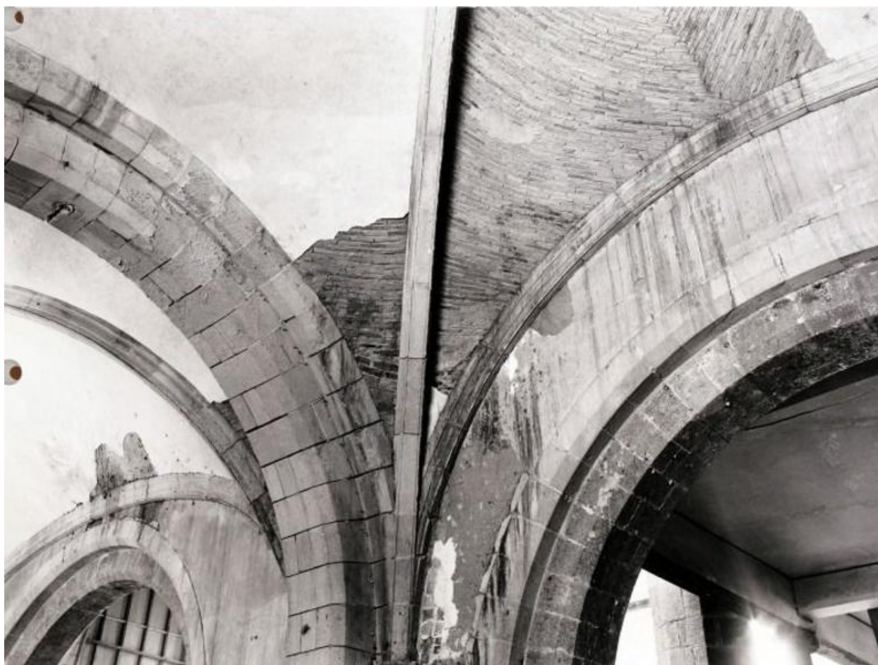
Bas-côté latéral gauche, première travée, vue de détail : voûte.
