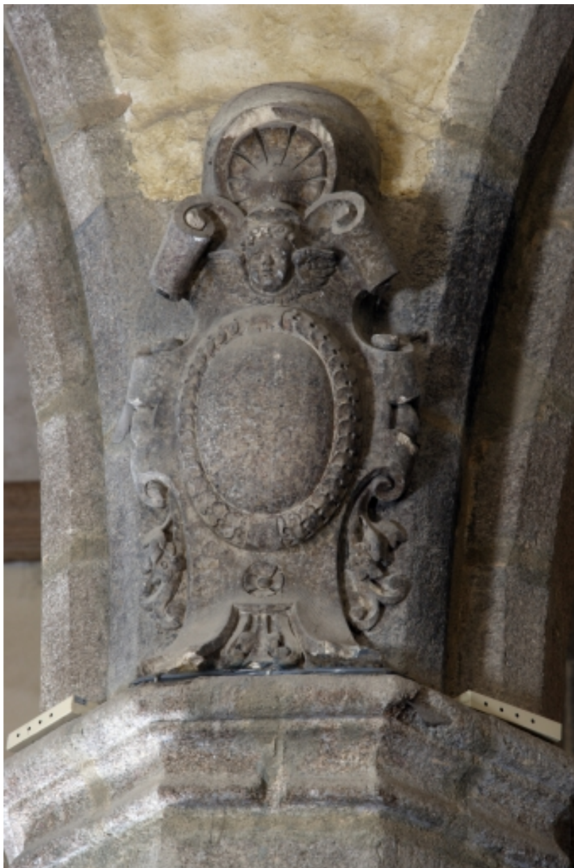
Nef restaurée, deuxième colonne droite, vue de détail : cartouche avec médaillon.
