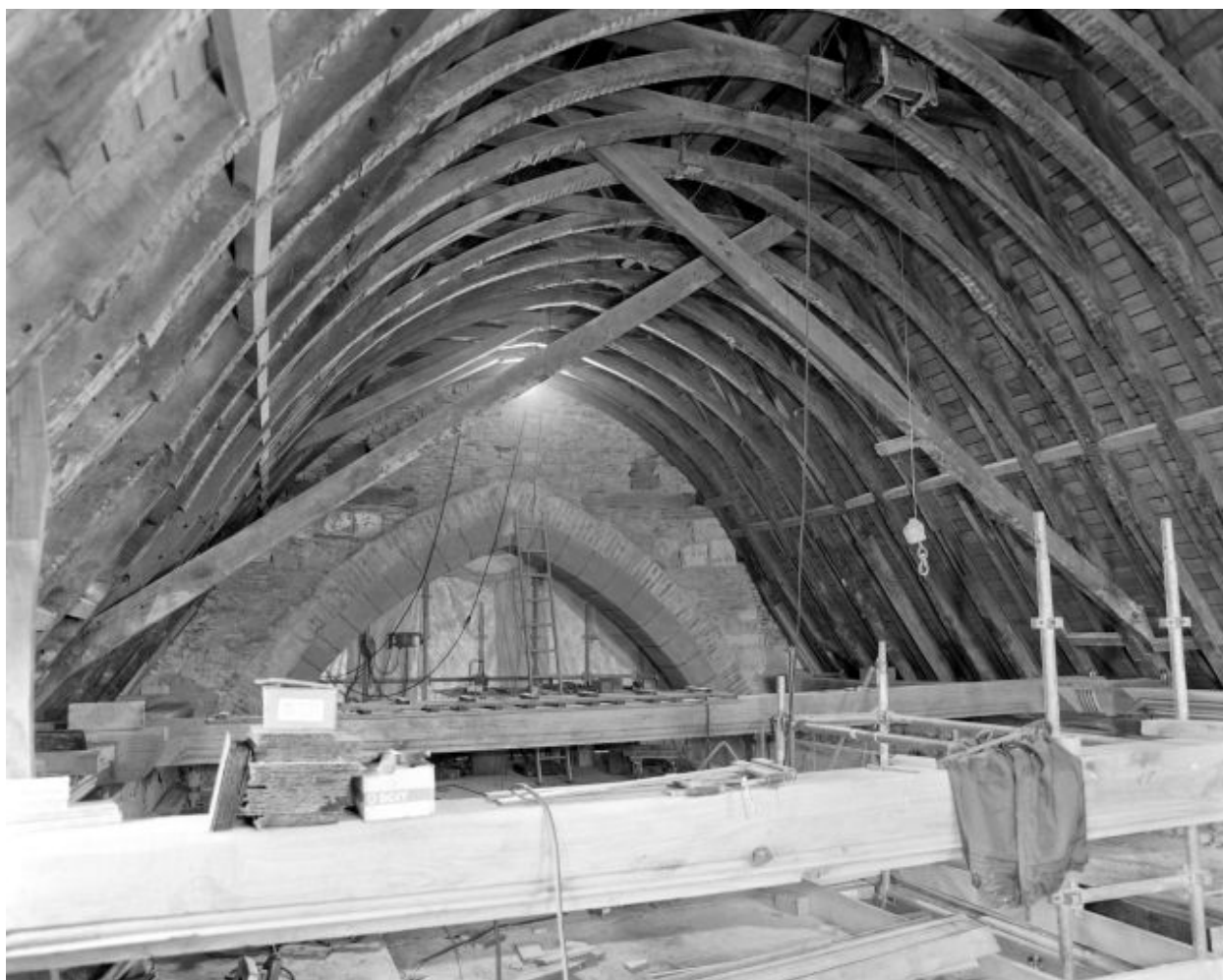
Charpente en cours de restauration, bras droit du transept : vue d'ensemble vers la croisée.
