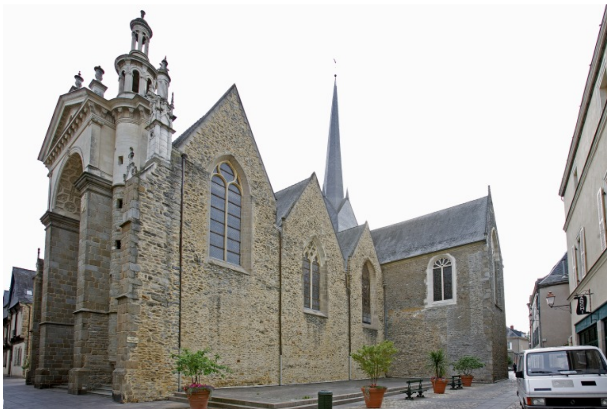
Bas-côté droit et bras droit du transept restaurés : vue d'ensemble.
