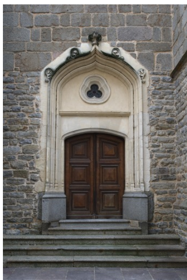
Nef, premier bas-côté gauche, élévation antérieure, vue de détail : porte restaurée. Phot. François Lasa IVR52_20065300856NUCA
