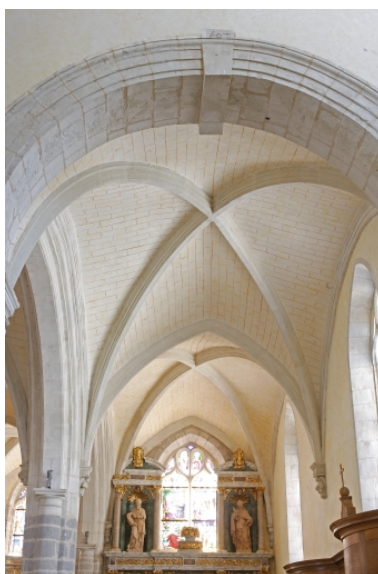
Deuxième collatéral droit du chœur, voûte restaurée : vue d'ensemble vers le sud. Phot. François Lasa IVR52_20065300660NUCA
