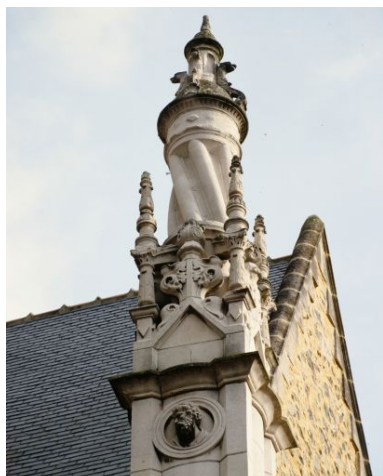
Elévation antérieure, contrefort : vue d'ensemble. Phot. François Lasa IVR52_19885300471XA
