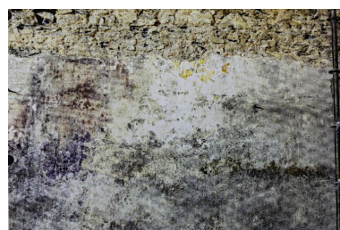
Chœur, collatéral extérieur, mur sud, vue de détail : vestiges de peintures murales. Phot. François Lasa IVR52_20055300478NUCA
