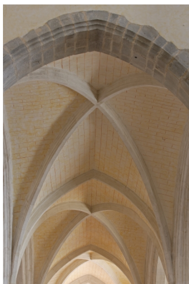
Premier collatéral droit du chœur, voûte restaurée : vue d'ensemble vers le sud. Phot. François Lasa IVR52_20065300659NUCA
