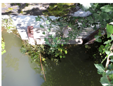
La vanne sur le flanc de la Grande levée de Vix, au bord du Contrebot. Phot. Yannis Suire IVR52_20198503156NUCA
