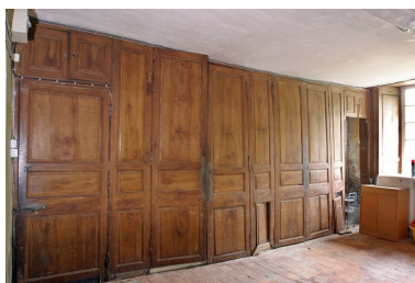
Rez-de-chaussée, salle nord : le mur sud. Phot. François Lasa IVR52_20035302548NUCA
