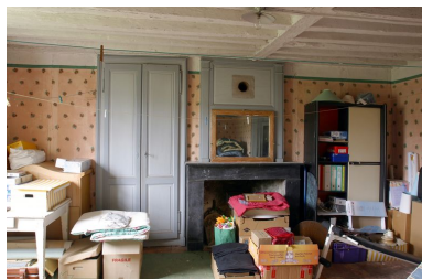
Etage de comble, pièce sud : le mur nord et la cheminée. Phot. François Lasa IVR52_20035302535NUCA
