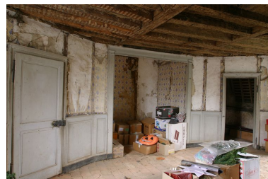
Etage de comble, pièce nord : le mur sud et l'alcôve. Phot. François Lasa IVR52_20035302536NUCA
