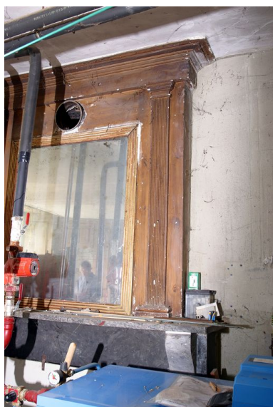
Rez-de-chaussée, salle nord : détail de la cheminée. Phot. François Lasa IVR52_20035302550NUCA
