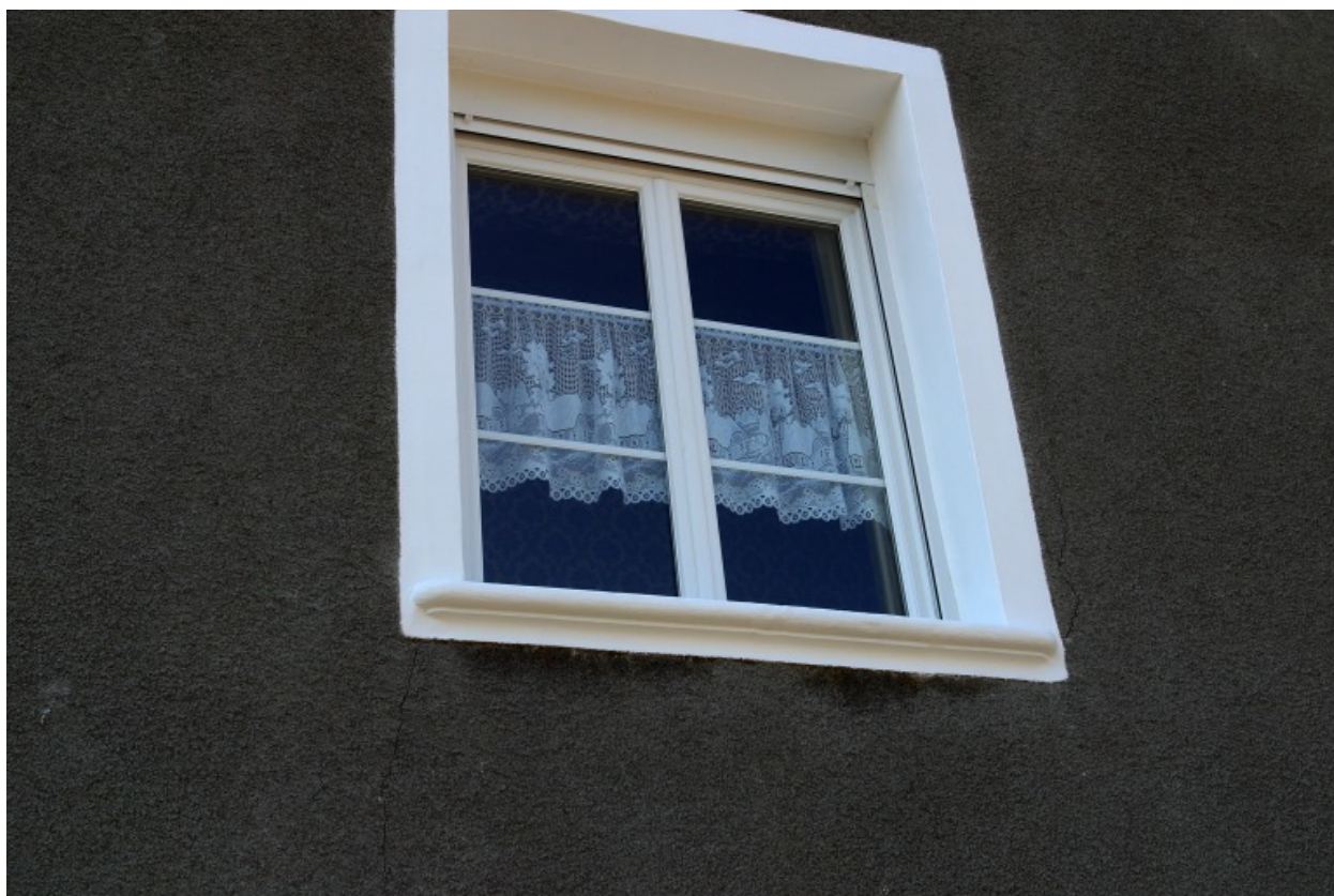
Détail de l'élévation est de l'ancien manoir : fenêtre gauche du premier étage.
