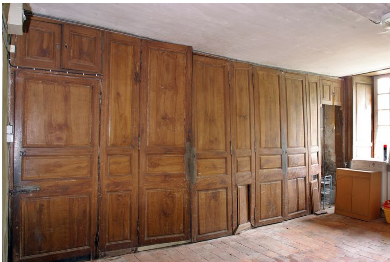
Rez-de-chaussée, salle nord : le mur sud.
