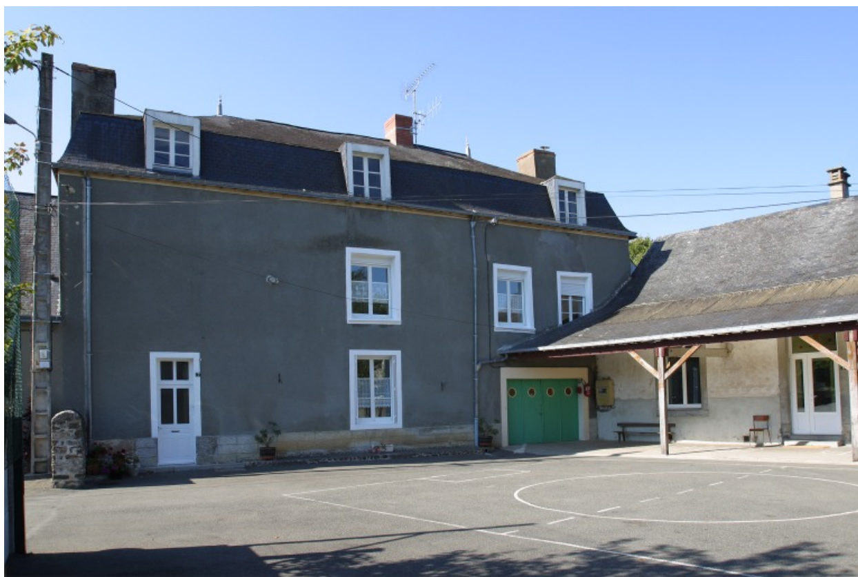
Les élévations est de l'ancien manoir et sud du bâtiment de classe, sur la cour.
