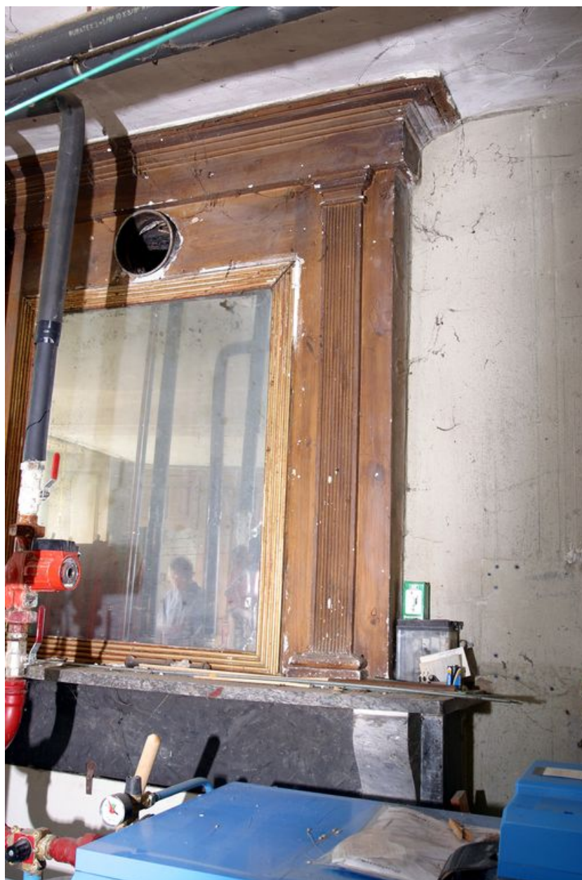
Rez-de-chaussée, salle nord : détail de la cheminée.
