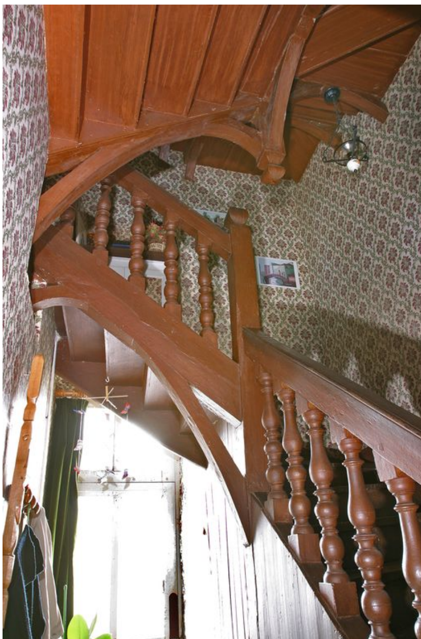
L'escalier vu depuis le rez-de-chaussée.
