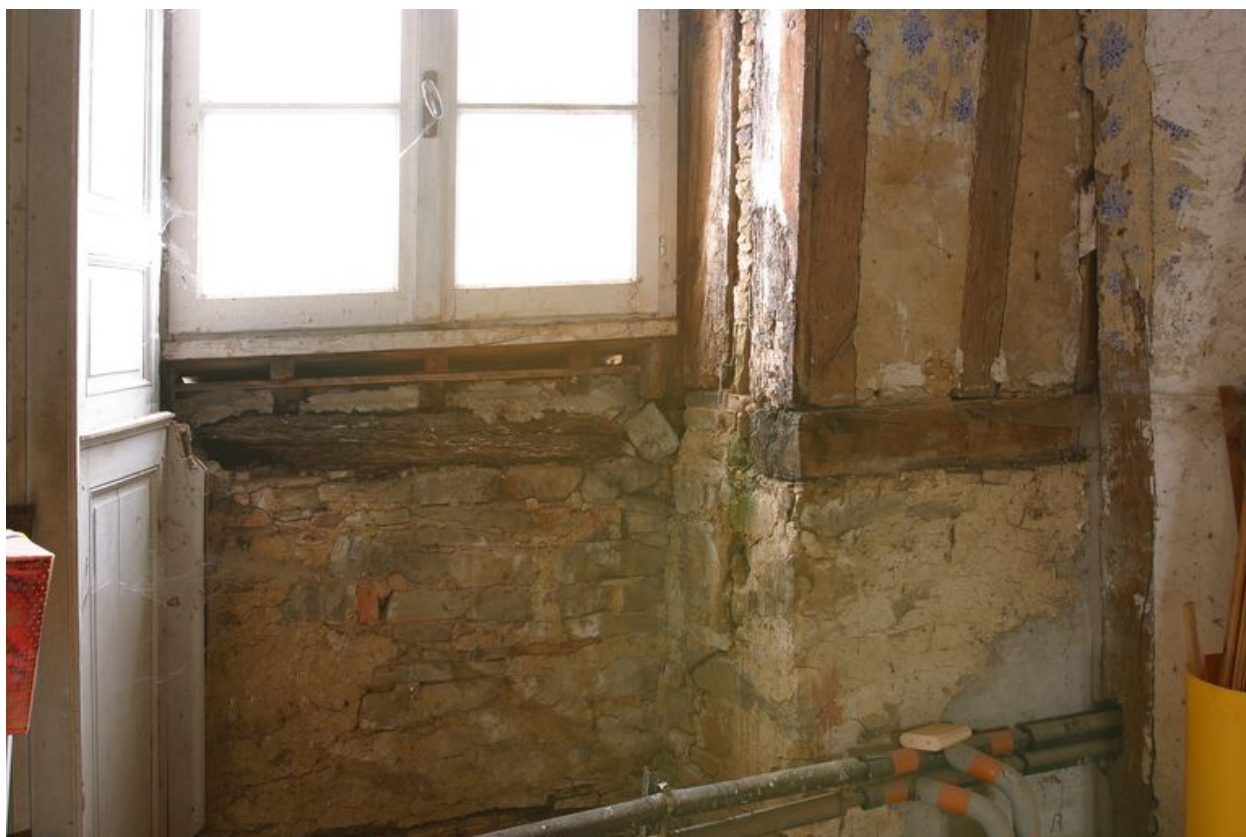
Etage de comble, pièce nord : détail du mur est.
