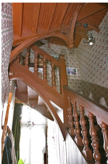
L'escalier vu depuis le rez-de-chaussée. Phot. François Lasa IVR52_20035302546NUCA
