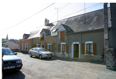
L'ancienne aile de dépendance abritant aujourd'hui trois logements, vue depuis la cour de l'école au nord-est. Phot. François Lasa IVR52_20035302569NUCA
