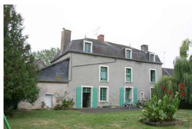
L'élévation ouest de l'ancien manoir, sur jardin. Phot. François Lasa IVR52_20035302551NUCA
