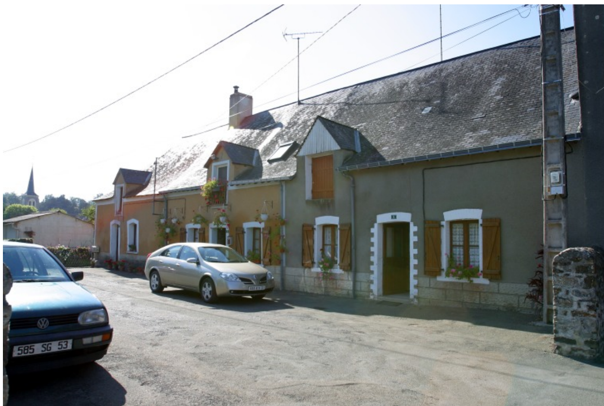
L'ancienne aile de dépendance abritant aujourd'hui trois logements, vue depuis la cour de l'école au nord-est.
