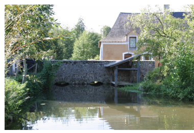
Le pont et le lavoir vus depuis l'est. Phot. François Lasa IVR52_20035302571NUCA
