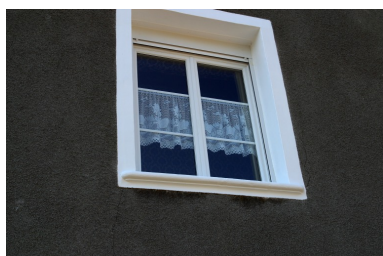
Détail de l'élévation est de l'ancien manoir : fenêtre gauche du premier étage. Phot. François Lasa IVR52_20035302568NUCA
