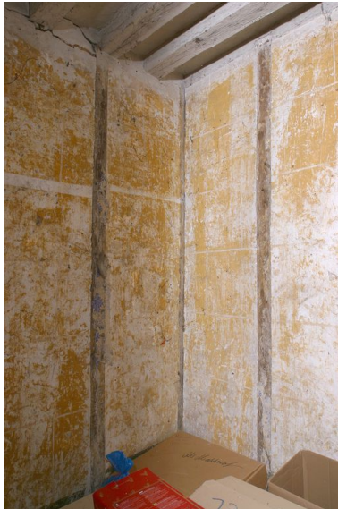
Etage de comble, pièce nord : les murs du garde- robe avec leur faux appareil. Phot. François Lasa IVR52_20035302542NUCA
