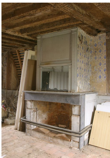
Etage de comble, pièce nord : la cheminée. Phot. François Lasa IVR52_20035302540NUCA
