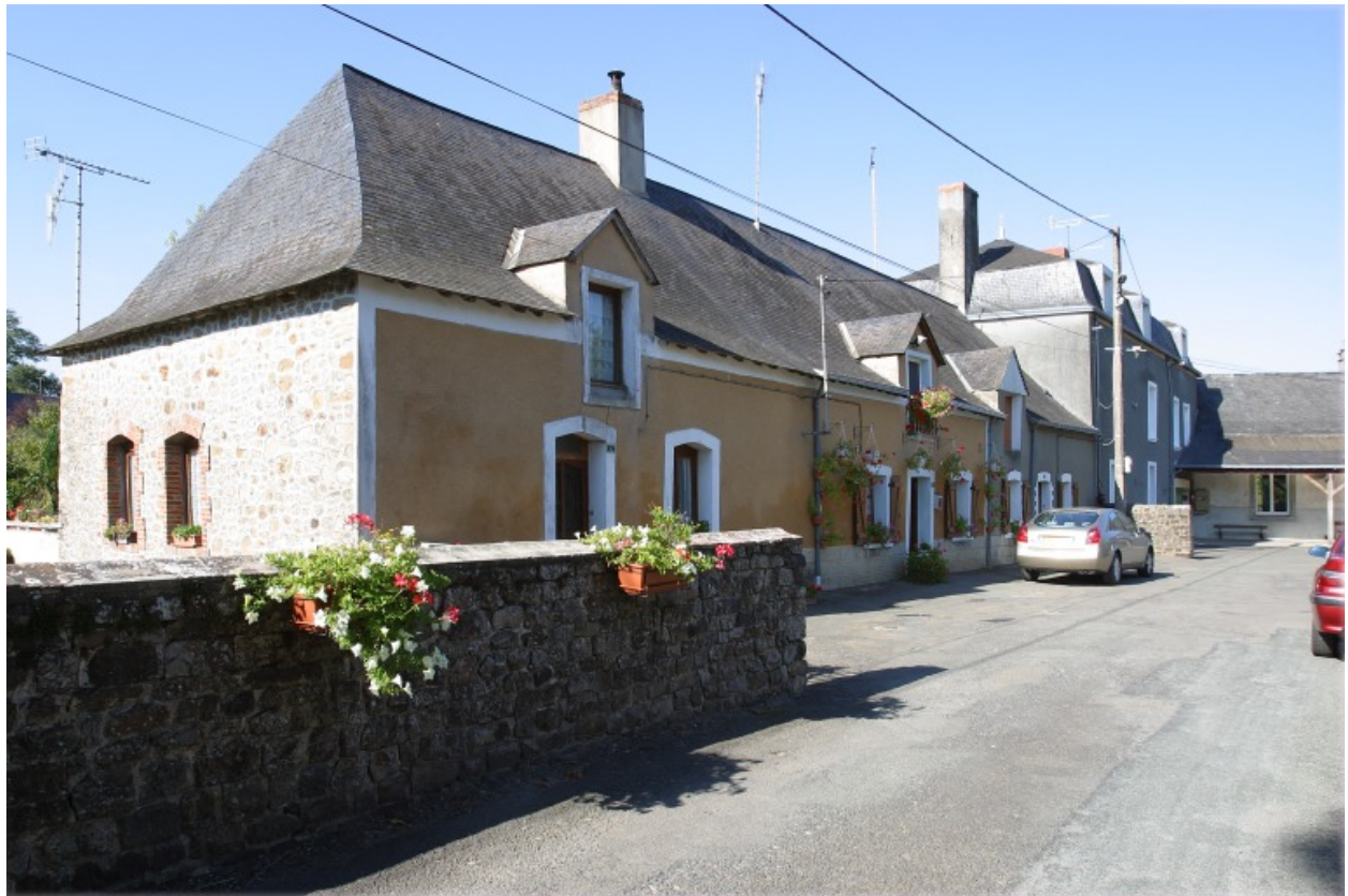
L'ancienne aile de dépendance abritant aujourd'hui trois logements, vue depuis le pont au sud-est.
