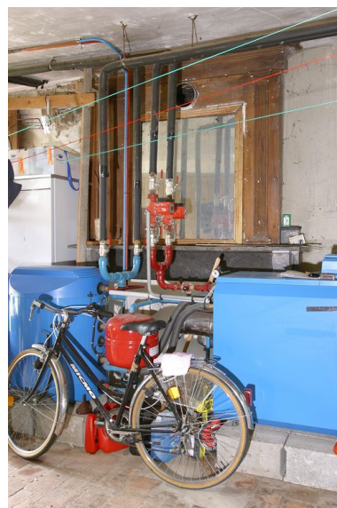
Rez-de-chaussée, salle nord : la cheminée. Phot. François Lasa IVR52_20035302549NUCA
