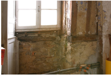
Etage de comble, pièce nord : détail du mur est. Phot. François Lasa IVR52_20035302538NUCA
