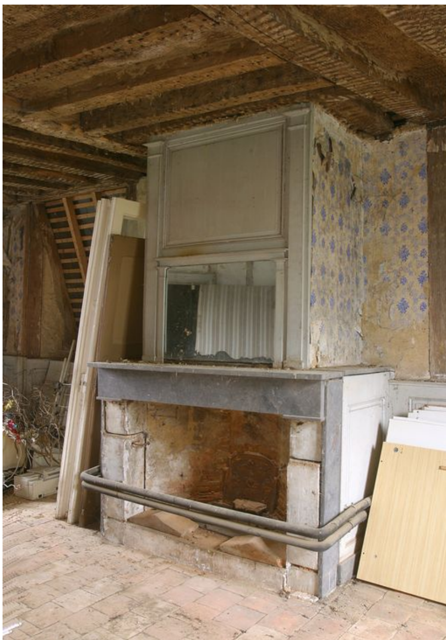
Etage de comble, pièce nord : la cheminée.
