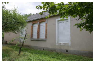
L'élévation nord du bâtiment de classe.. Phot. François Lasa IVR52_20035302507NUCA
