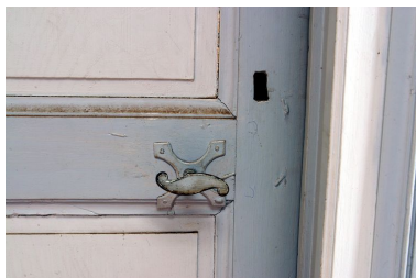
Etage de comble, pièce sud : la serrure de la porte du garde-robe est. Phot. François Lasa IVR52_20035302543NUCA
