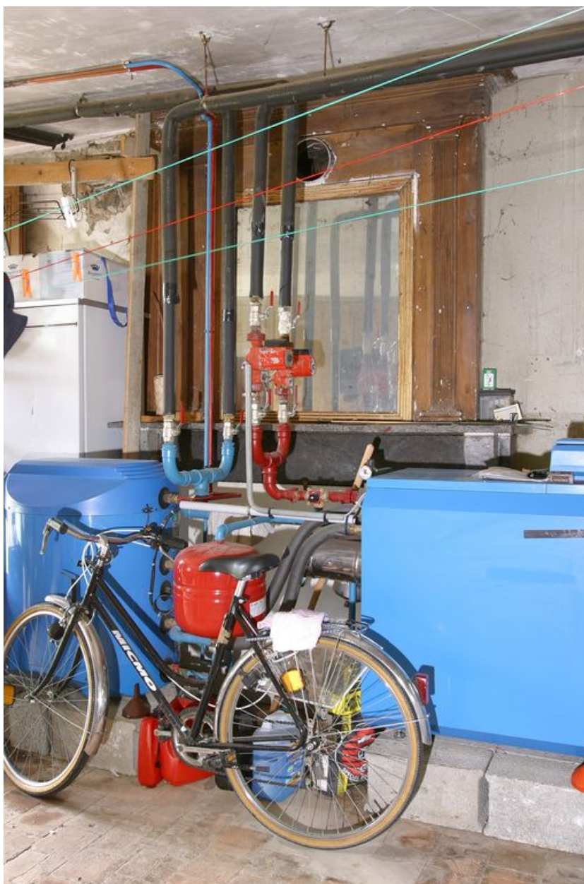
Rez-de-chaussée, salle nord : la cheminée.
