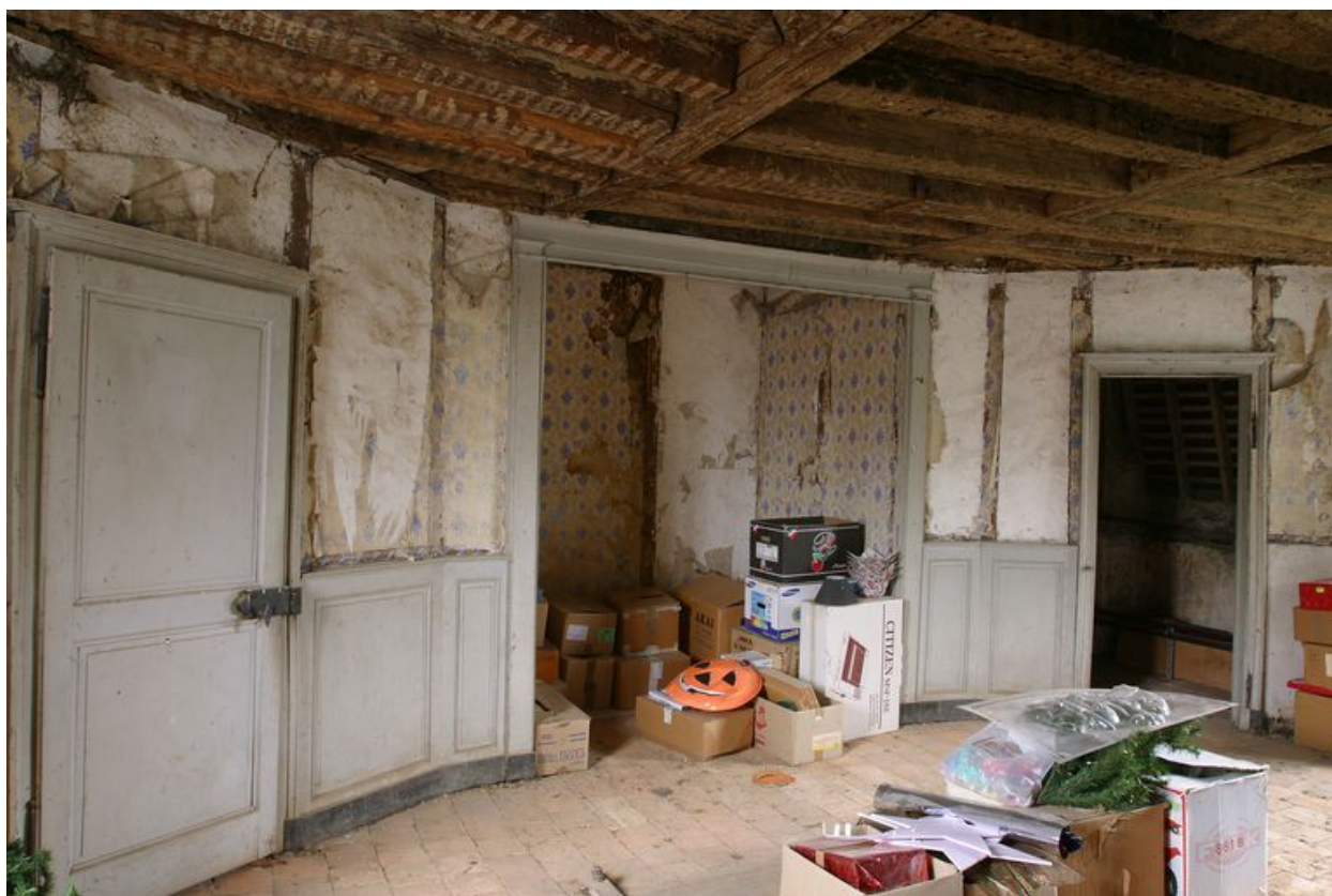
Etage de comble, pièce nord : le mur sud et l'alcôve.
