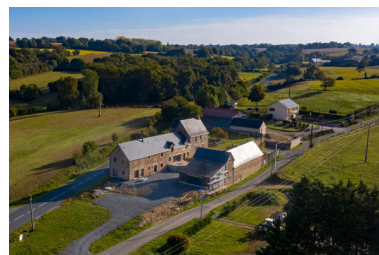
Une vue aérienne des bâtiments, depuis l'ouest. Phot. Pierre-Bernard Fourny IVR52_20215301592NUCA
