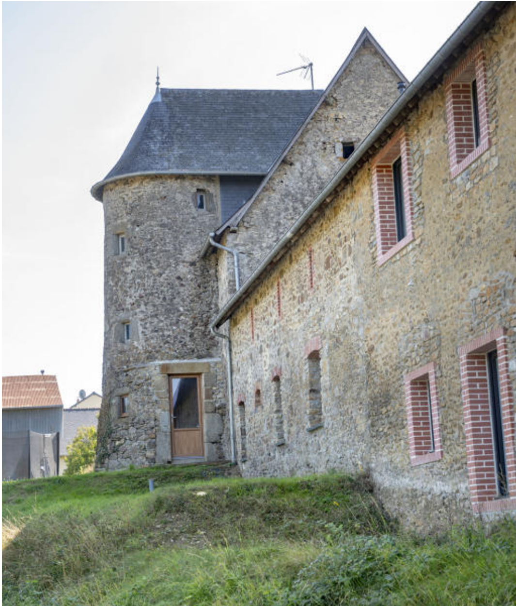
La tour d'escalier du logis.
