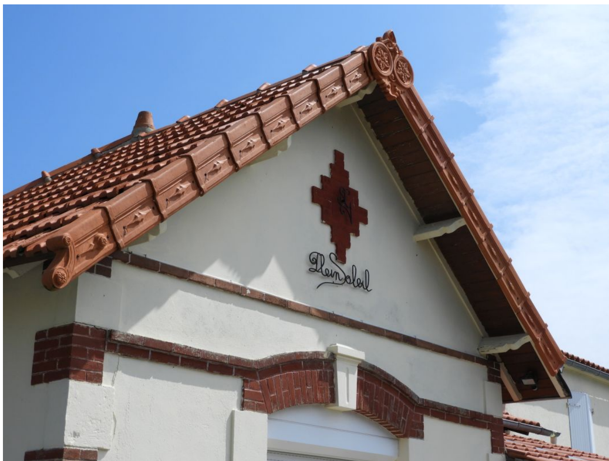
Détail de la façade : débordement de toit, bordure de rive, décor en brique.
