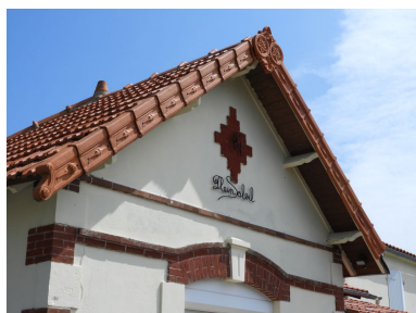
Détail de la façade : débordement de toit, bordure de rive, décor en brique. Phot. Yannis Suire IVR52_20188501376NUCA
