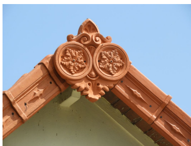
Détail de la bordure de rive. Phot. Yannis Suire IVR52_20188501375NUCA
