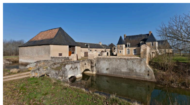
Manoir de la Faverie, Beaumont-Pied-de-Bœuf. Phot. Yves Guillotin IVR52_20127200345NUCA
