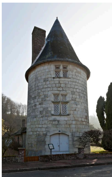
Ultime tour du château de Beaumont-Pied-de-Bœuf (disparu). Phot. Yves Guillotin IVR52_20127200269NUCA
