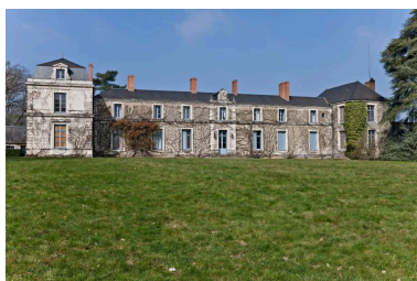
Château de la Couetterie, Beaumont-Pied-de-Bœuf. Phot. Yves Guillotin IVR52_20127200179NUCA
