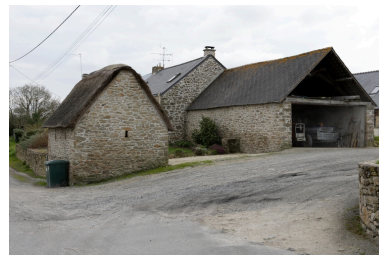
Vue de la remise et de l'étable. Phot. Denis Pillet IVR52_20084400599NUCA
