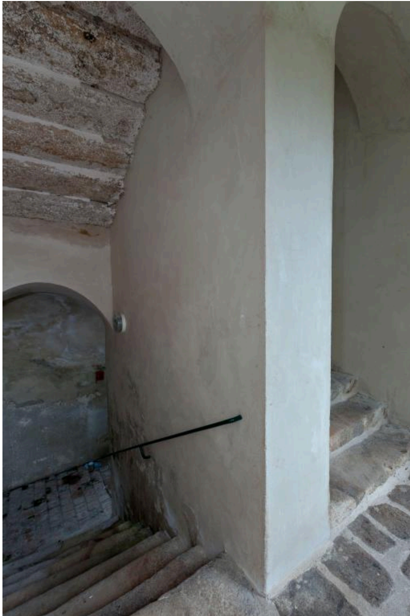
Escalier de l'aile ouest du couvent, premier palier.
