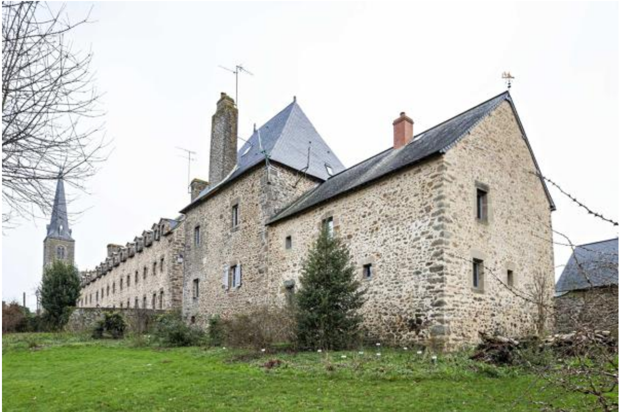
Maison de la prieure et couvent, depuis le nord-ouest.
