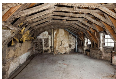
Charpente à chevrons-formant-fermes du corps principal du couvent, vue vers l'ouest Phot. Yves Guillotin IVR52_20195300021NUCA
