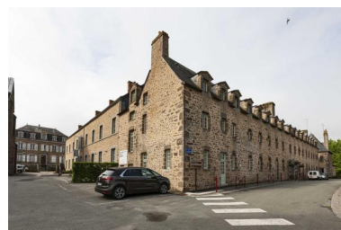
Ancien couvent de Lassay, aujourd'hui école primaire, vu depuis le nord-est. Phot. Yves Guillotin IVR52_20195301167NUCA
