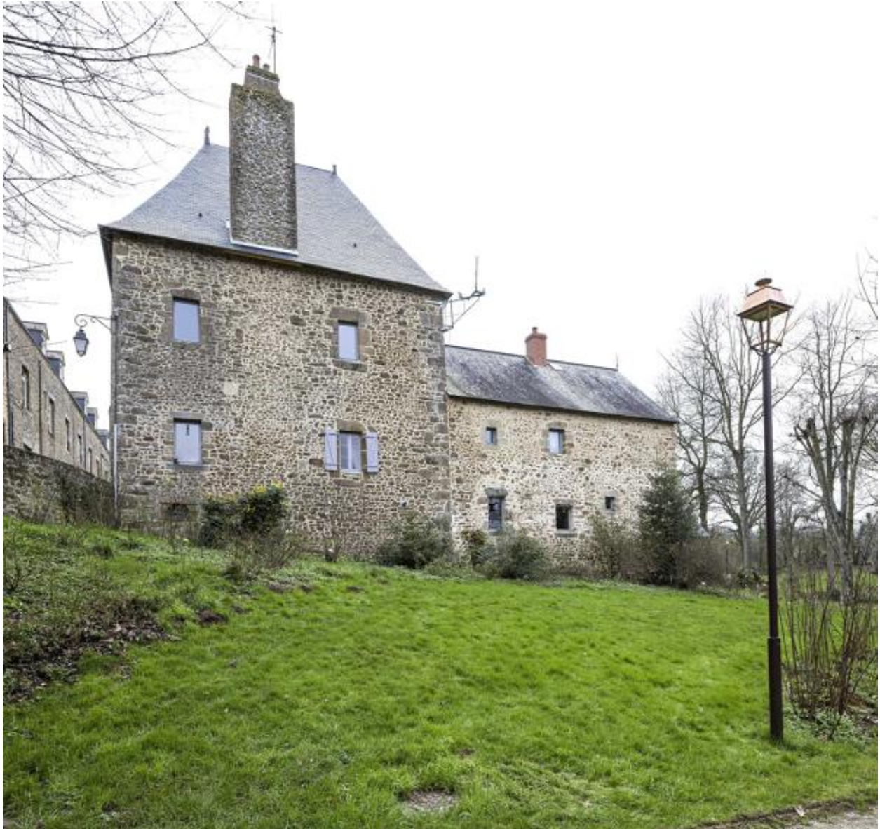
Maison de la prieure, vue depuis le nord.
