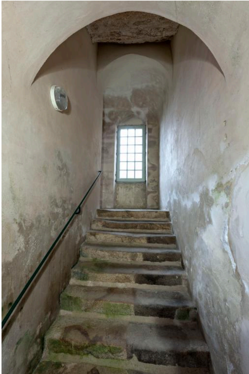
Première volée de l'escalier ouest du couvent
