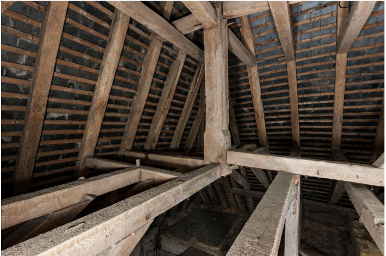
Charpente du pavillon dit "Pavillon de l'Horloge" - détail
