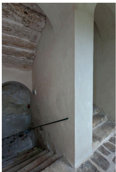
Escalier de l'aile ouest du couvent, premier palier. Phot. Yves Guillotin IVR52_20195300012NUCA
