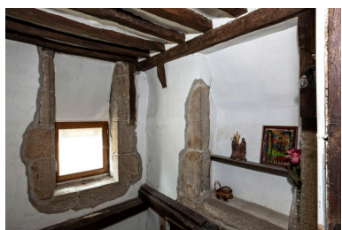
Maison, dite "Pavillon de l'Horloge", vue de deux ouvertures au premier étage de la cage d'escalier Phot. Yves Guillotin IVR52_20195300003NUCA
