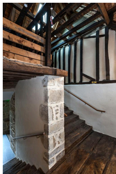
Escalier est du corps principal du couvent Phot. Yves Guillotin IVR52_20195300023NUCA
