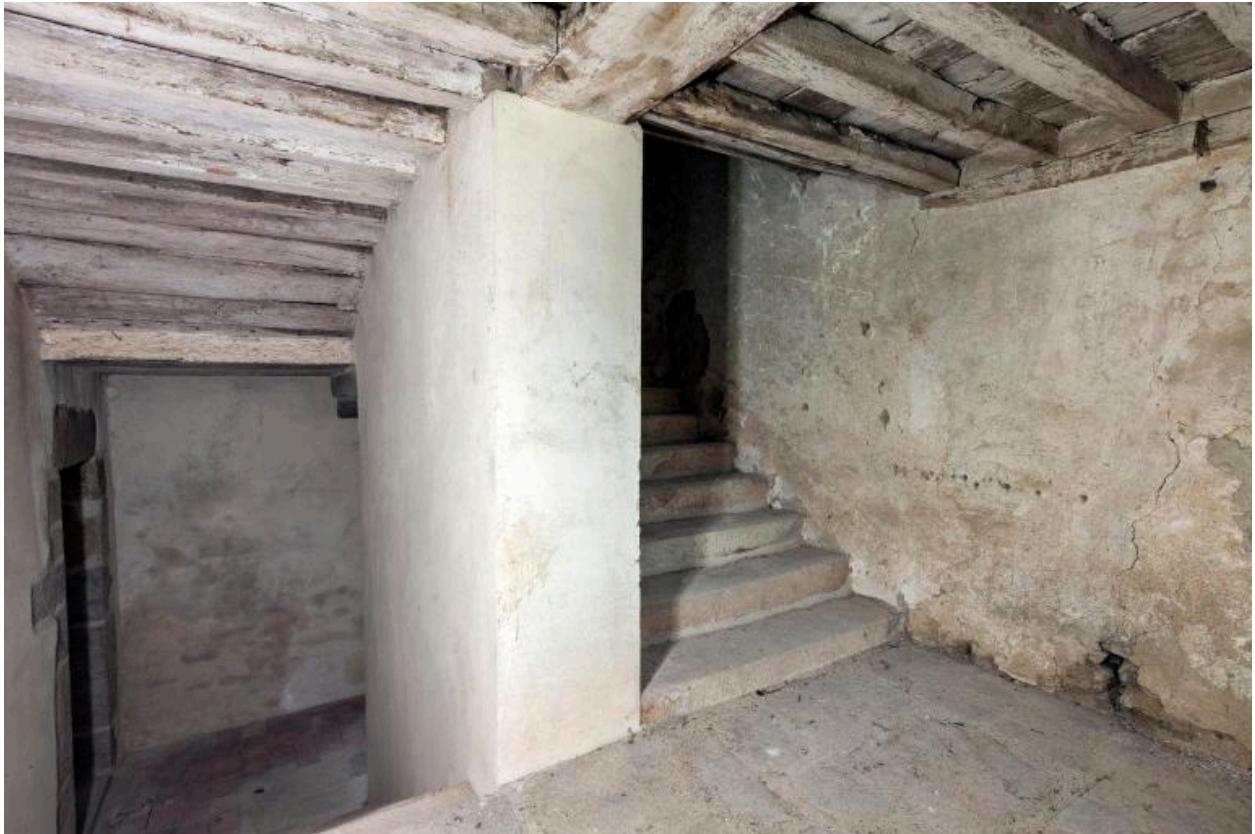
Dernières volées de l'escalier ouest du corps principal du couvent
