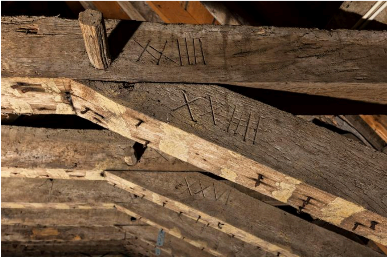
Détail de marques de charpentier sur la charpente du corps principal du couvent
