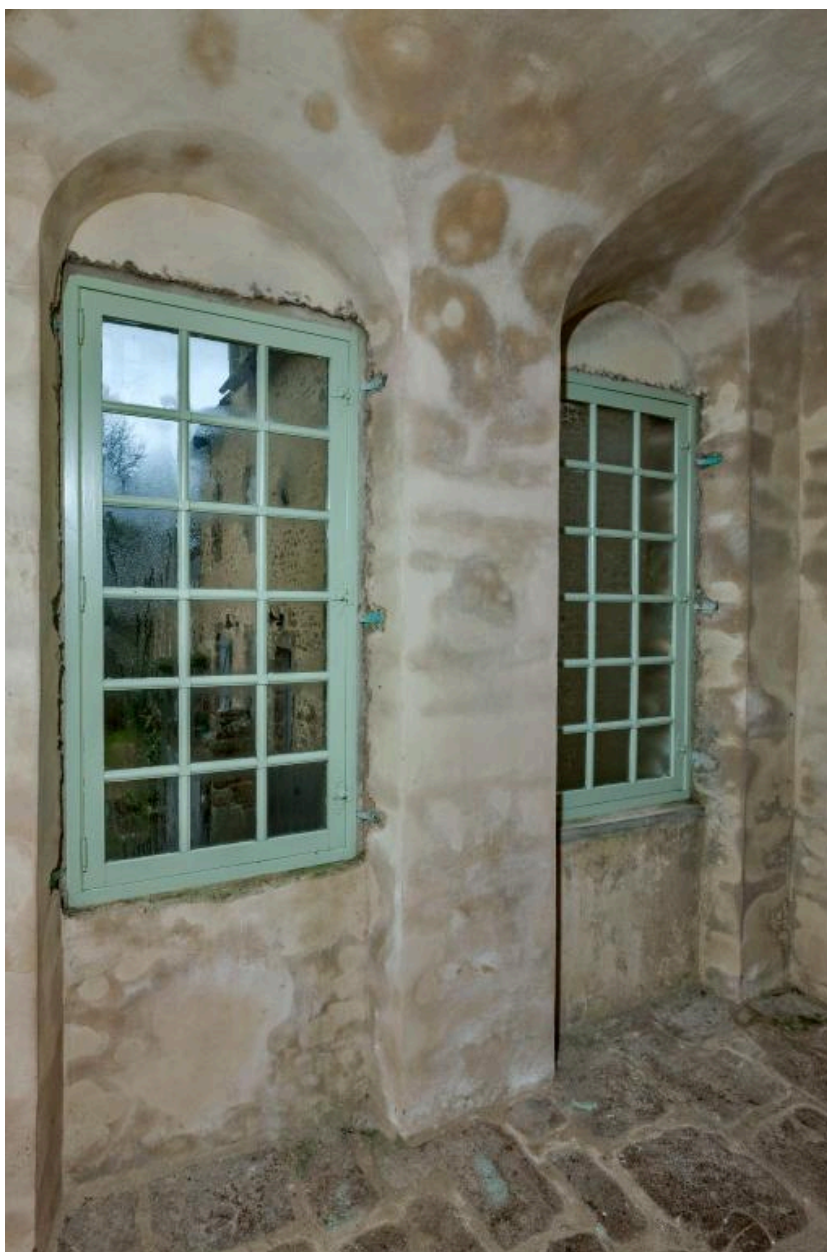
Fenêtres du palier entre le rez-de-chaussée et le premier niveau, escalier ouest du couvent
