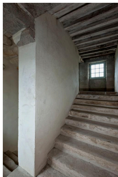
Vue depuis le palier du premier niveau de l'escalier ouest du corps principal du couvent Phot. Yves Guillotin IVR52_20195300015NUCA
