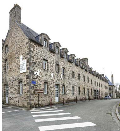
Corps de bâtiment nord du couvent de Lassay, actuellement école, vu depuis le nord-est. Phot. Yves Guillotin IVR52_20225300069NUCA
