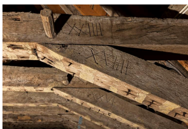
Détail de marques de charpentier sur la charpente du corps principal du couvent Phot. Yves Guillotin IVR52_20195300022NUCA
