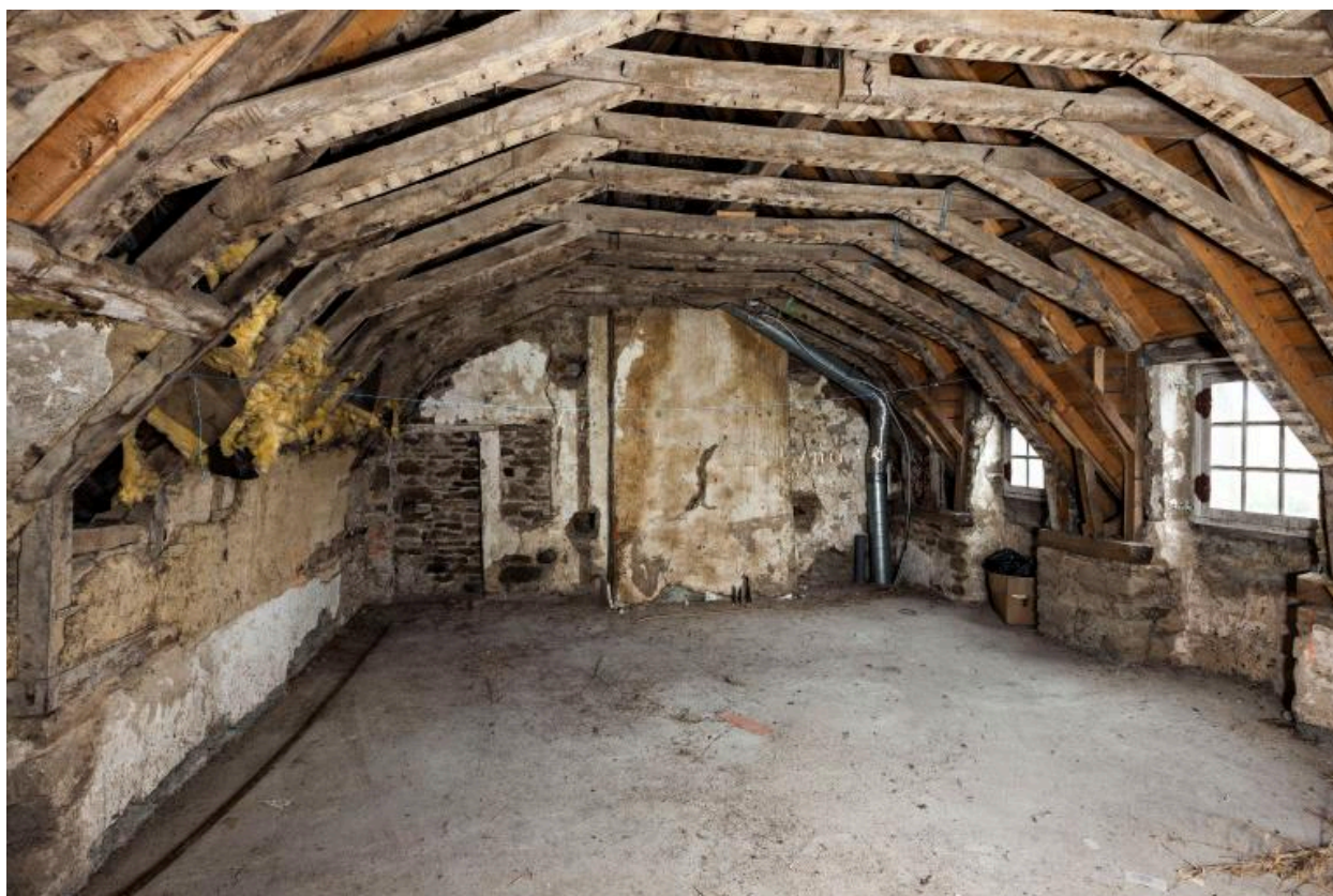
Charpente à chevrons-formant-fermes du corps principal du couvent, vue vers l'ouest
