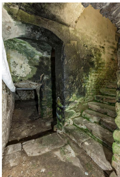
Entrée de la cave du corps principal du couvent et première volée de l'escalier ouest Phot. Yves Guillotin IVR52_20195300009NUCA
