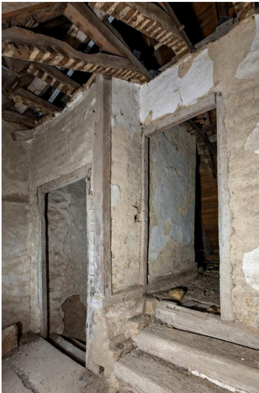
Cloison pan de bois séparant le dernier palier de la cage d'escalier
