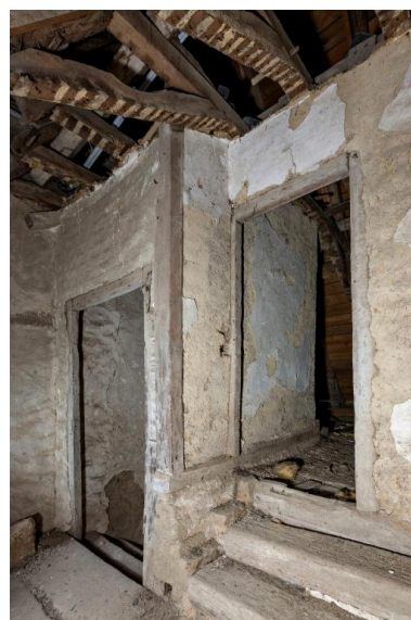
Cloison pan de bois séparant le dernier palier de la cage d'escalier Phot. Yves Guillotin IVR52_20195300019NUCA
