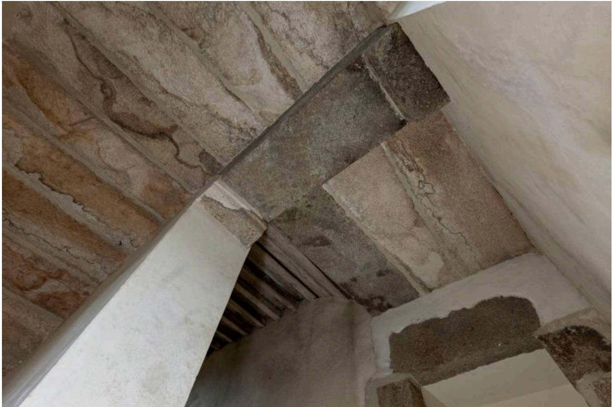
Corbeaux, premier niveau de l'escalier ouest du corps principal du couvent
