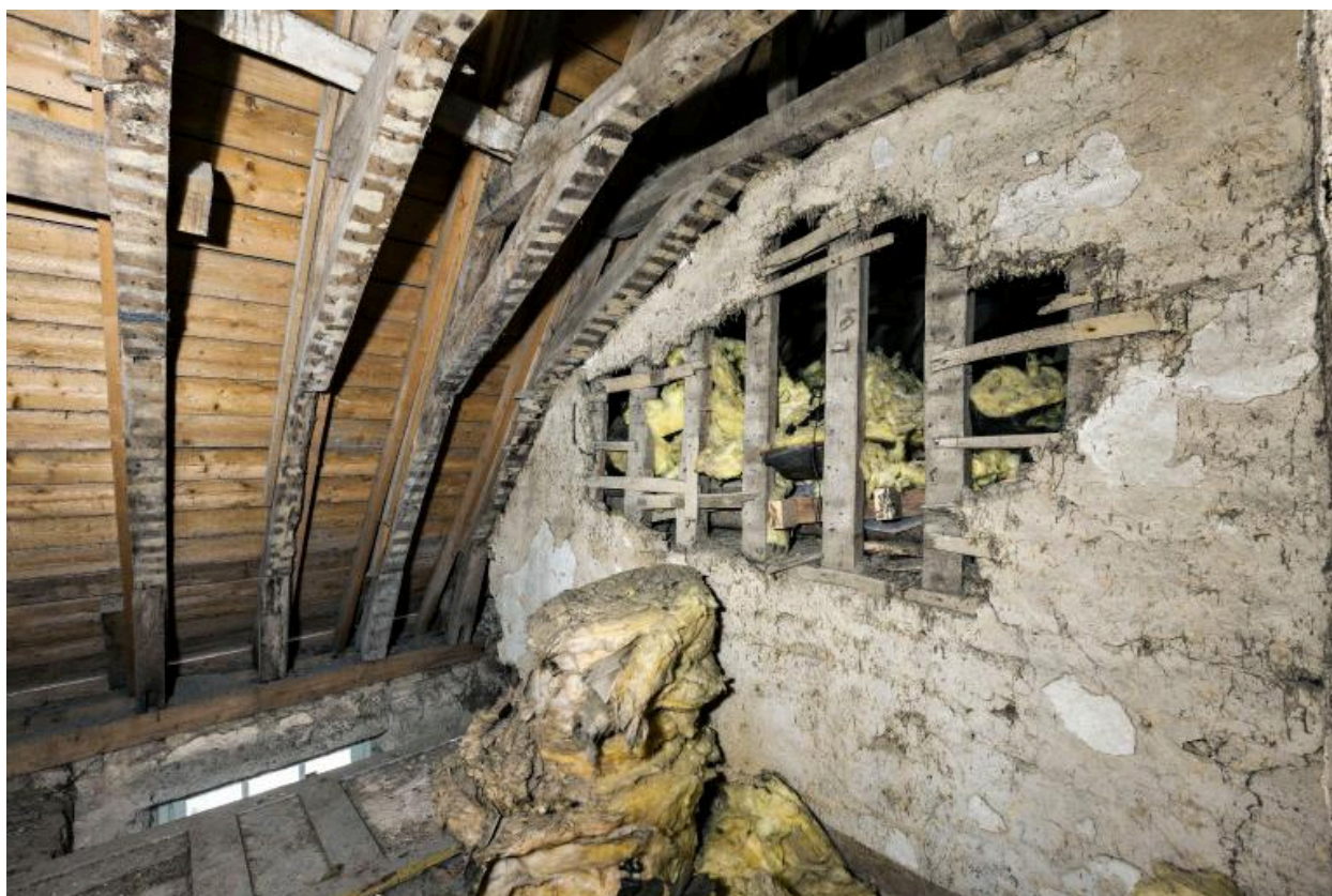
Détail de la charpente du bâtiment occidental et de la cloison en pan de bois séparant les bâtiments ouest et nord
