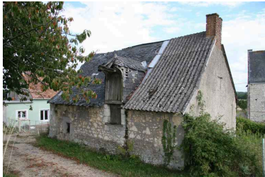
Anciennes dépendances : façade postérieure. Phot. Jean-Baptiste Darrasse IVR52_20057203230NUCA
