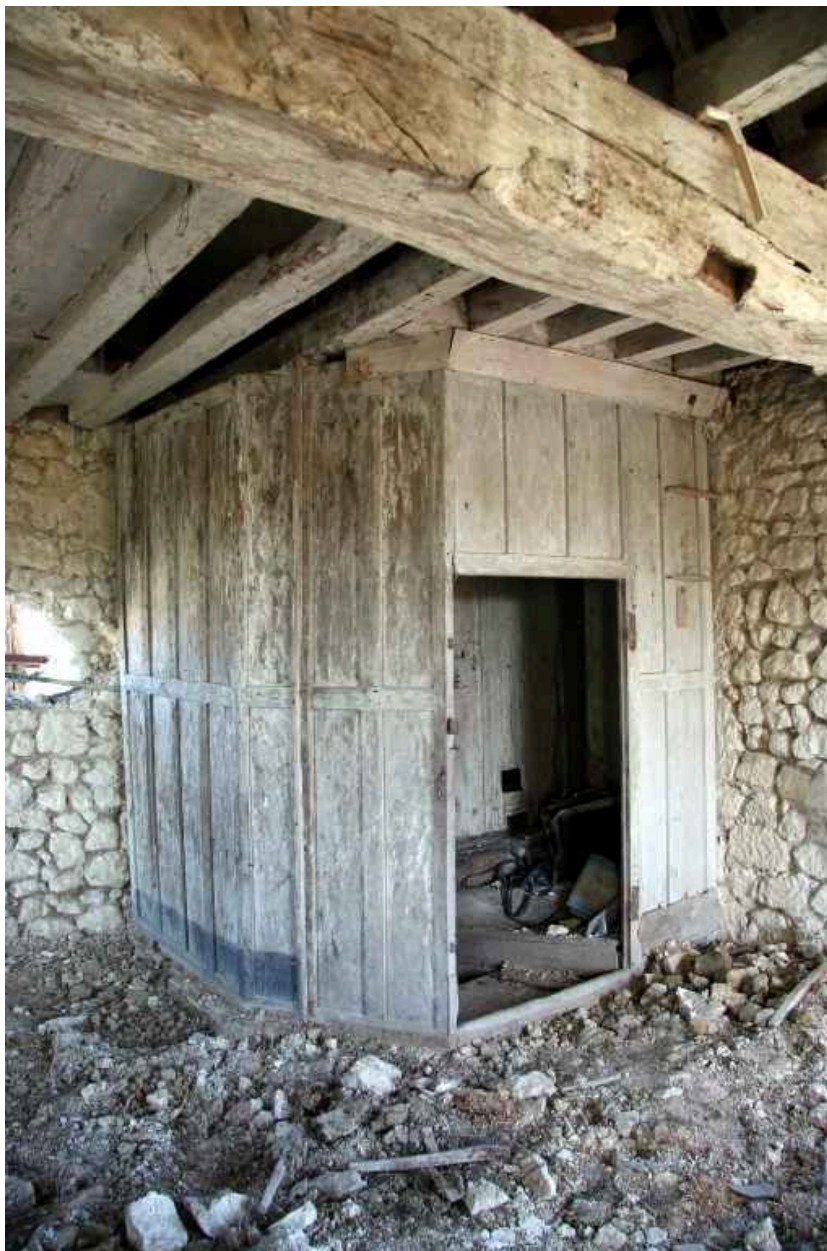
Cage d'escalier en bois : 1er étage.
