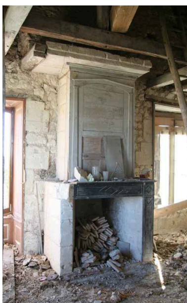
Premier étage : cheminée du XVIIIe siècle. Phot. Jean-Baptiste Darrasse IVR52_20057203567NUCA
