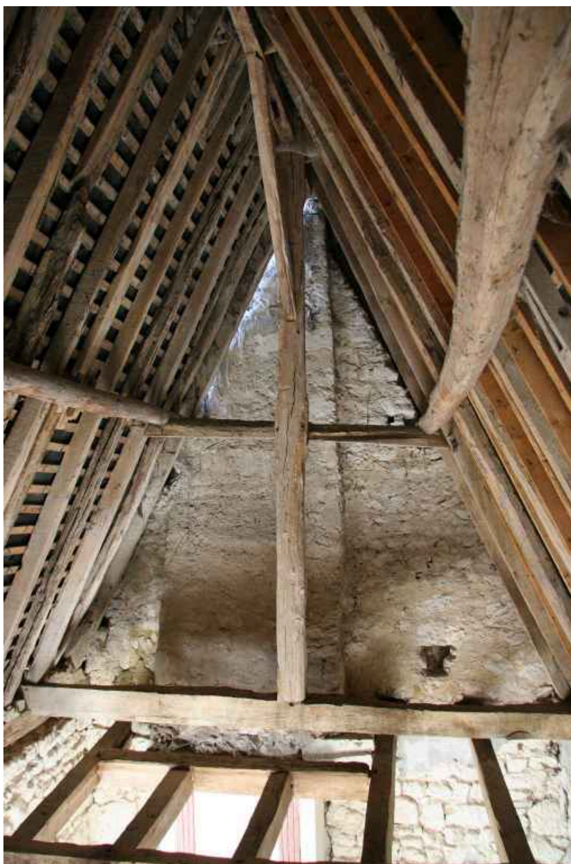
Charpente du corps de logis principal.
