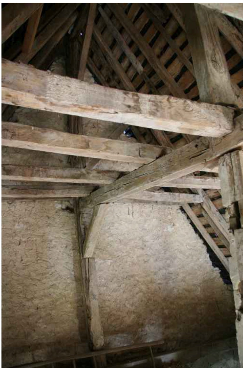
Corps de logis principal : sous-faîtage.
