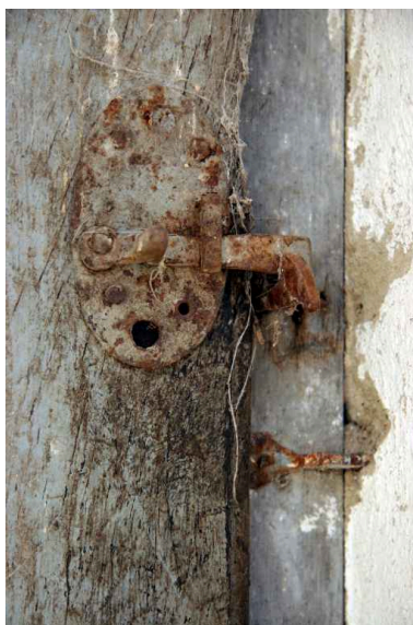
Aile basse, volet : targette. Phot. Jean-Baptiste Darrasse IVR52_20057203228NUCA
