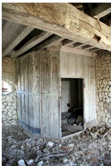
Cage d'escalier en bois : 1er étage. Phot. Jean-Baptiste Darrasse IVR52_20057203565NUCA
