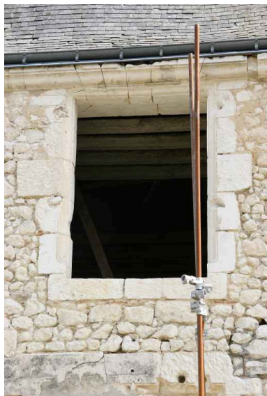
Vestige d'une croisée au premier étage. Phot. Jean-Baptiste Darrasse IVR52_20057203225NUCA
