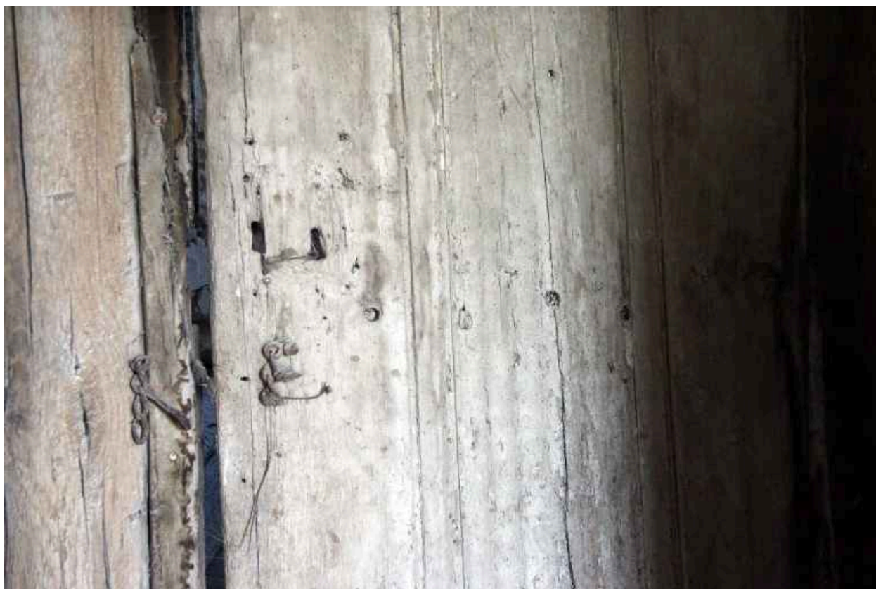
Cage d'escalier, porte du grenier : serrure.
