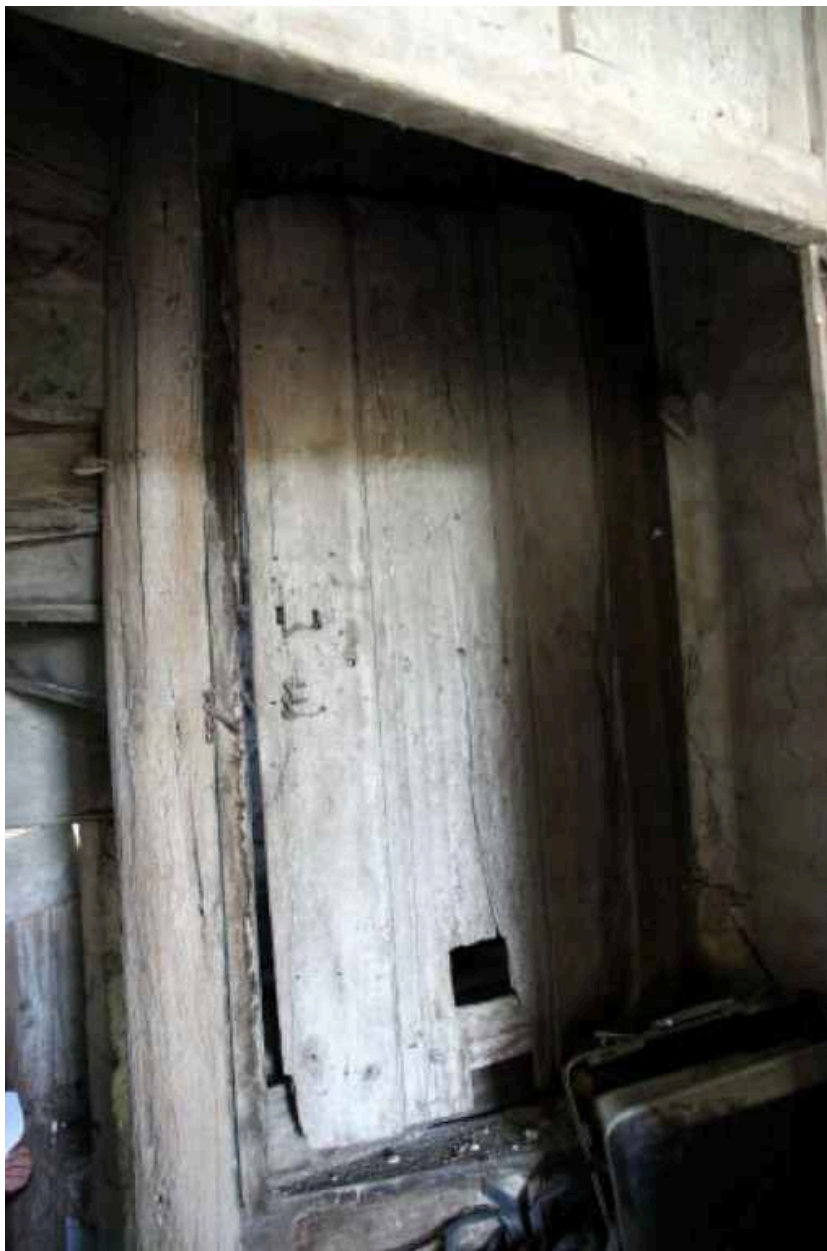
Cage d'escalier : porte du grenier.
