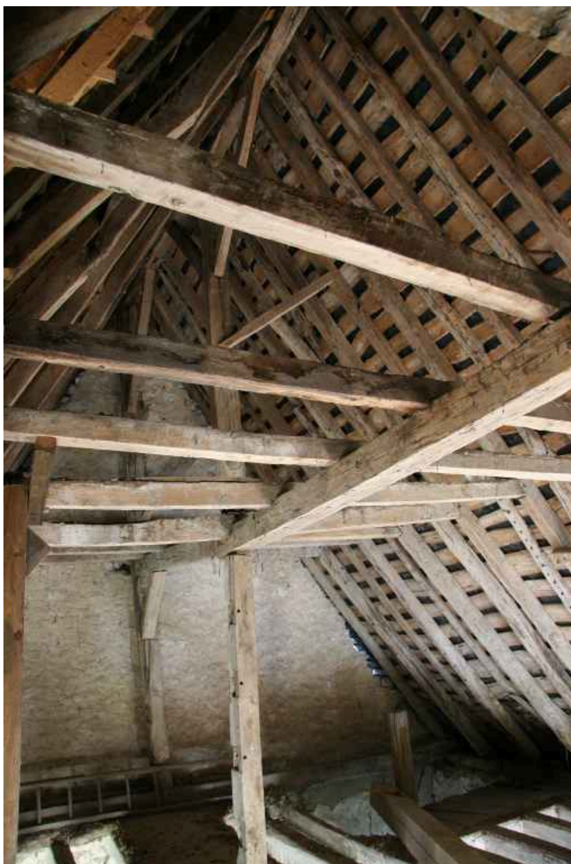
Charpente du corps de logis principal.
