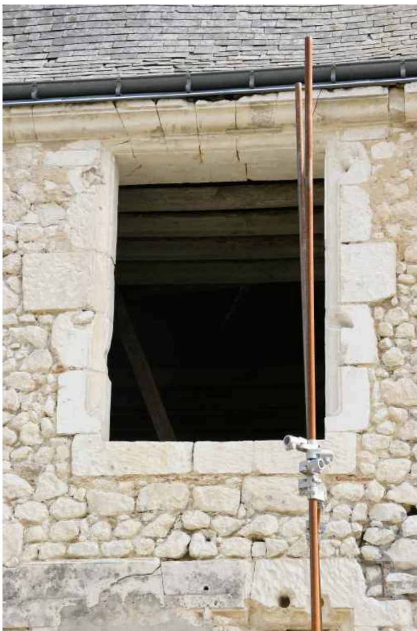
Vestige d'une croisée au premier étage.
