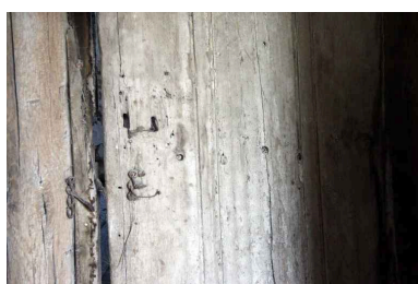
Cage d'escalier, porte du grenier : serrure. Phot. Jean-Baptiste Darrasse IVR52_20057203572NUCA
