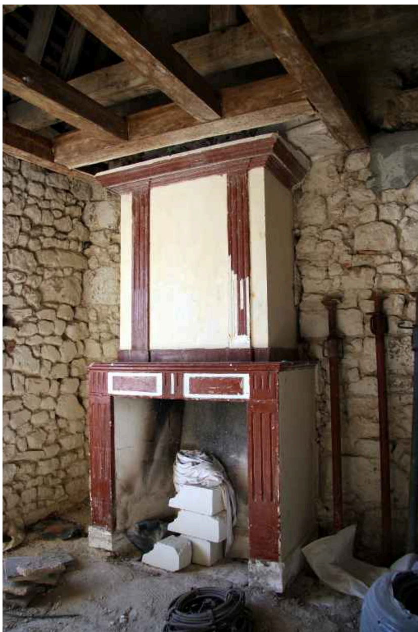
Aile en retour, premier étage : cheminée du XVIIIe siècle.
