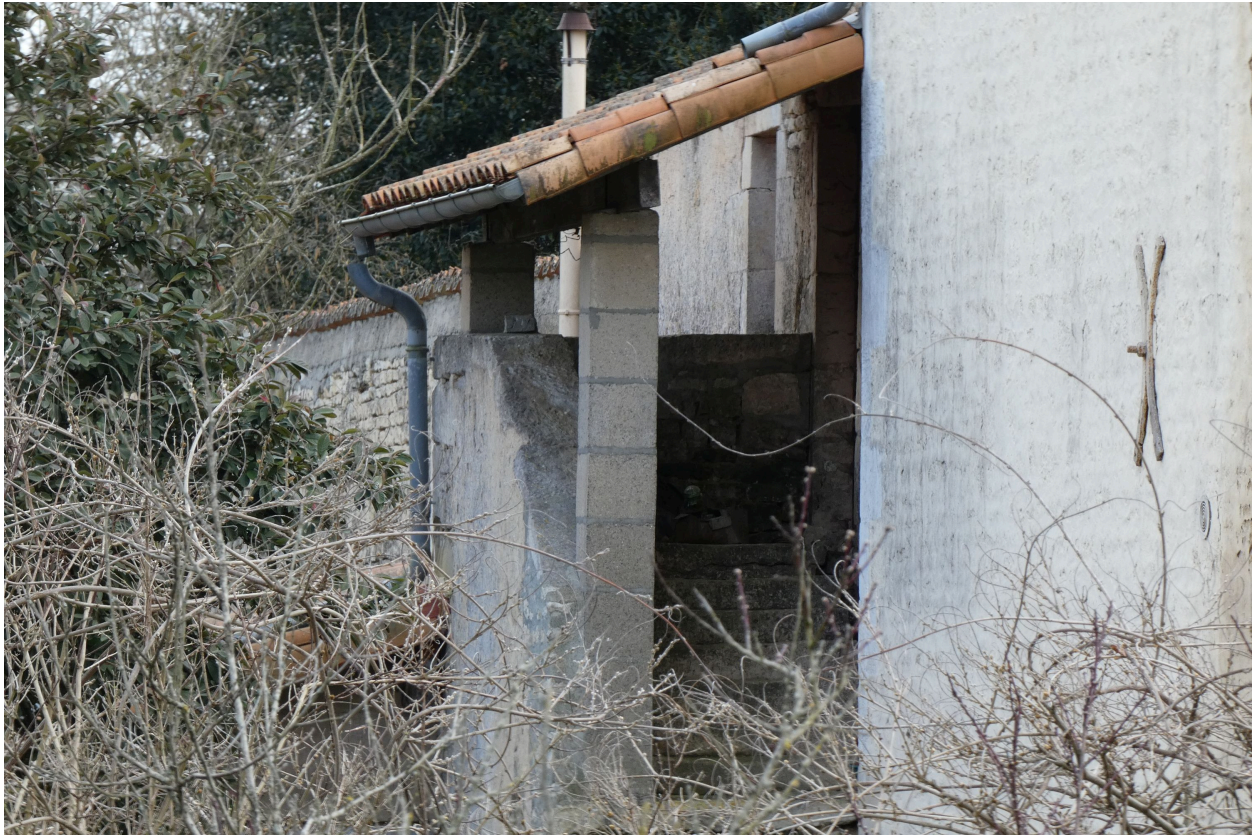
L'escalier extérieur à l'arrière des dépendances.
