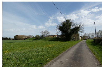
La propriété vue depuis l'ouest. Phot. Yannis Suire IVR52_20238501140NUCA
