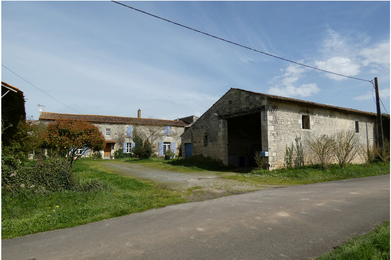
La cour, le logis et le hangar à l'entrée vus depuis l'ouest.
