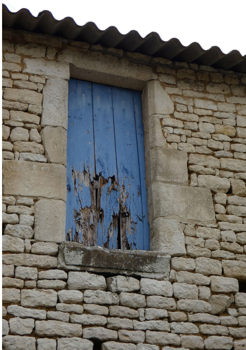
Baie haute et étroite, à encadrement chanfreiné et appui mouluré, à l'étage de l'aile est de communs, côté ouest.
