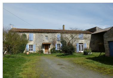
Le logis vu depuis le sud-ouest.
