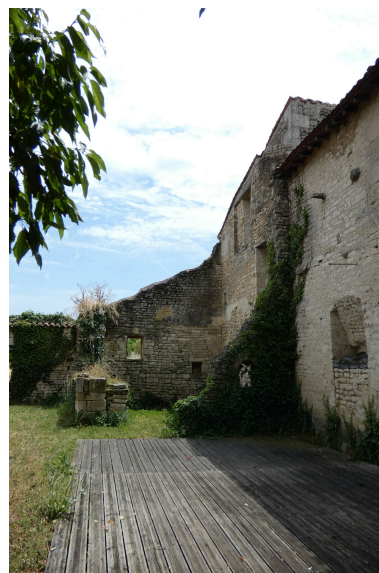
Les vestiges de la tour carrée nord-est, vus depuis le nord-ouest. Phot. Yannis Suire IVR52_20238501166NUCA
