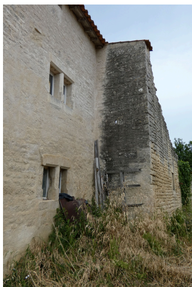
Jonction entre l'aile est de commons et la tour nord-est, vue depuis le sud.
