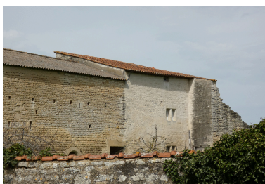
L'aile est, les vestiges de la tour nord-est et le corps de bâtiment avec toit en appentis qui les relie, vus depuis le sud-est.
