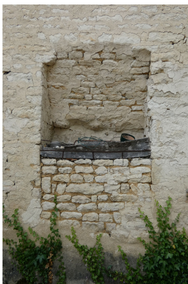
Ebrasement aménagé dans la façade nord du logis. Phot. Yannis Suire IVR52_20238501167NUCA
