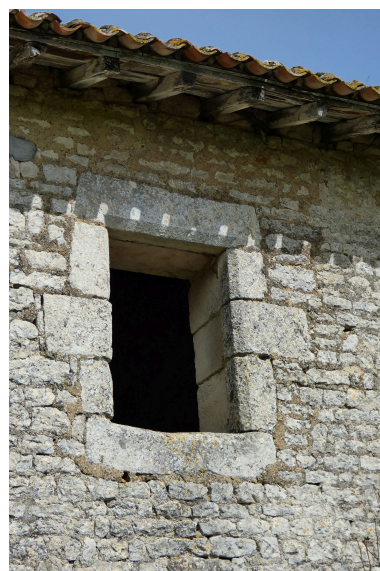
Baie à encadrement chanfreiné sur le mur sud du hangar au sud de la cour. Phot. Yannis Suire IVR52_20238501152NUCA
