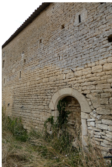
L'élévation est de l'aile est de communs, avec porte en arc en plein cintre, murée. Phot. Yannis Suire IVR52_20238501173NUCA
