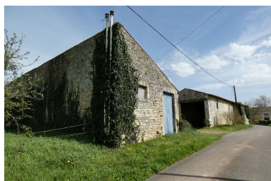
L'aile ouest de communs, reconstruite au 19e siècle, l'entrée de la cour et le hangar, vus depuis l'ouest. Phot. Yannis Suire IVR52_20238501141NUCA
