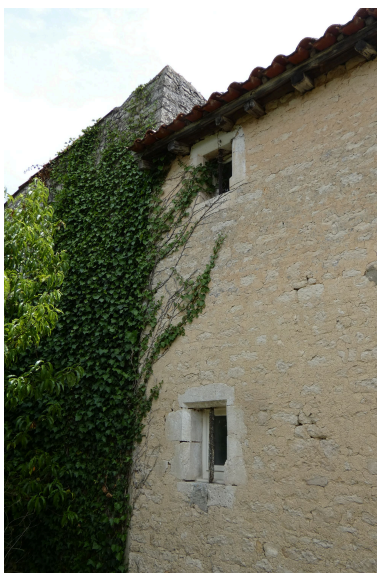
Baies à encadrement chanfreiné sur le mur pignon ouest du logis. Phot. Yannis Suire IVR52_20238501165NUCA
