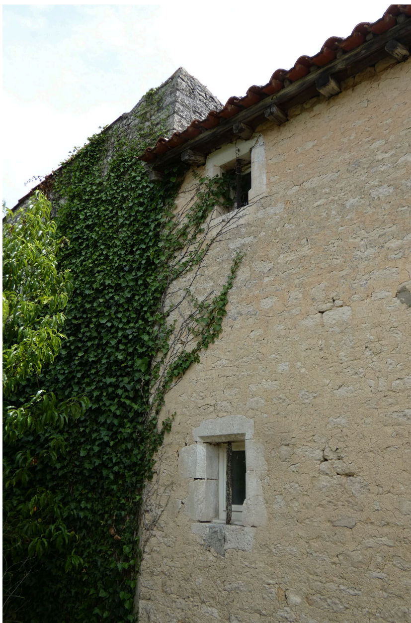
Baies à encadrement chanfreiné sur le mur pignon ouest du logis.
