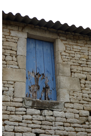
Baie haute et étroite, à encadrement chanfreiné et appui mouluré, à l'étage de l'aile est de communs, côté ouest. Phot. Yannis Suire IVR52_20238501179NUCA
