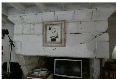
Cheminée à jambages en encorbellement, à l'intérieur du logis. Phot. Yannis Suire IVR52_20238501182NUCA
