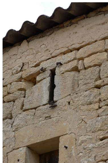
Meurtrière sur l'élévation est de l'aile est de communs. Phot. Yannis Suire IVR52_20238501175NUCA
