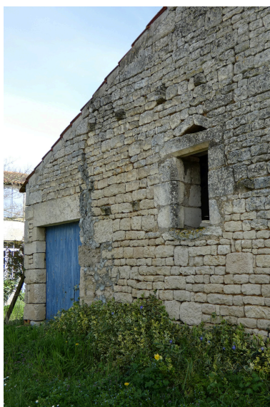
Ouvertures sur le mur pignon du hangar, dont une baie à encadrement chanfreiné. Phot. Yannis Suire IVR52_20238501144NUCA
