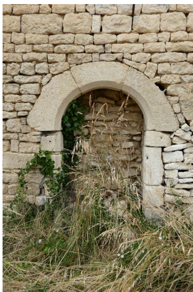
La porte en arc en plein cintre, murée, sur l'élévation est de l'aile est de communs. Phot. Yannis Suire IVR52_20238501174NUCA
