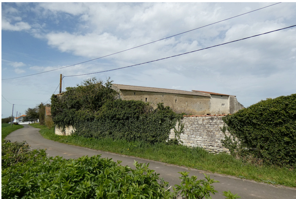
La propriété vue depuis le sud-est, avec à droite l'ancien jardin clos de murs.
