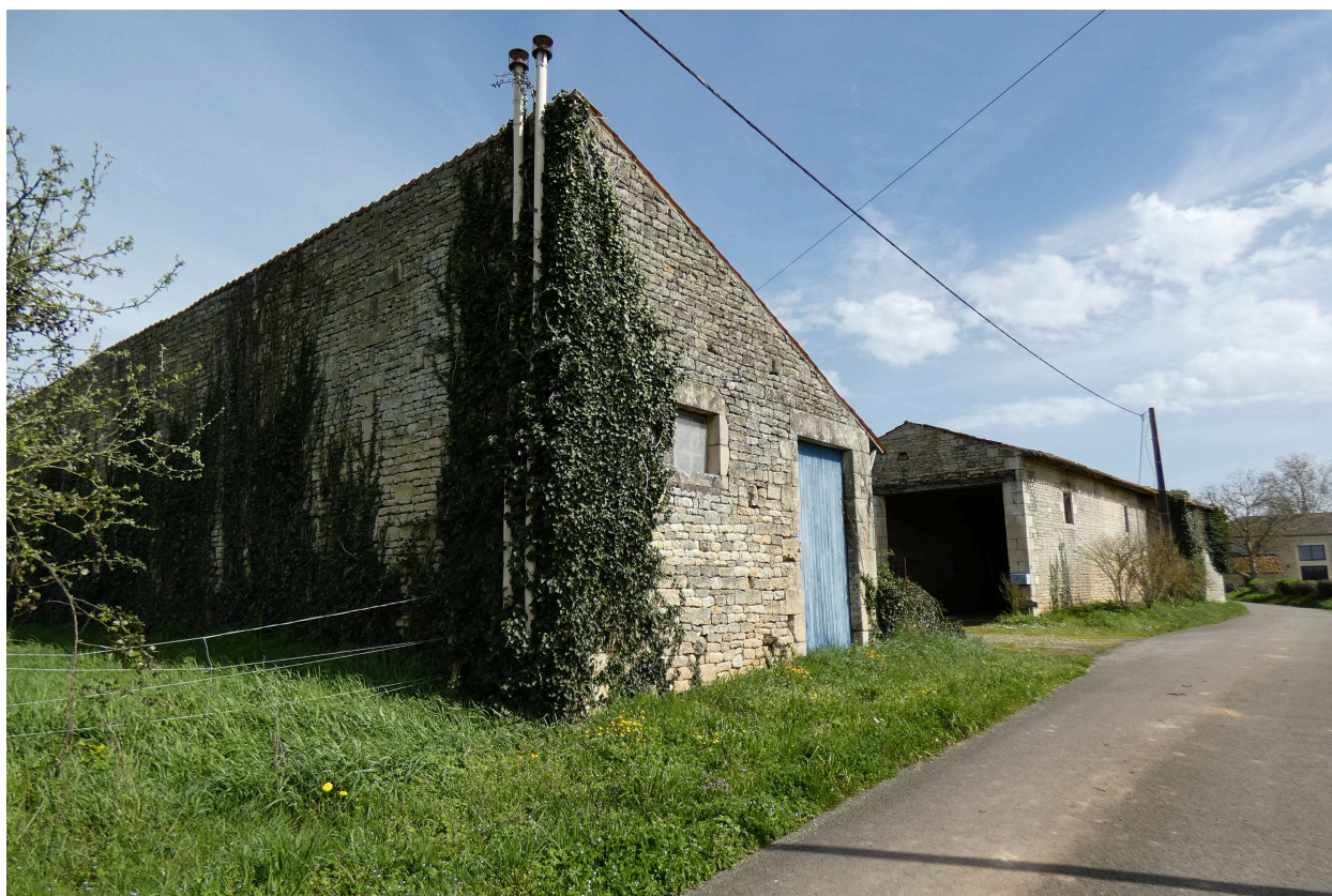
L'aile ouest de communs, reconstruite au 19e siècle, l'entrée de la cour et le hangar, vus depuis l'ouest.
