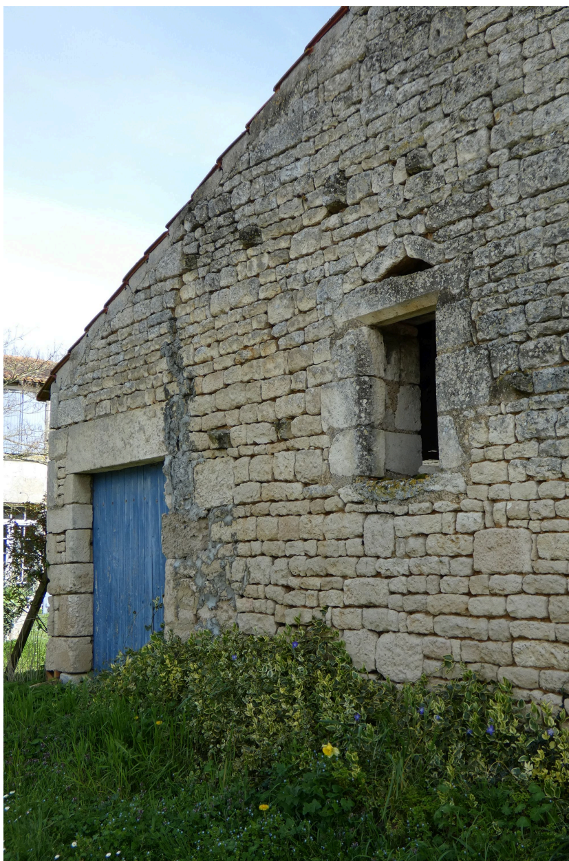
Ouvertures sur le mur pignon du hangar, dont une baie à encadrement chanfreiné.
