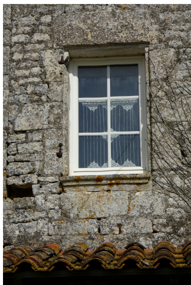
Baie à appui mouluré sur la façade sud du logis. Phot. Yannis Suire IVR52_20238501148NUCA
