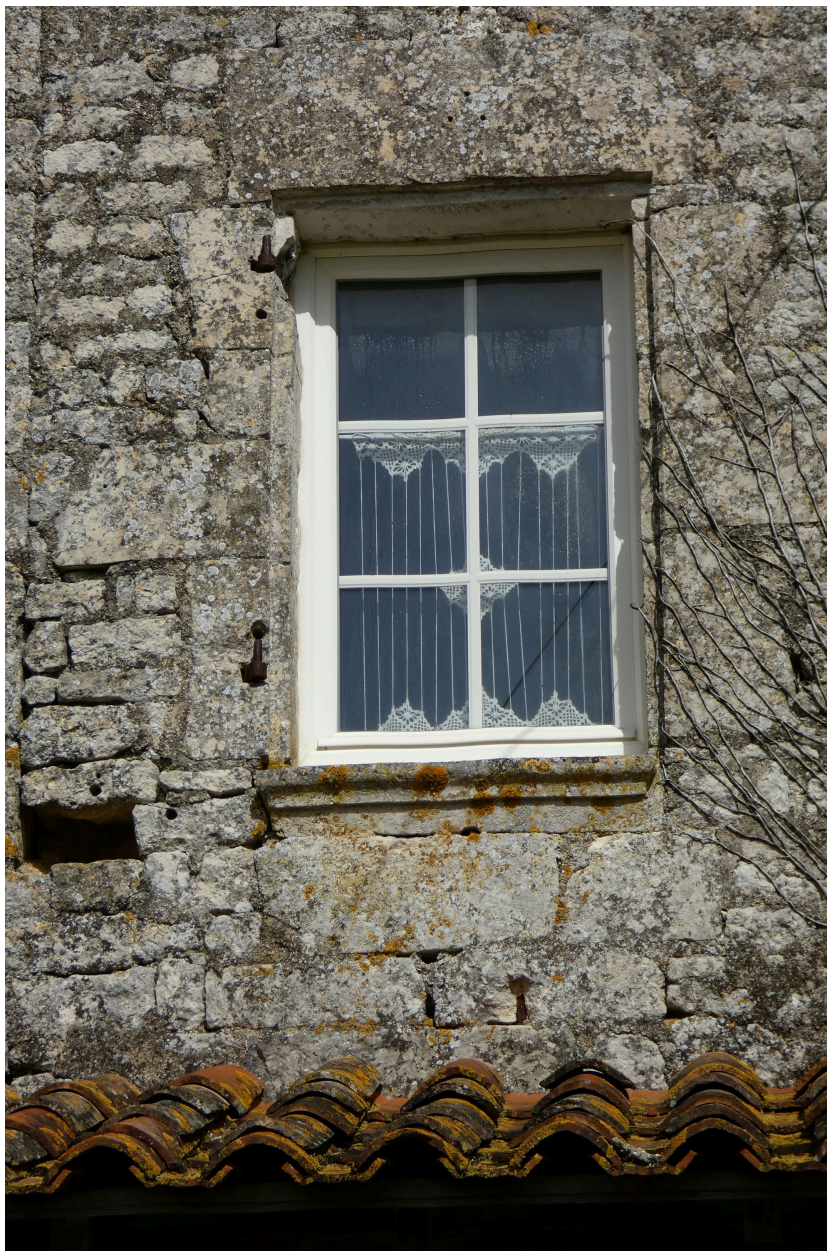
Baie à appui mouluré sur la façade sud du logis.
