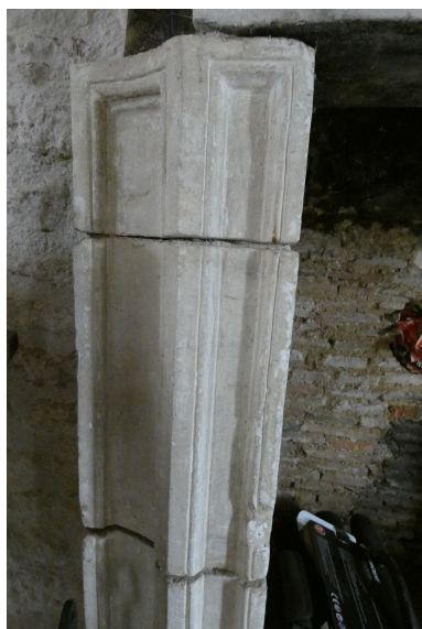
Détail d'une cheminée à l'intérieur du logis : montant mouluré. Phot. Yannis Suire IVR52_20238501181NUCA
