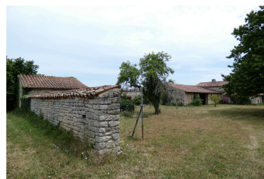
La cour nord vue depuis l'ouest. Phot. Yannis Suire IVR52_20238501170NUCA
