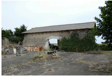
La grange au nord de l'ensemble, vue depuis le sud. Phot. Yannis Suire IVR52_20238501171NUCA
