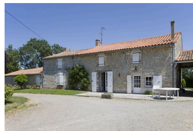
Façade ouest de la maison. Phot. Patrice Giraud IVR52_20098500365NUCA
