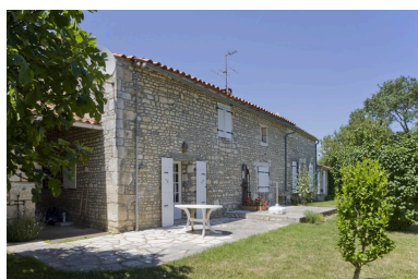
Façade est de la maison. Phot. Patrice Giraud IVR52_20098500362NUCA
