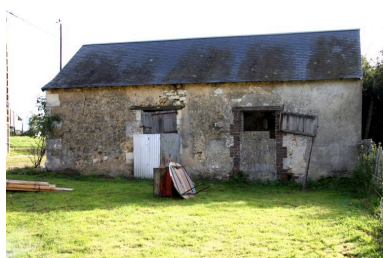
Toits à porcs. Phot. Jean-Baptiste Darrasse IVR52_20077201156NUCA
