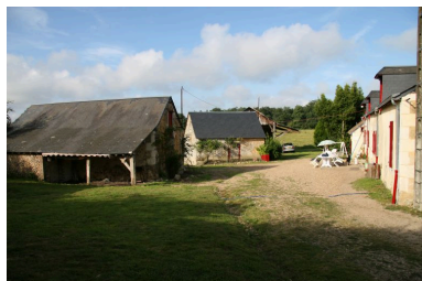
Vue d'ensemble de l'entrée de la cour. Phot. Jean-Baptiste Darrasse IVR52_20077201160NUCA
