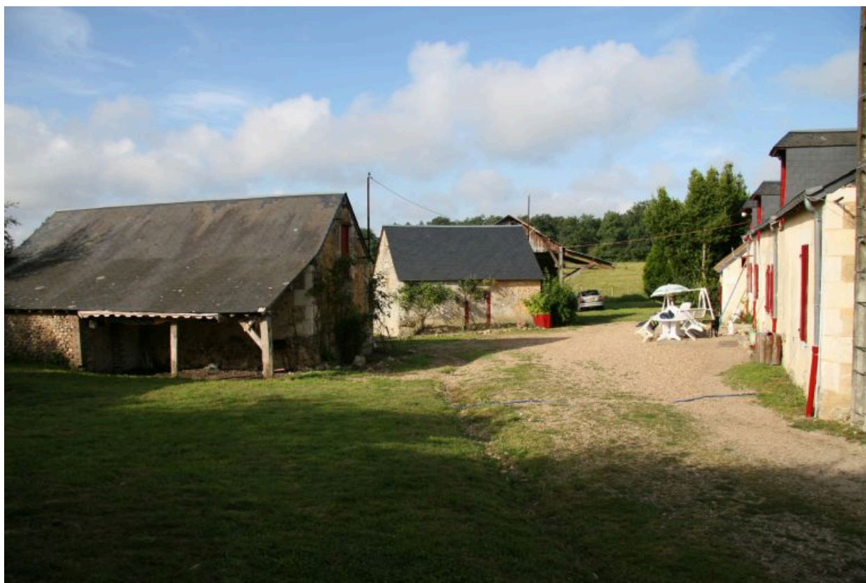
Vue d'ensemble de l'entrée de la cour.
