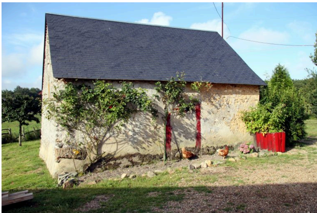
Petites écuries : façade antérieure.
