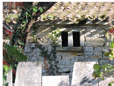
Boulins à pigeons. Phot. Yannis Suire IVR52_20218500565NUCA
