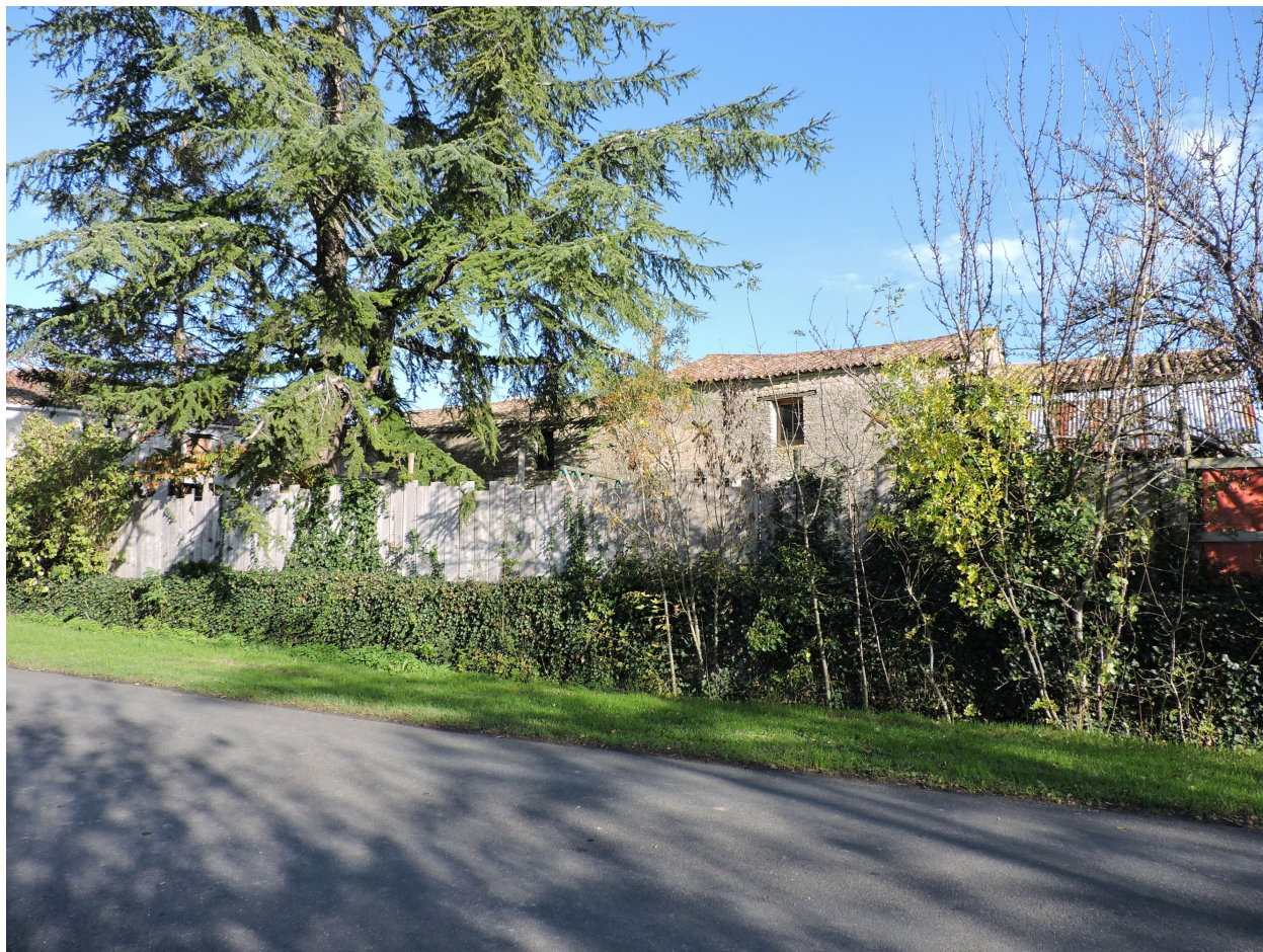
Les dépendances au sud du logis vues depuis l'ouest.
