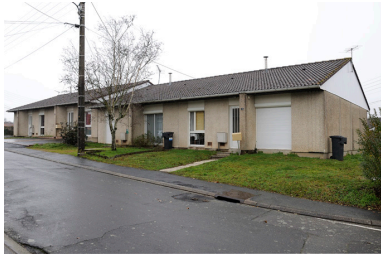
Lotissement du Puits Ragot, Les chalandonnettes. Phot. Bruno Rousseau IVR52_20114900268NUCA
