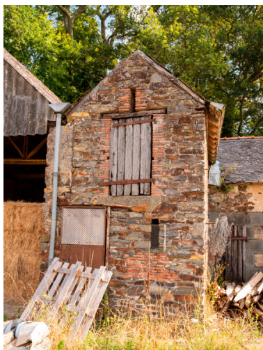
La ferme. Phot. Pierre-Bernard Fourny IVR52_20235300984NUCA
