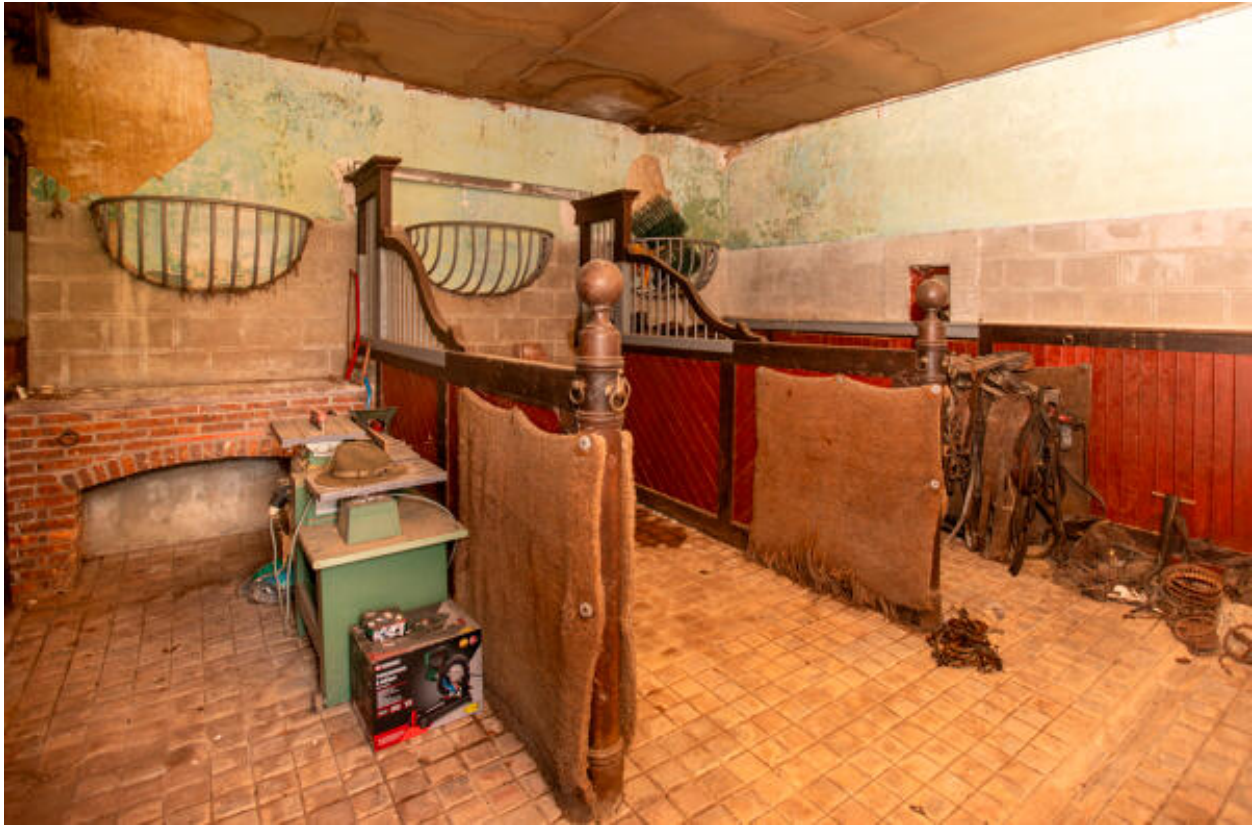
L'écurie-remise, les box.
