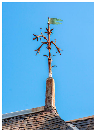
Un épi de faîtage. Phot. Pierre-Bernard Fourny IVR52_20235300976NUCA
