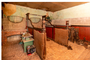
L'écurie-remise, les box. Phot. Pierre-Bernard Fourny IVR52_20235300959NUCA
