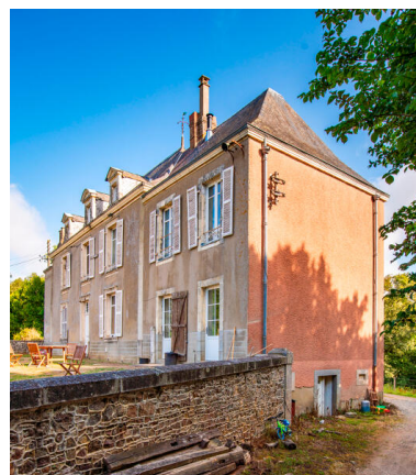
La demeure côté cour. Phot. Pierre-Bernard Fourny IVR52_20235300954NUCA
